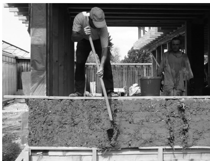
Abb.115: Baustellenfoto - Errichtung der Wände in Wellerbauweise
