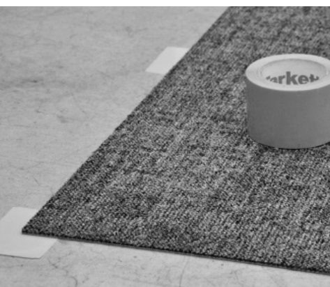
Abb.52: Schwimmende Verlegung von Teppichfliesen
