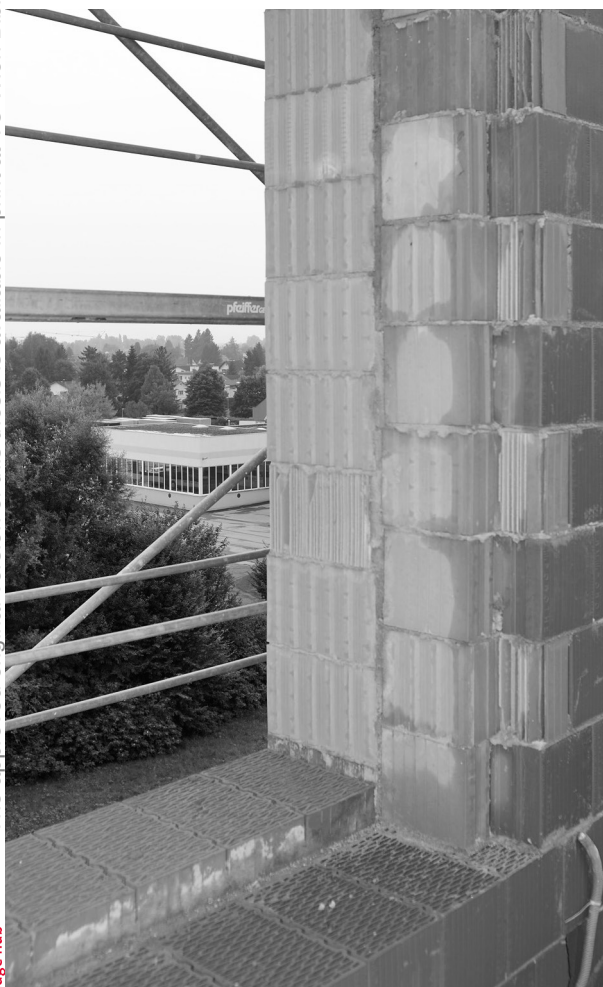
Abb.66: Außenwand im Rohbau
