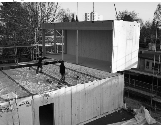
Abb.92: Innenraumansicht und Montage der Module
