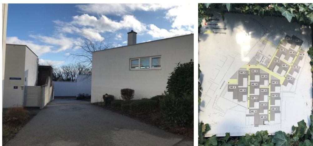
Abbildung 36: Wohnhausanlage in Krems Am Hundssteig (Quelle: Aufnahmen vom 11.01.2020)
