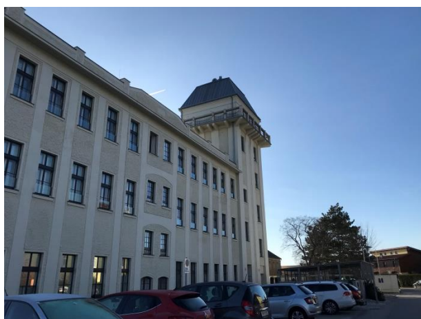
Abbildung 33: Sanierung Teesdorf Spinnerei (Quelle: Aufnahmen vom 06.01.2020)
