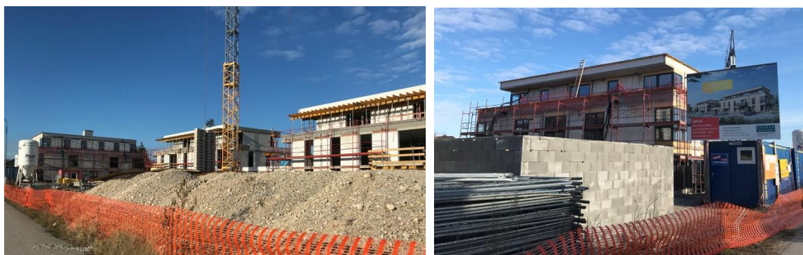
Abbildung 20: Wohnhausanlage in Theresienfeld Tonpfeifengasse (Quelle: Aufnahmen vom 06.01.2020)
