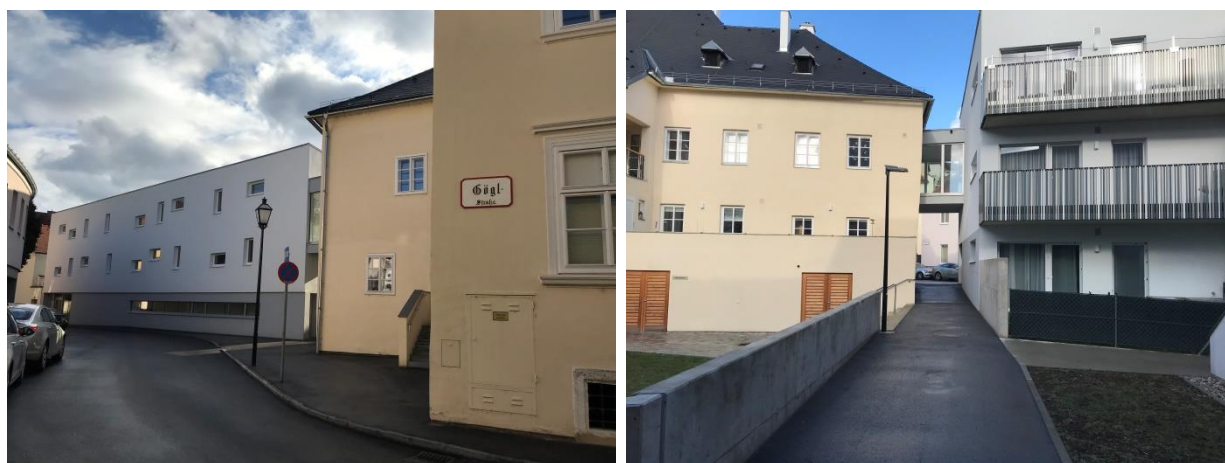
Abbildung 30: Sanierung Krems Sternhof (Quelle: Aufnahmen vom 11.01.2020)
