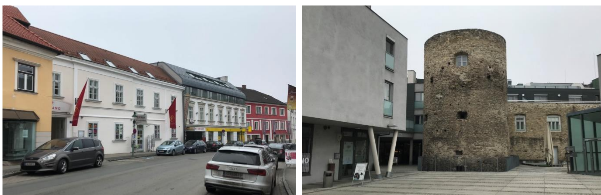
Abbildung 27: Sanierung Öhlnknechthof Horn (Quelle: Aufnahmen vom 25.01.2020)
