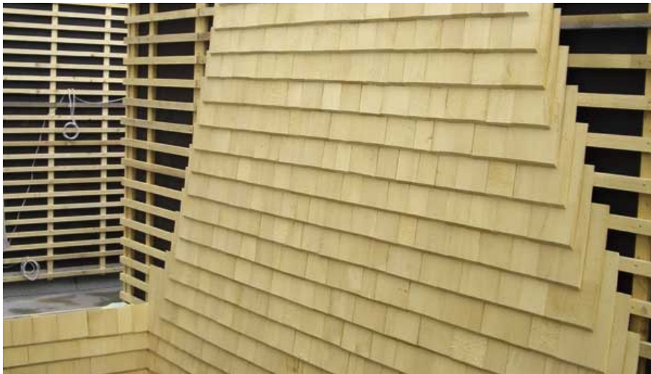
Abbildung 9-18: Holzschindeln als Fassadenbekleidung 140
