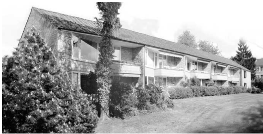
Abbildung 9-16: Bestand vor Aufstockung 134
