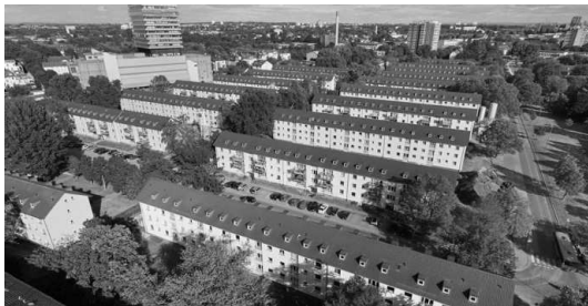
Abbildung 9-2: Bestand vor Aufstockung 115
