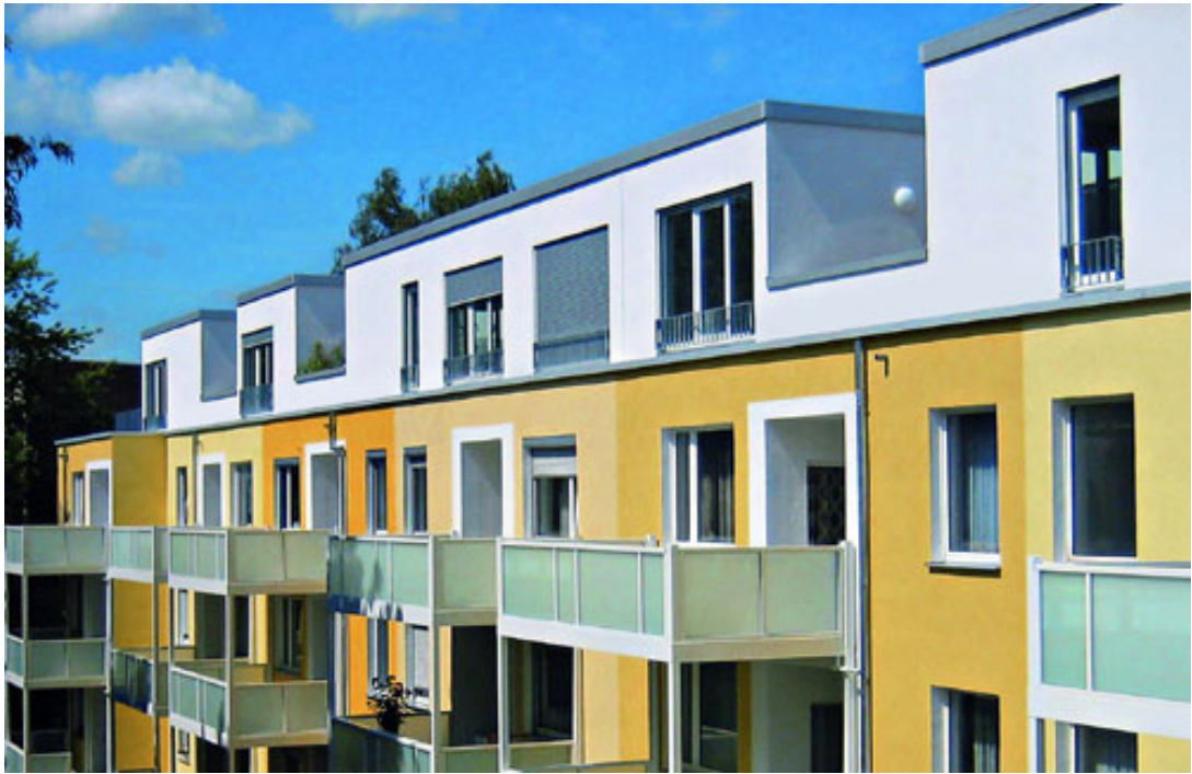
Abbildung 9-9: Aufstockung Praunheim, FFM 126
