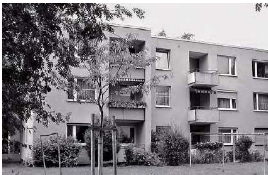
Abbildung 9-10: Bestand vor Aufstockung 127
