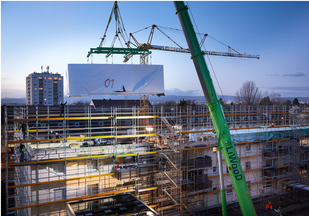
Abbildung 7-1: Aufstockung Platensiedlung in Holzmodulbauweise 55
