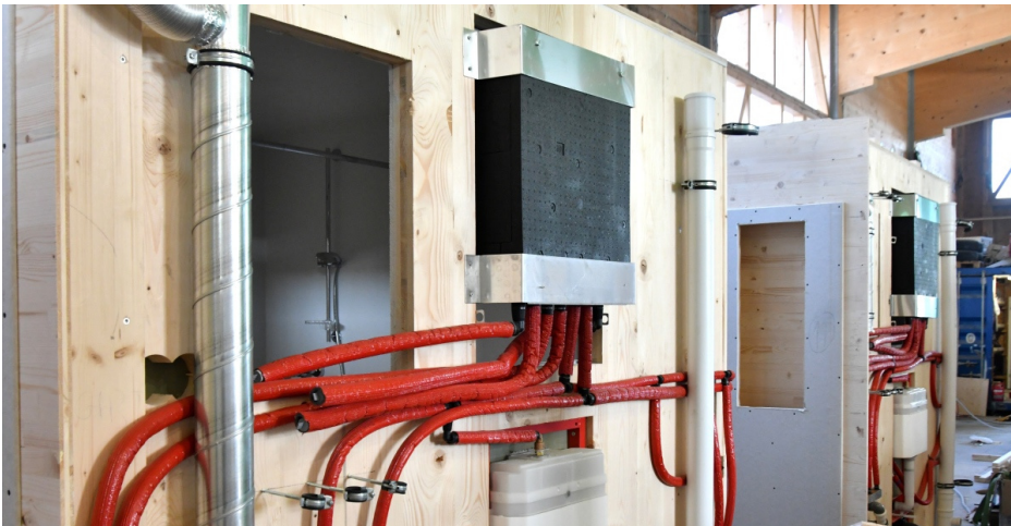
Abbildung 9-5: Raummodule mit 80% Vorfertigungsgrad 122
