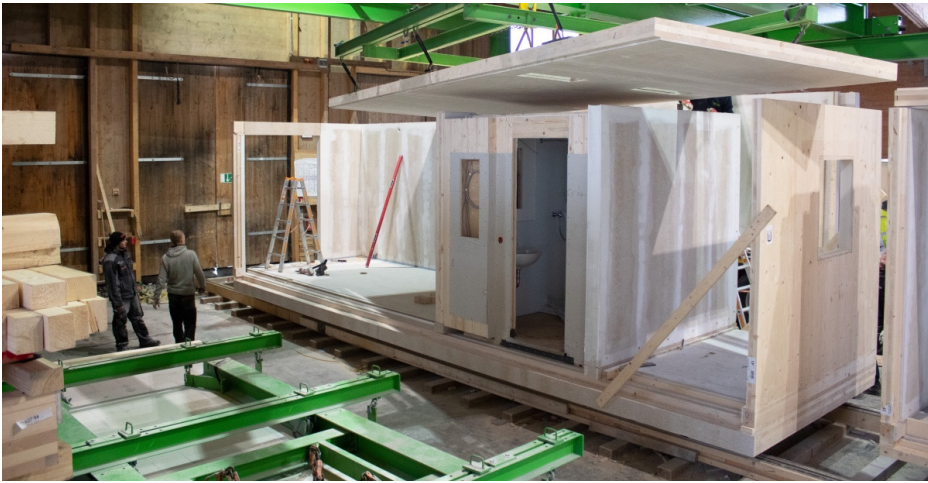
Abbildung 9-4: Fertigung der Raummodule in der Feldfabrik 121
