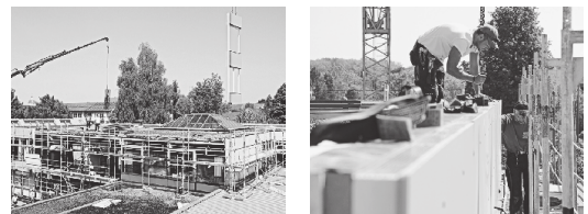
Die TES-Fassadenelemente ersetzen die alte Außenwand, sie sind raumabschließend: Peter-Schweizer-Volksschule Gundelfingen/D, Planung: lattkearchitekten
