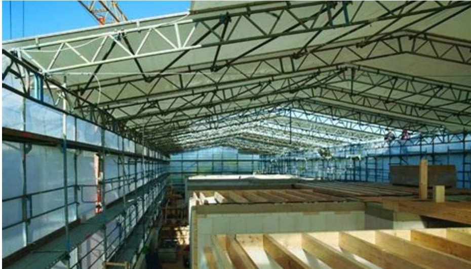
Abbildung 9-17: Einhausung als Witterungsschutz 139
