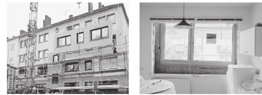
Die TES-Fassadenelemente werden vor die bestehende Fassade gehängt: Wohnhaus in der Schlägerstraße in Hannover/D, Planung: lattkearchitekten
