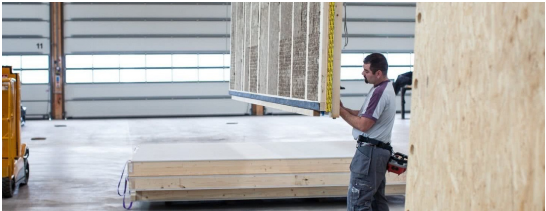
Abbildung 7-11: Holz-Leichtbauweise bei Renggli AG in Schötz 91
