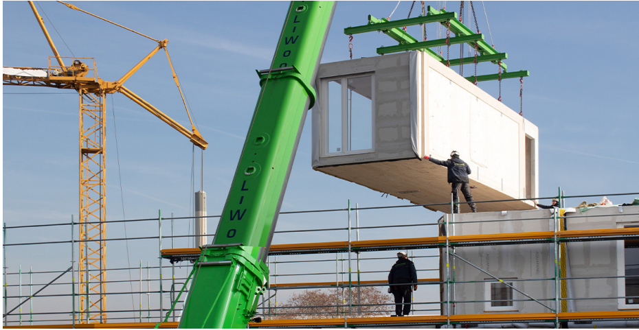
Abbildung 9-6: Versetzen der Raummodule 123
