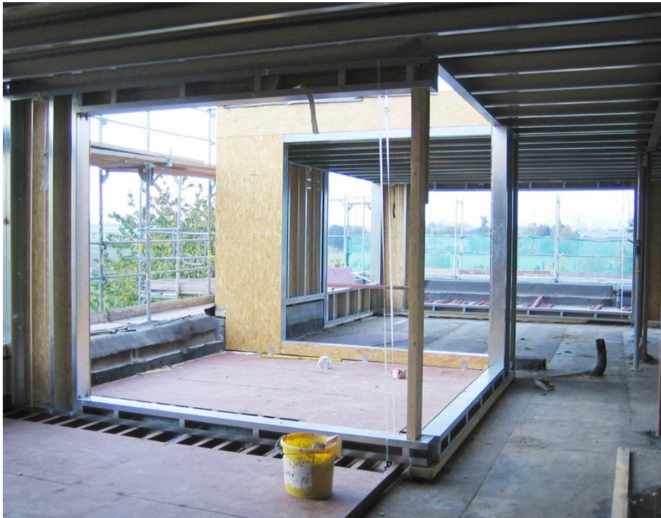
Abbildung 9-14: Lastverteilende Unterkonstruktion 132
