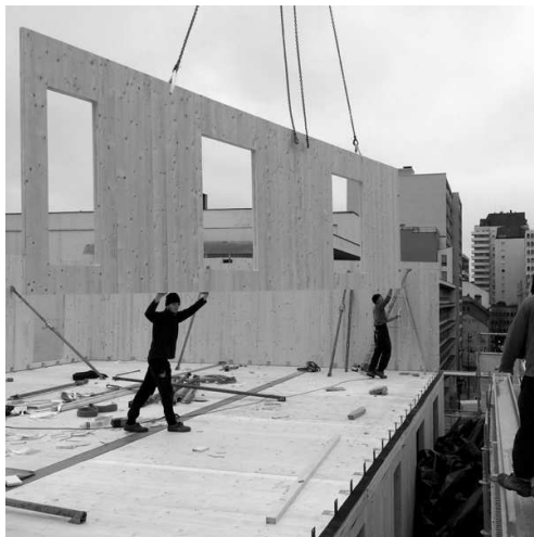
Abbildung 6-7: Aufstockung in Paris mit KLH-Platten 50
