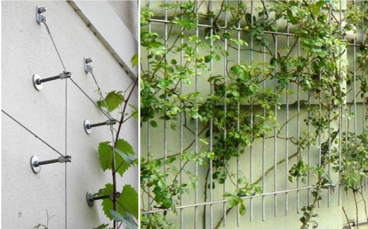
Abb. 41 links Abstandhalter für Drahtseile, rechts Rankgitter (Foto: Sven Taraba)
