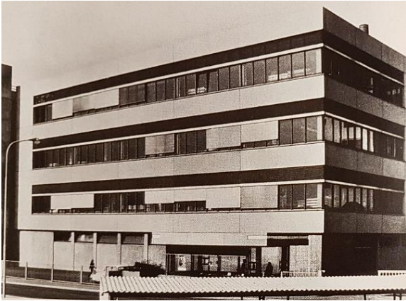
Abbildung 15: Rosenthal-Fabrik vor der Umgestaltung... (Hundertwasser 2018)
