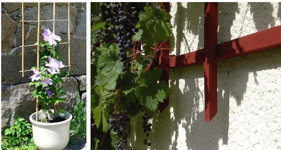
Abbildung 40: links Rankgitter aus Bambus mit Clematis; rechts Wandspalier aus Holz mit Wein (Quelle: www.fassadengruen.de )
