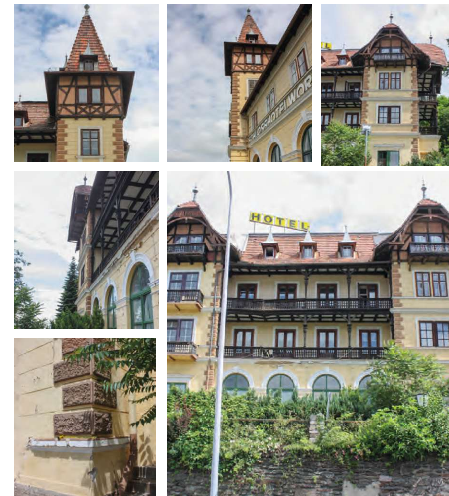
Südfassade (dem See zugewandte Seite)
