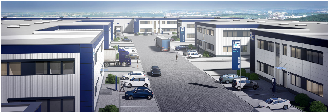
Abb. 8: City Dock (City-dock.de 2019)
