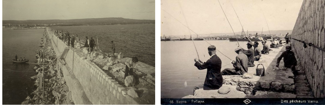
A.21,22 Der Bau des Hauptwellenbrechers des Hafens - 1895 - 1906
