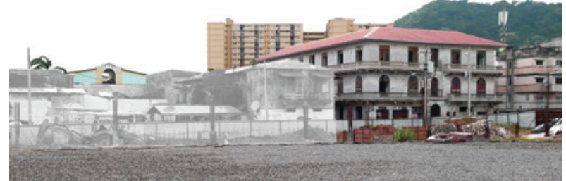
Abb. 152 - Freilegung Edificio Vaticano [PS, 2020]
