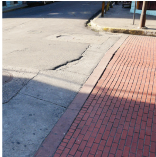
Abb. 81 - Ende des roten Straßenplasters, Av. A [PS, 2018]
