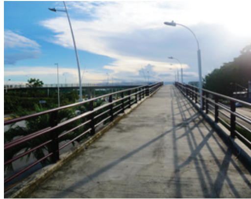
Abb. 76 - Rampe auf den Fußgängerübergang [PS, 2018]
