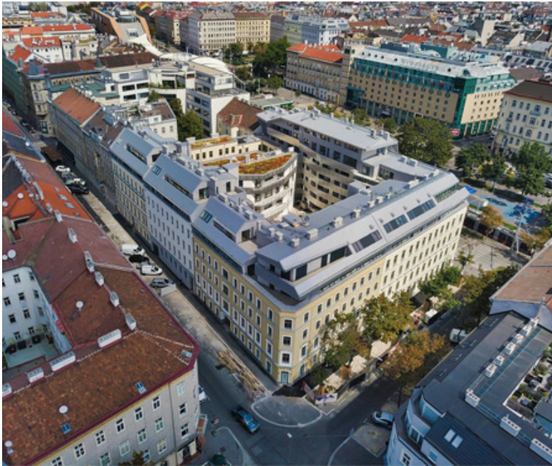
Abb. 07 - Blocksanierung, Goldschlaggasse 2-4 1150 Wien [Praschl-Goodarzi, 2019]
