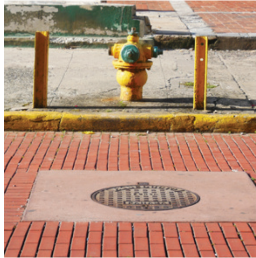
Abb. 82 - Detail Gehsteigkante, San Felipe [PS, 2018]
