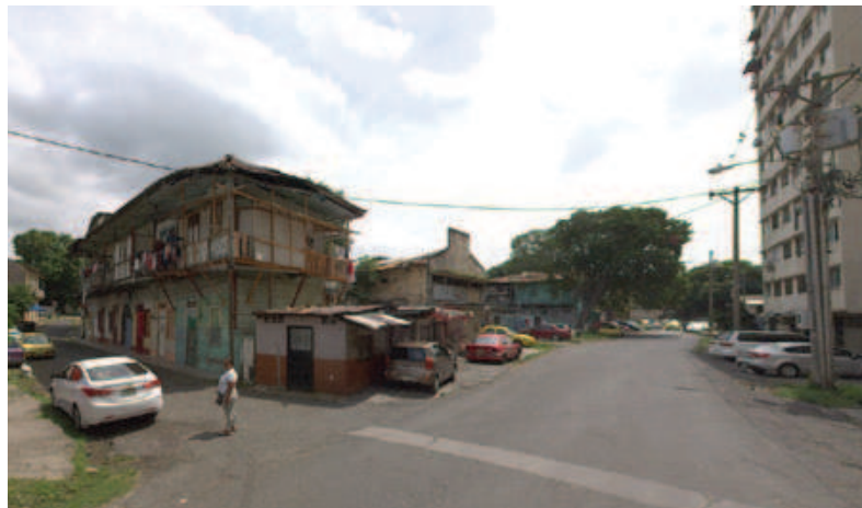
Abb. 110 - Ansicht Calle 20 de Diciembre Ecke Calle 17 Oeste [Viewscan360, 2015]
