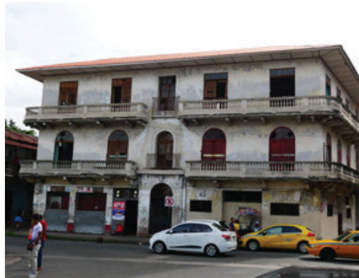
Abb. 136 - Edificio Vaticano, Calle 17 Oeste, [PS, 2018]
