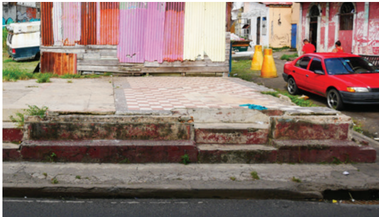
Abb. 69 - Verbliebene Fundamente, Calle 18 Oeste, El Chorrillo [PS, 2018]
