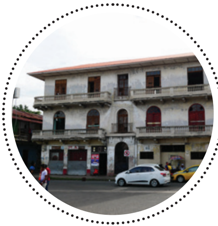
Edificio Vaticano Leerstehendes historisches Gebäude mit Wiedererkennungswert (Landmark)
