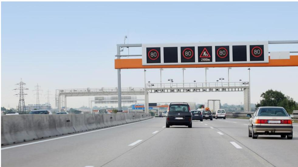
Abbildung 5.18: Verkehrsbeeinflussungsanlage auf der Autobahn. Quelle: Hammel, et al., 2018
