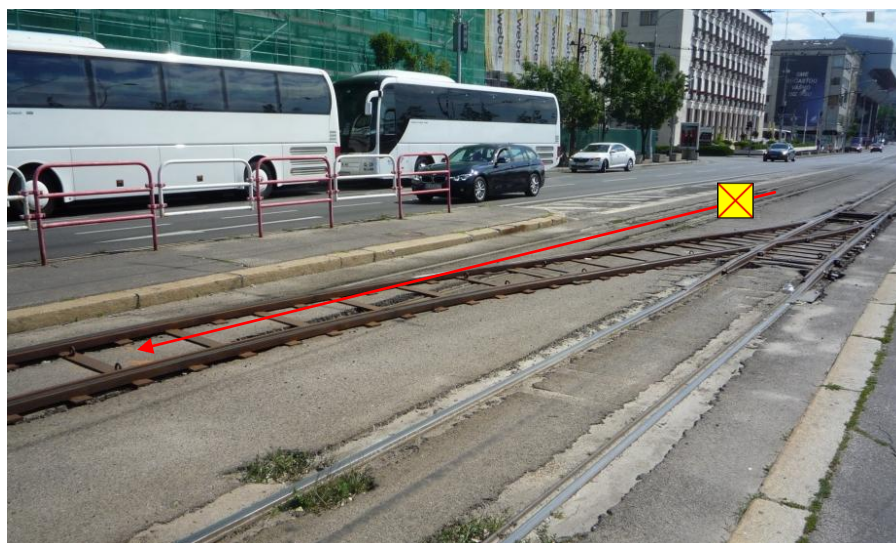
Abbildung 4.7: Kletterweiche im Einsatz beim Straßenbahnbetrieb der Stadt Bratislava (eigene Aufnahme, 2016)
