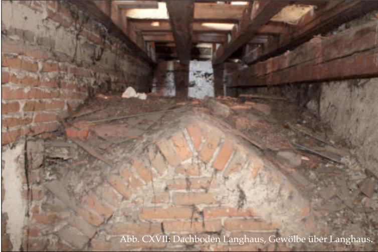
Abb. CXVII: Dachboden Langhaus, Gewölbe über Langhaus.
