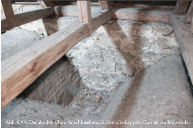
Abb. CXX: Dachboden Chor, Anschlussbereich Gewölbekappen Chor an Außenwände.
