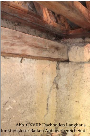
Abb. CXVIII: Dachboden Langhaus, funktionsloser Balken Auflagerbereich Süd.
