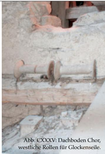
Abb. CXXXV: Dachboden Chor, westliche Rollen für Glockenseile.
