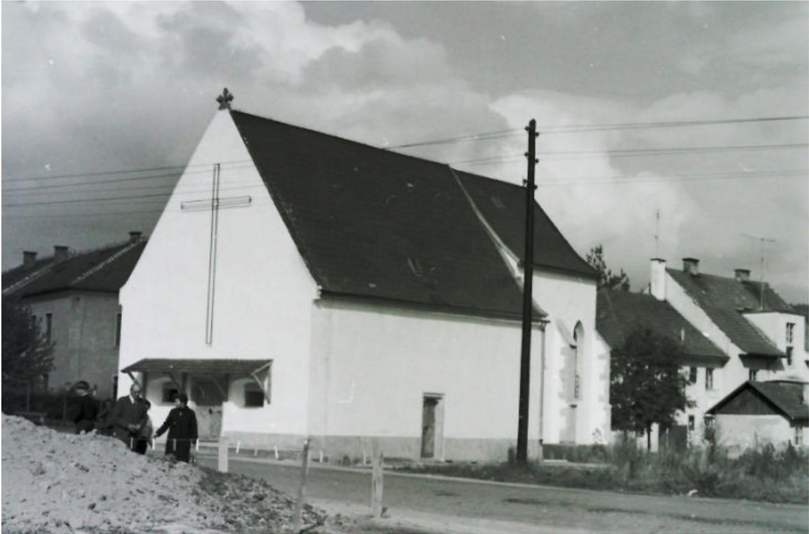
Abb. 51: Johanneskirche nach Sanierung, 1966-1968. Der Dachreiter wurde abgetragen und durch den Abbruch des Alten Spitalgebäudes ist nach Jahrhunderten die Südfassade freigelegt
