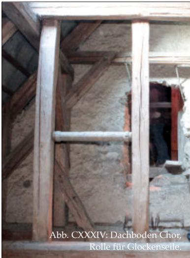
Abb. CXXXIV: Dachboden Chor, Rolle für Glockenseile.
