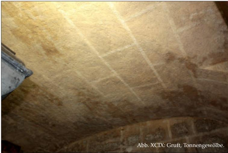
Abb. XCIX: Gruft, Tonnengewölbe.
