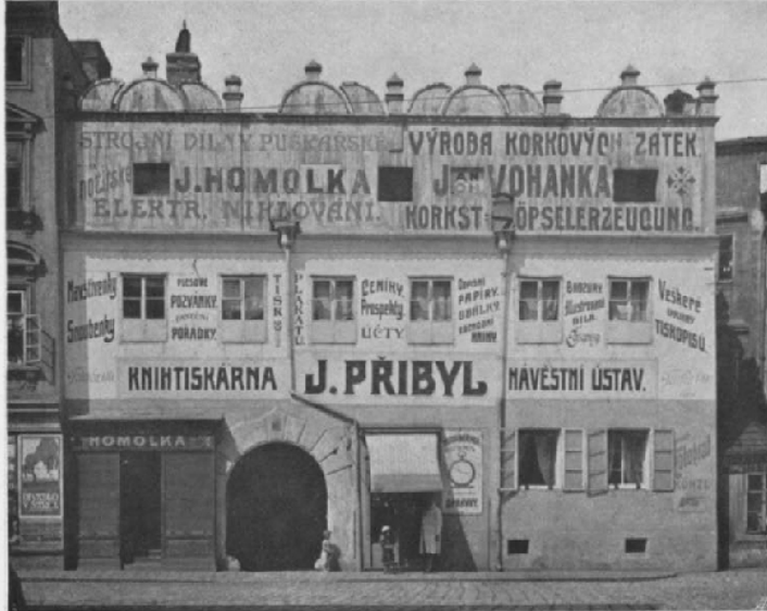
Abb. 15. Beispiel. — Altes Renaissancehaus in Budweis mit Reklameaufschriften verunstaltet, ein Beispiel der pietätlosesten Mißachtung eines alten Baues, der durch diese Verunzierung seine künstlerische Wirkung vollständig eingebüßt hat.
