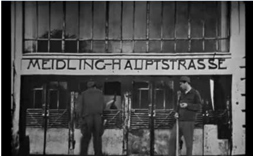
Abb. 23 Bauarbeiter demolieren die Stadtbahnstation Meidling-Hauptstraße.
