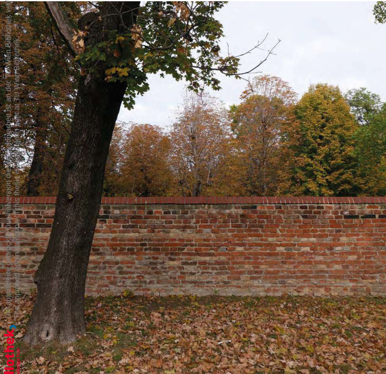
Abb. 69 Außenseite der Mauer als begleitendes Element
