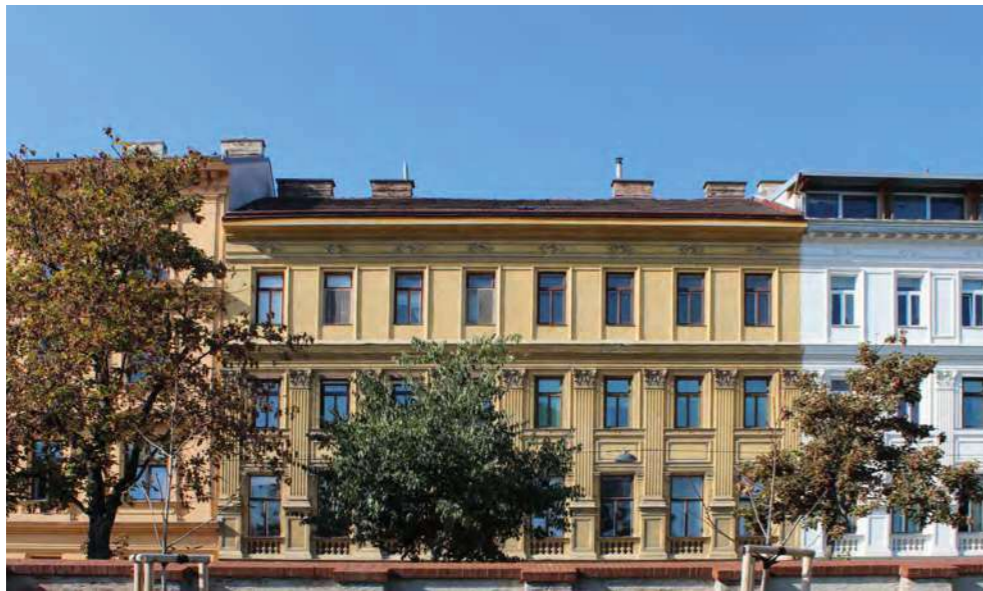
Abb. 55 Fassade zwischen Obere Augartenstraße und Obere Donaustraße
