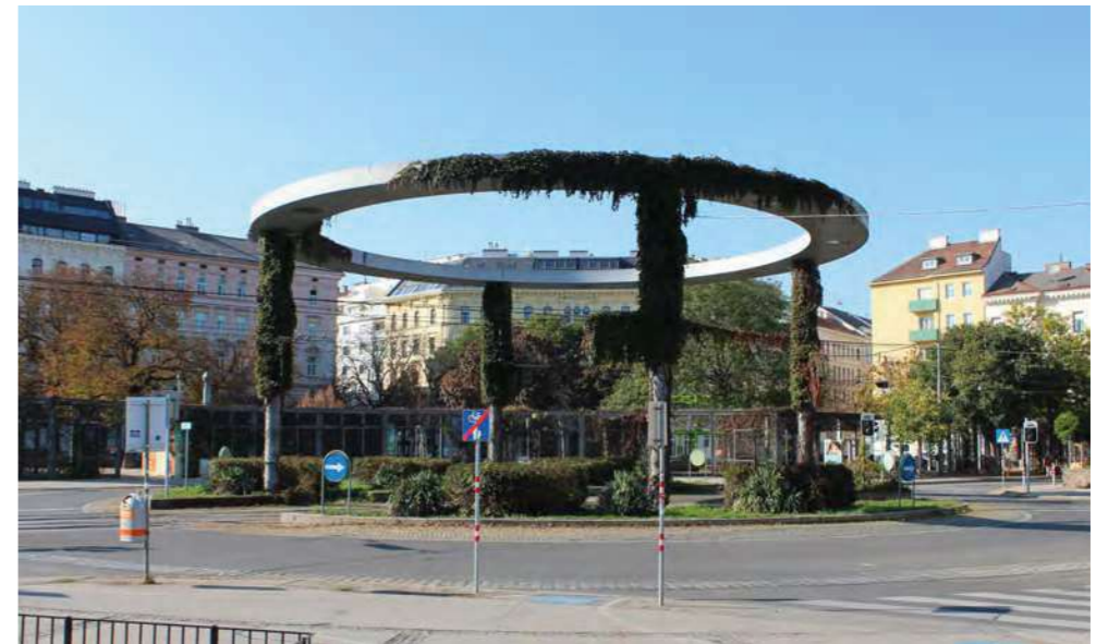
Abb. 60 Blick auf den Bauplatz
