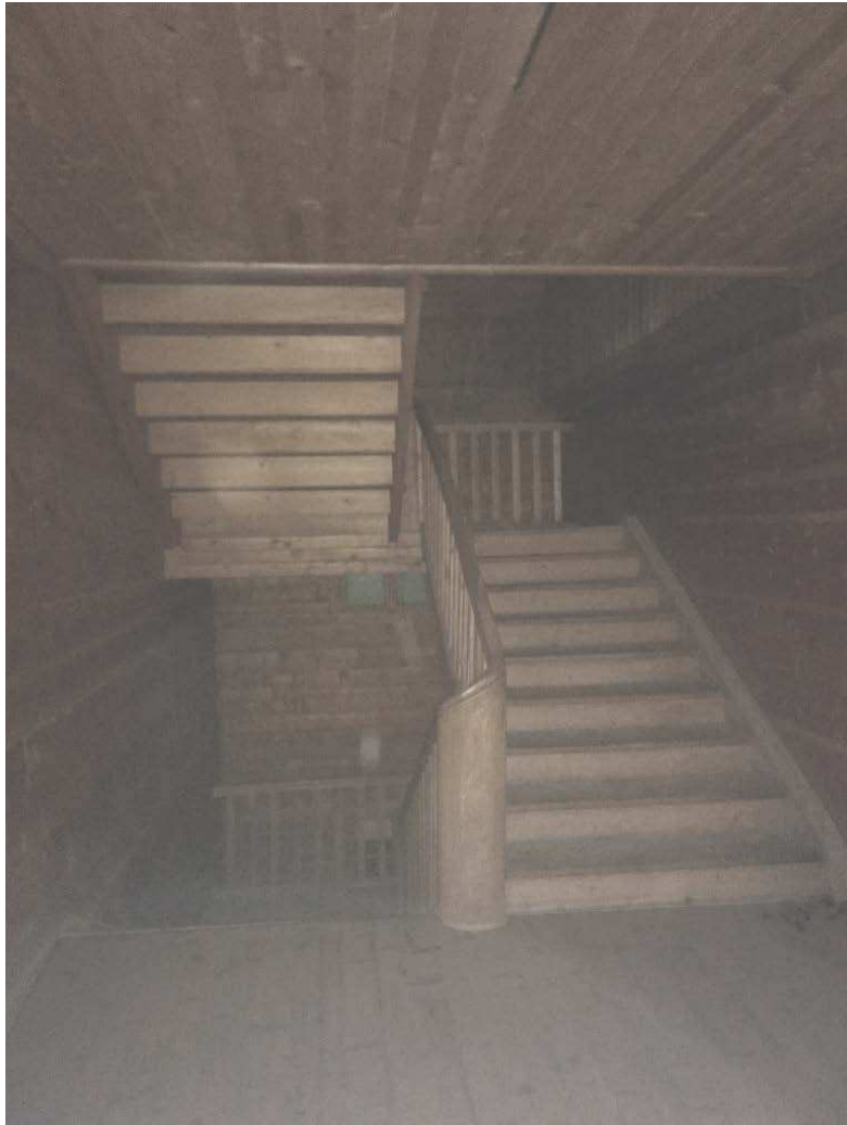
Abb.35: Treppenlauf im Obergeschoss
