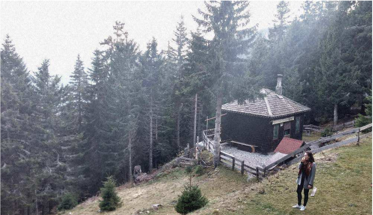
Abb.20: Ferienkolonie Regina Elena : Blick auf den Pavillon südlich des Hauptgebäudes
