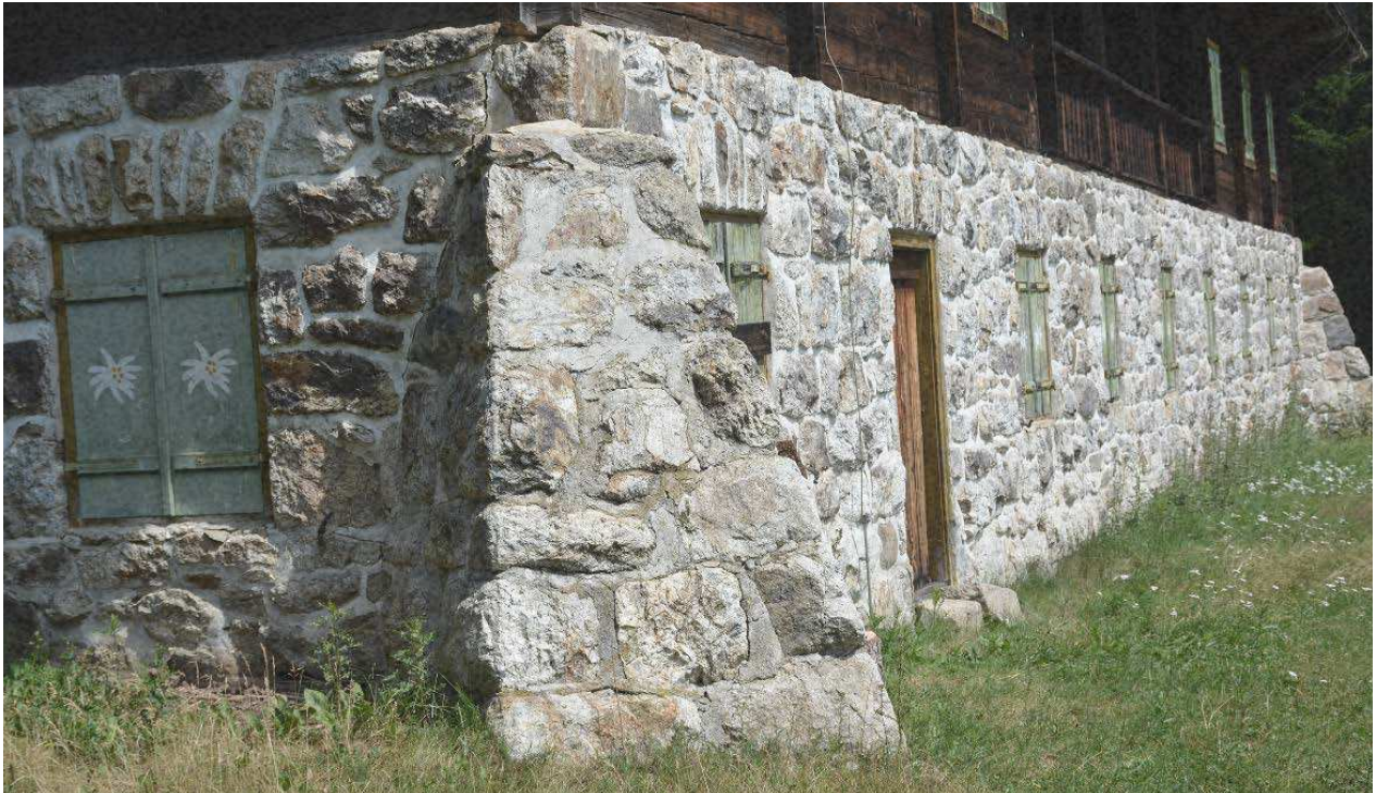
Abb.25: Eckverstärkung des gemauerten Sockels
