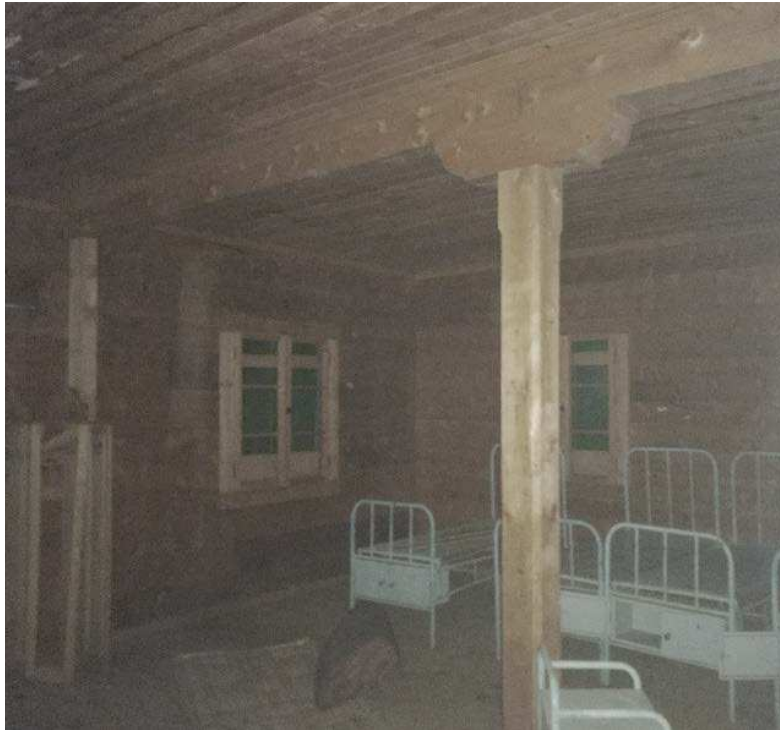
Abb.28: Holzstütze mit Schulterholz im Schlafsaal
