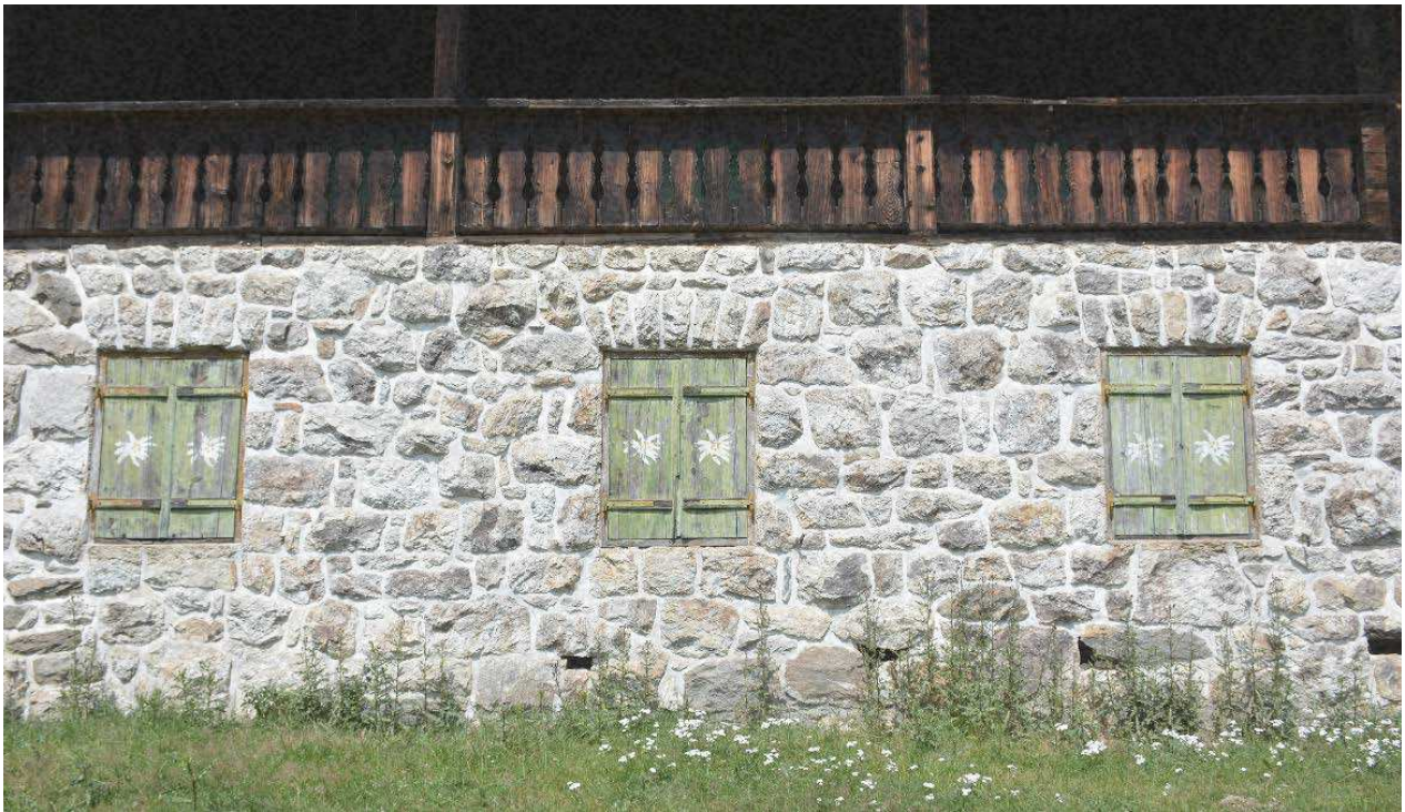
Abb.24: Bruchsteinmauerwerk im Sockelbereich
