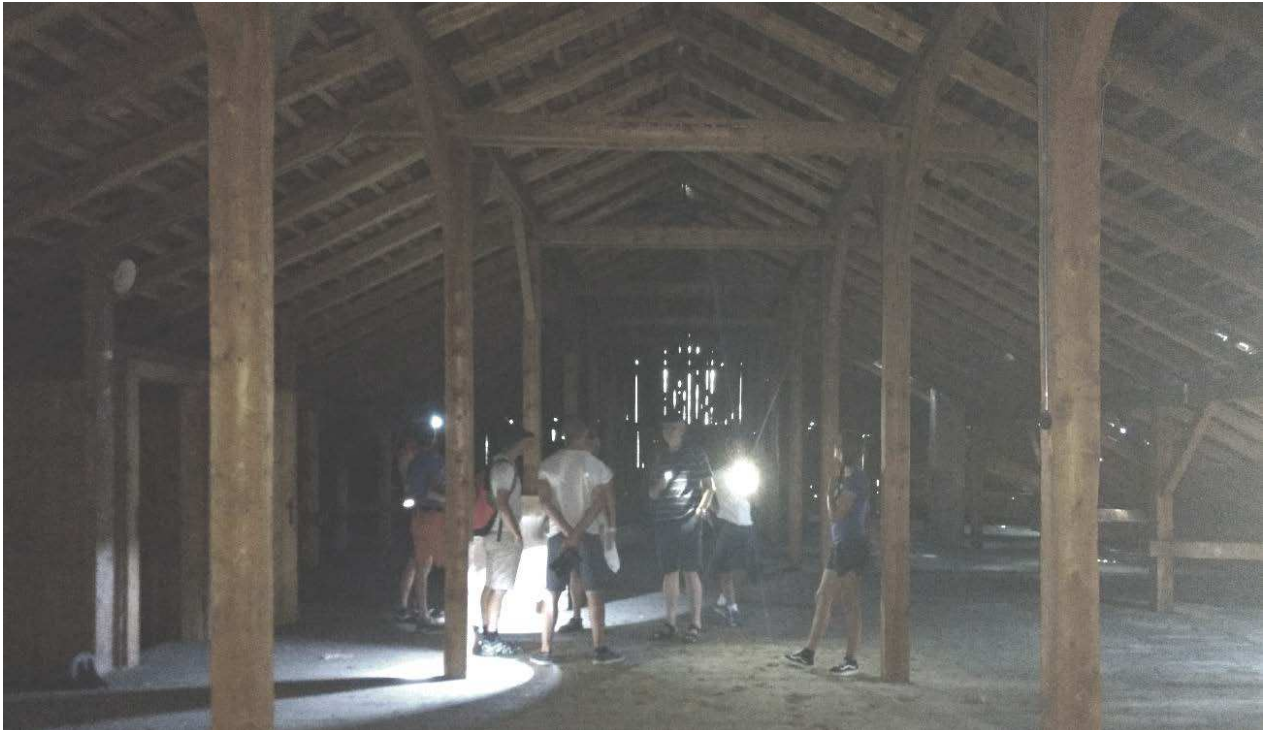
Abb. 34: Blick in den Dachraum
