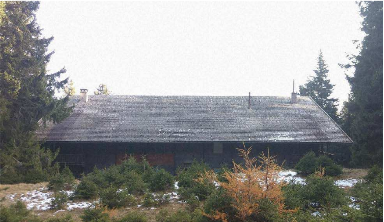
Abb.10: Ferienkolonie „Regina Elena“, Blick vom Wanderweg auf die Nordfassade (Hauptzugang)
