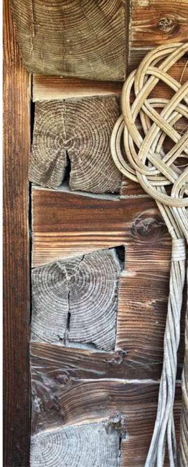
Abb. 175: Schwalbenschwanzverbindung
