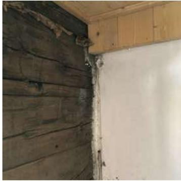
Blockbau + neue Fertigteildecke
