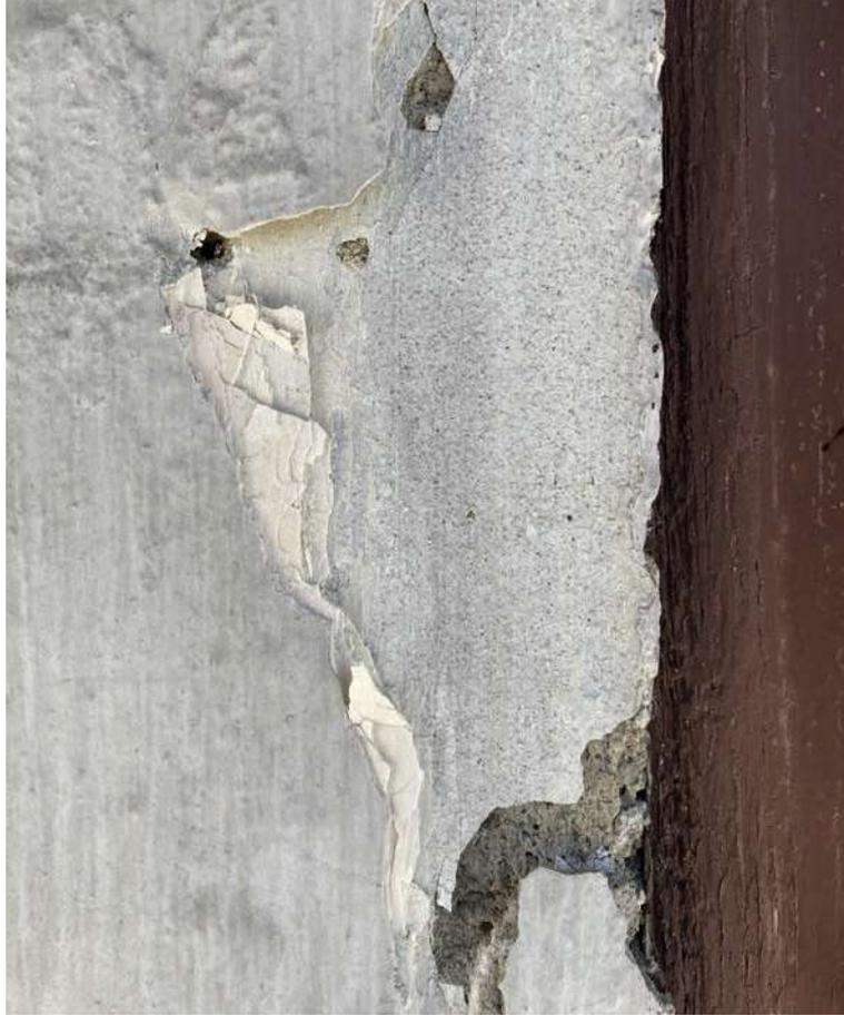
Abb. 168: Bruchsteinmauerwerk mit Kalkanstrich Wohntrakt
