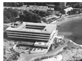
ATRIUM Beispiel: Hotel Pelegrin, Kupari Architekt: D. Finčić; 1963
