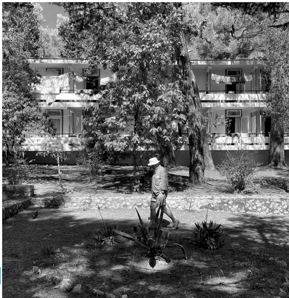
Abb. 64. Bestand Fassade - Innenhof
