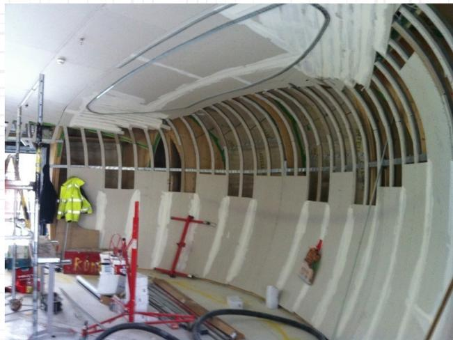
Abb. 30. Beispiel Aufbau paranetrische Holzkonstruktion
