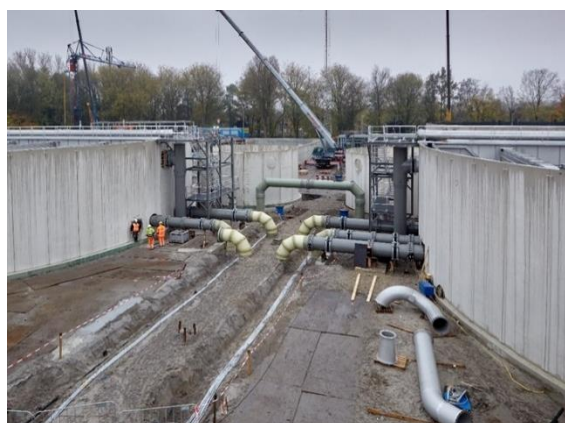
Abbildung 1: RZWI Utrecht: Nereda®-Verfahren für 450.000 E (Bild: https://www.hdsr.nl/beleid-plannen/projectenkaart/utrecht/vernieuwing-utrecht/ )
