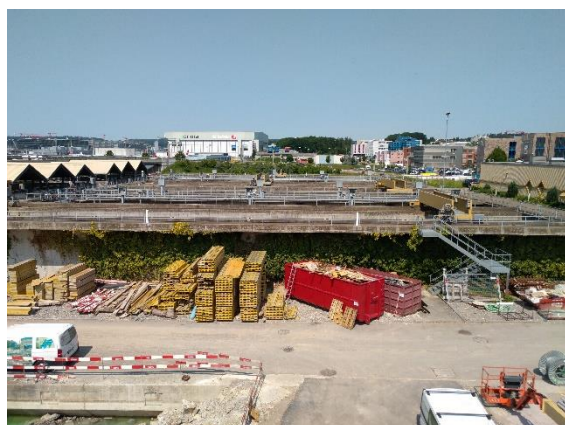
Abbildung 2: ARA Kloten Opfikon: Nereda®-Verfahren in Bau für 125.000 E
