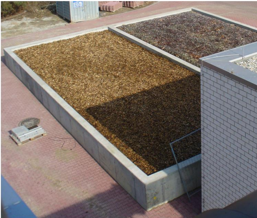
Abbildung 10: Biofilter Kläranlage Frankfurt-Nierderrad – 2 Einheiten, zu Testzwecken mit unterschiedlichen Filtermaterialien gefüllt
