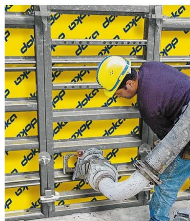
Abb. 5.8: Anwendung der Einfüllkonstruktion System Doka GF-Füllstutzen SCC mit Sperrschieber D125 SCC. Bild links: Anwendung im vorliegenden Fall zur Befüllung der SCSC-Platte. Bild rechts: Anwendung in DOKA Rahmenschalungen aus [10]
