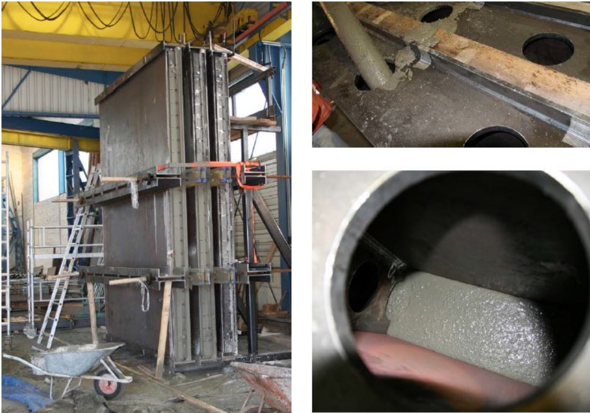
Abb. 6.4: Betonage der SCSC-Hauptversuchskörper der Serie A; links: temporär verspannte und aufgestellte Hauptversuchskörper; rechts oben: Betonage mit Betonpumpe und Schlauch; rechts unten: Blick ins Innere eines QS-Typ 1-Versuchskörpers durch eine Betonieröffnung eines Endbleches [23]
