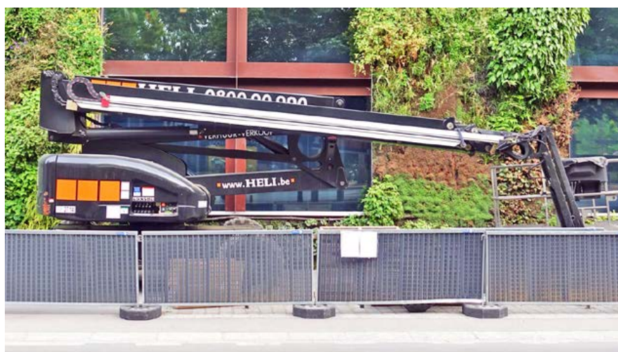
Abb. 224: Pflegearbeiten bei der begrünten Fassade
