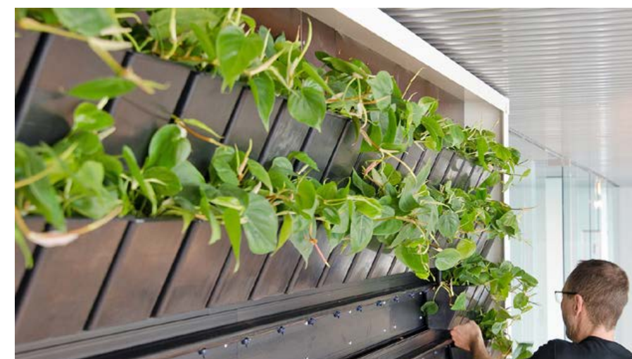
Abb. 150: Einhängen der einzelnen Pflanzgefäße in das modulare Trägersystem
