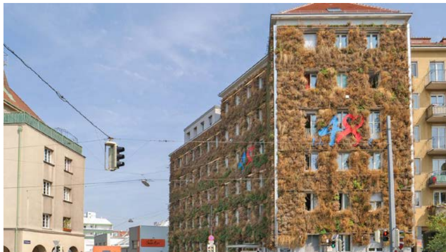
Abb. 269: Störung bei der automatischen Bewässerungsanlage im Jahr 2019
