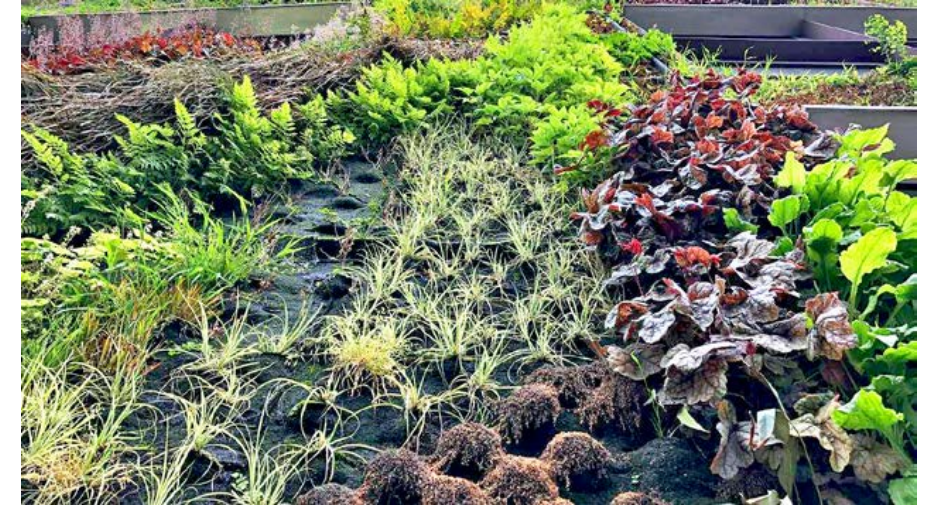
Abb. 109: Fassadenbegrünung mit mehrlagigen Geovliesen
