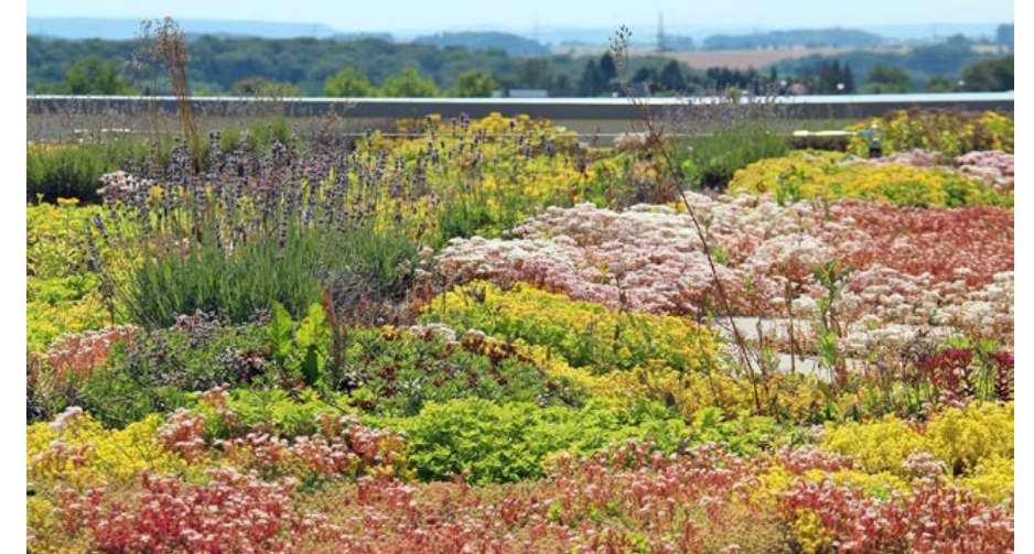
Abb. 58: Extensivbegrünung mit Sedum-Kraut-Gras-Vegetation
