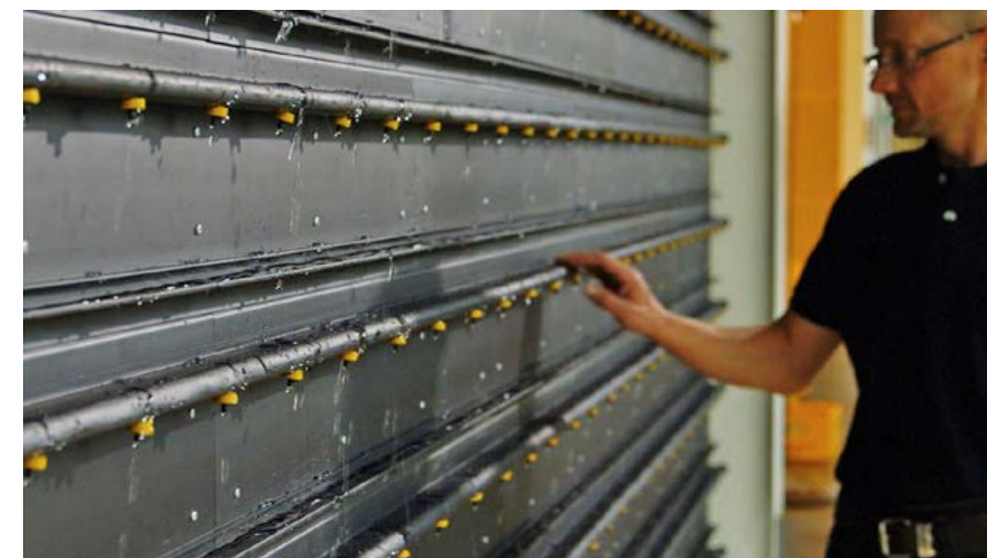
Abb. 149: Einbau des Bewässerungssystems mit Einzeltropfern über jedem Topf
