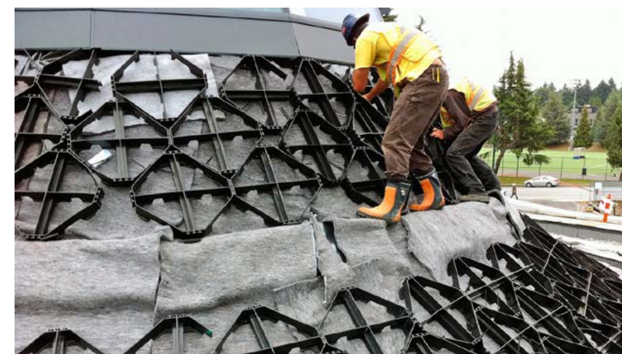
Abb. 65: Begrünung einer Dachfläche mit mehreren unterschiedlichen Krümmungen
