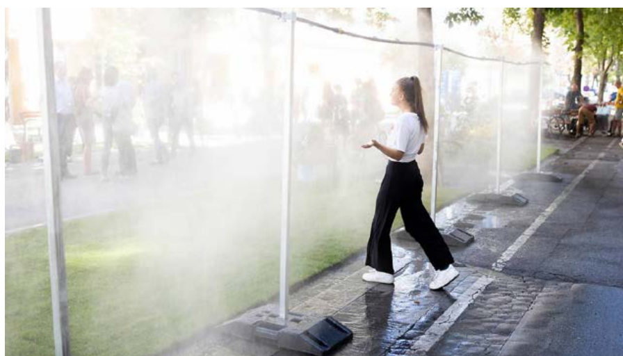
Abb. 12: Wasserinstallation - Abkühlung durch Sprühnebel
