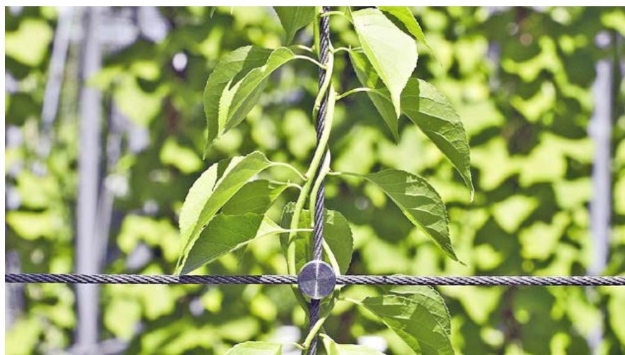
Abb. 94: Detail - Seilkonstruktion und Kletterpflanze
