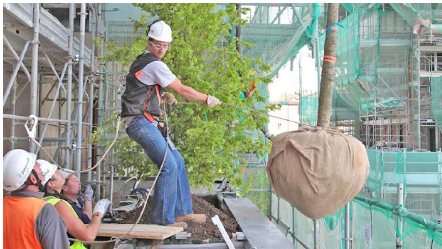
Abb. 180: Positionieren der Pflanze durch die Arbeiter
