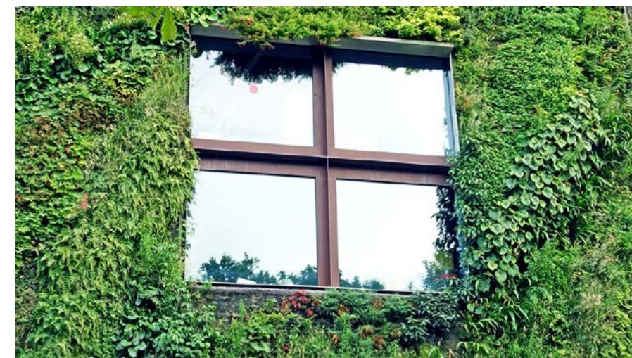
Abb. 91: Fassadengebundenes Begrünungssystem mit Vlies als Trägermaterial
