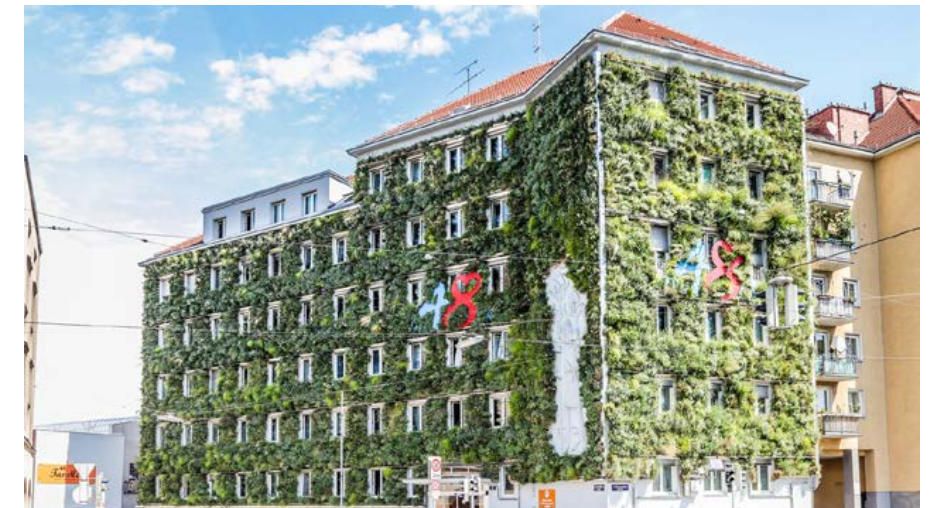
Abb. 259: Aufnahme nach der Begrünung des Bauwerks
