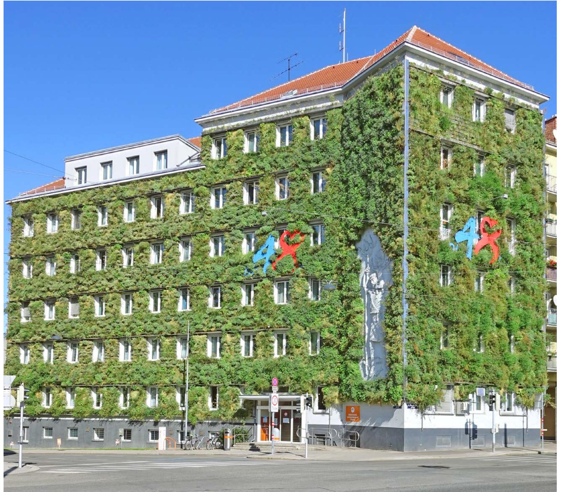
Abb. 263: Die Grünfassade bei der Besichtigung vor Ort im Herbst 2020
