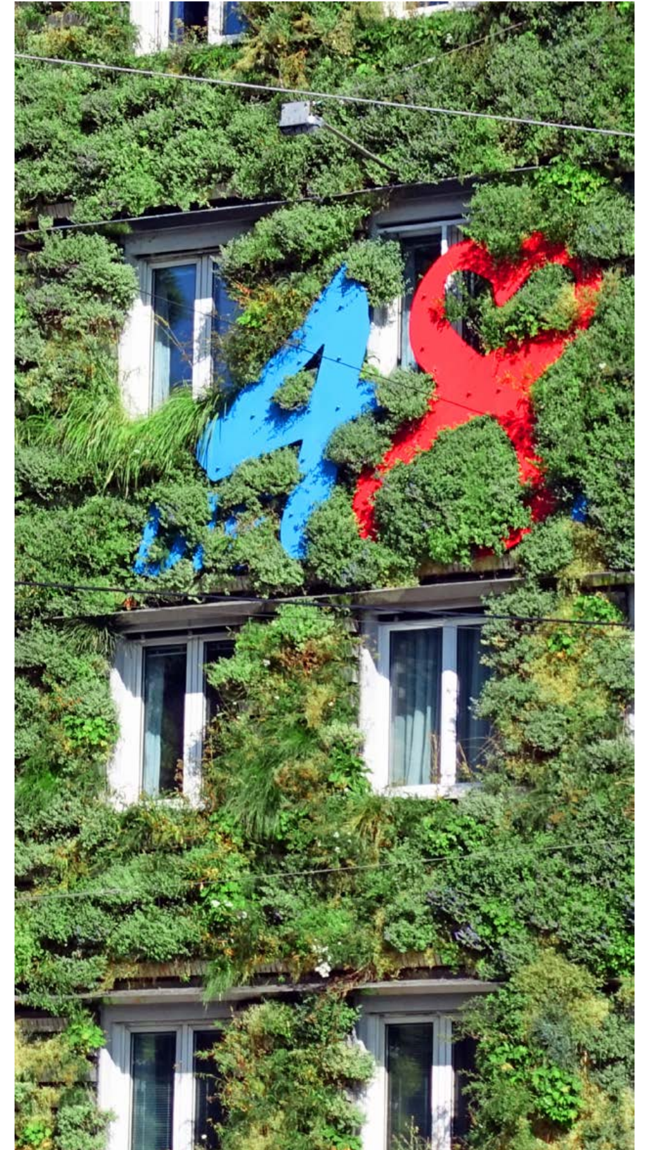
Abb. 165: Praxisbeispiel in Wien - Grünfassade bei der Zentrale der MA 48
