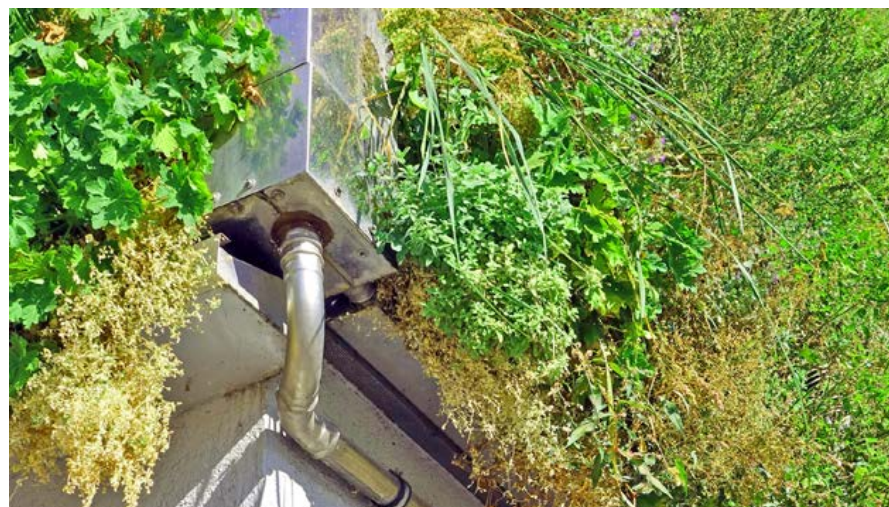
Abb. 265: Detailaufnahme - Ecke zwischen West- und Südseite der Fassade
