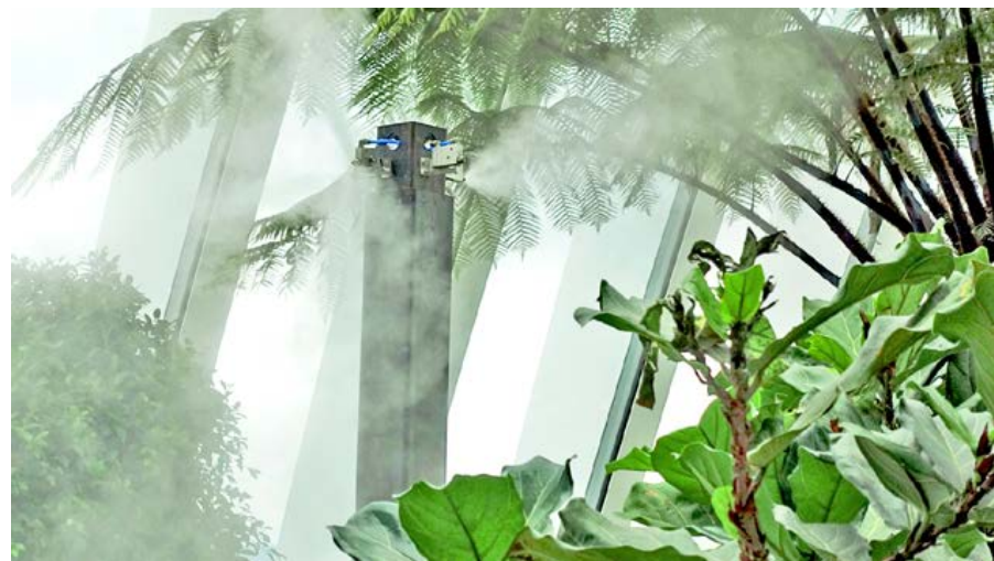
Abb. 245: Detail - Nebelungsanlage
