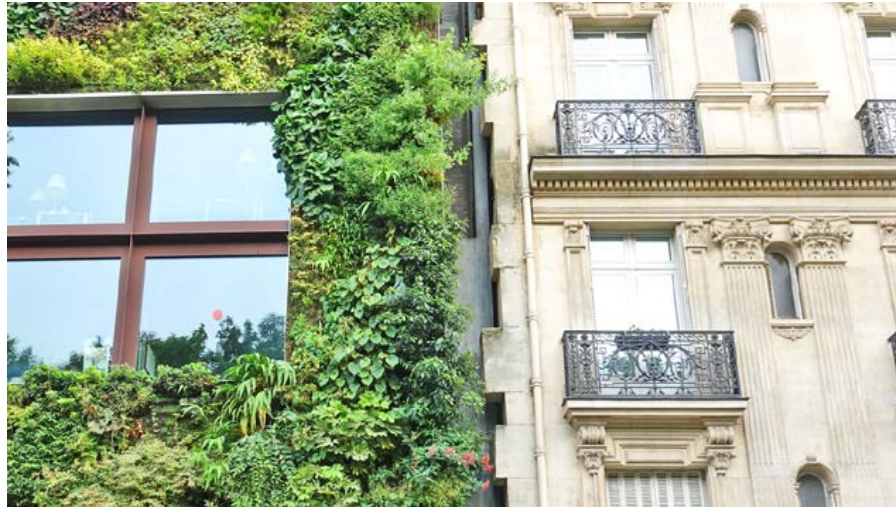
Abb. 216: Grünfassade und angrenzendes Gebäude aus der Haussmann-Epoche
