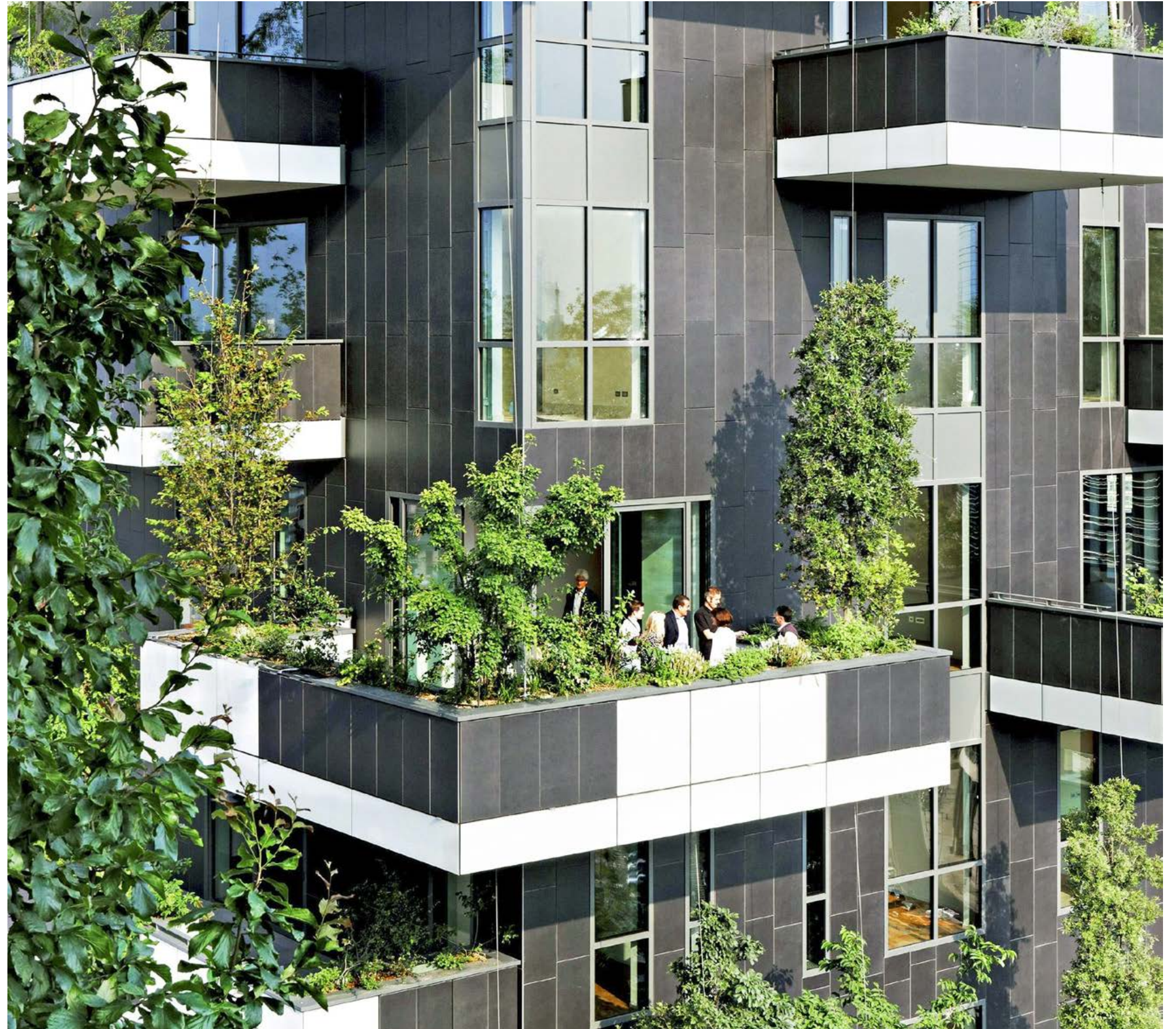
Abb. 176: Gartenbalkone mit Sträuchern und Bäumen bei den Türmen des Bosco Verticale in Mailand, entworfen von Stefano Boeri, fertiggestellt im Jahr 2014
