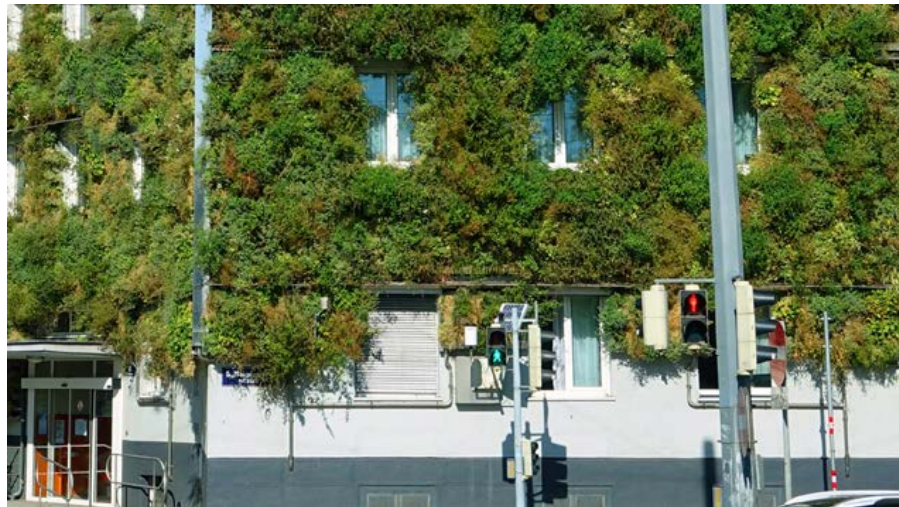
Abb. 40: Amtsgebäude der MA 48 - Ausschnitt, Südseite der Grünfassade (2020)
