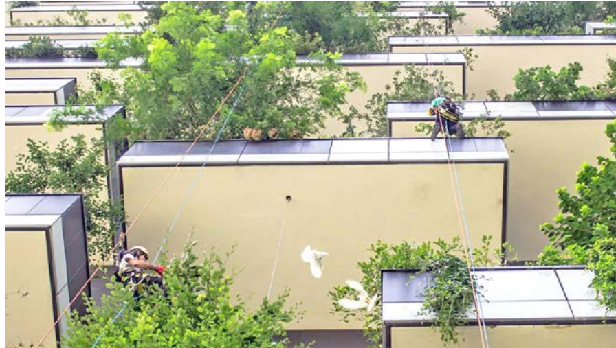
Abb. 186: Pflegearbeiten an der Fassade
