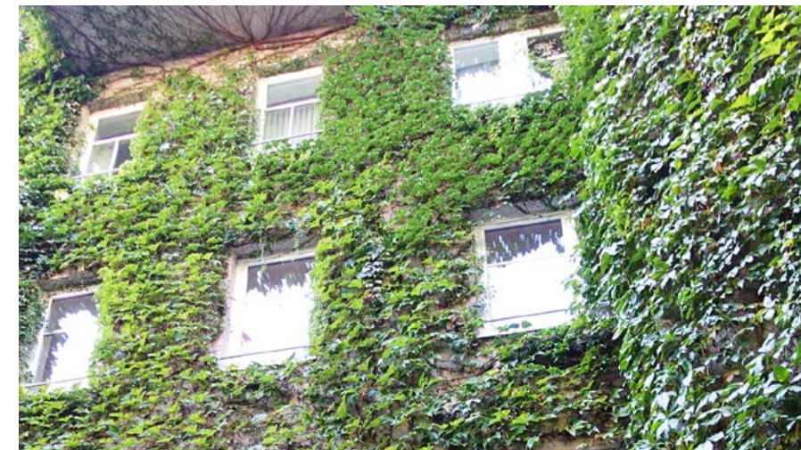
Abb. 89: Bodengebundene Fassadenbegrünung mit Direktbegrünern
