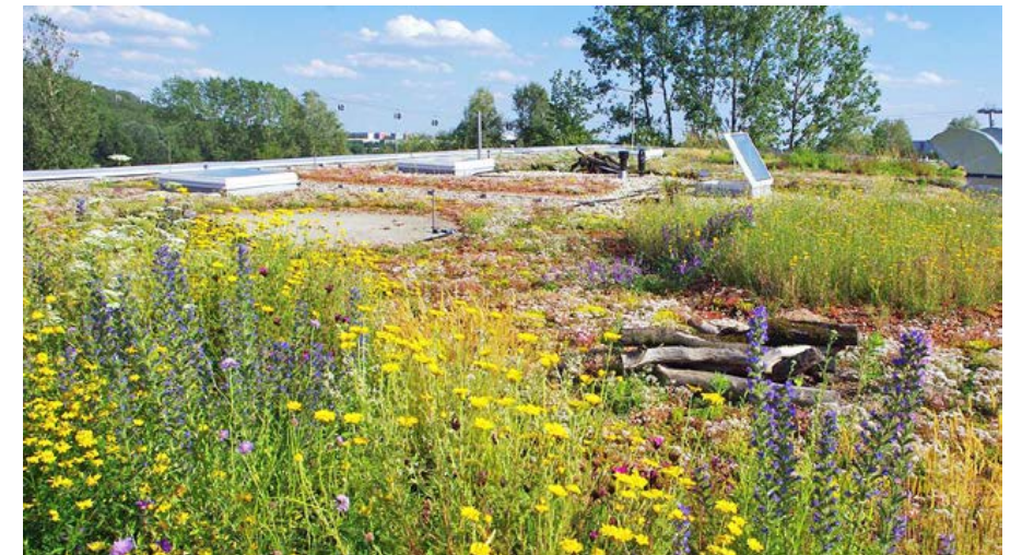
Abb. 50: Biodiversitätsdach mit Sandlinsen, Totholz und unterschiedlichen Pflanzen
