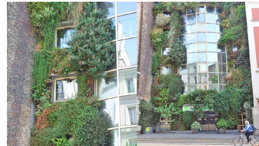
Abb. 211: Green Hôtels Paris 13 - Grünfassade und verglaste Bereiche
