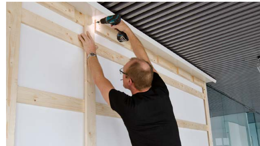
Abb. 148: Montage einer Holzträgerkonstruktion auf der tragfähigen Wand
