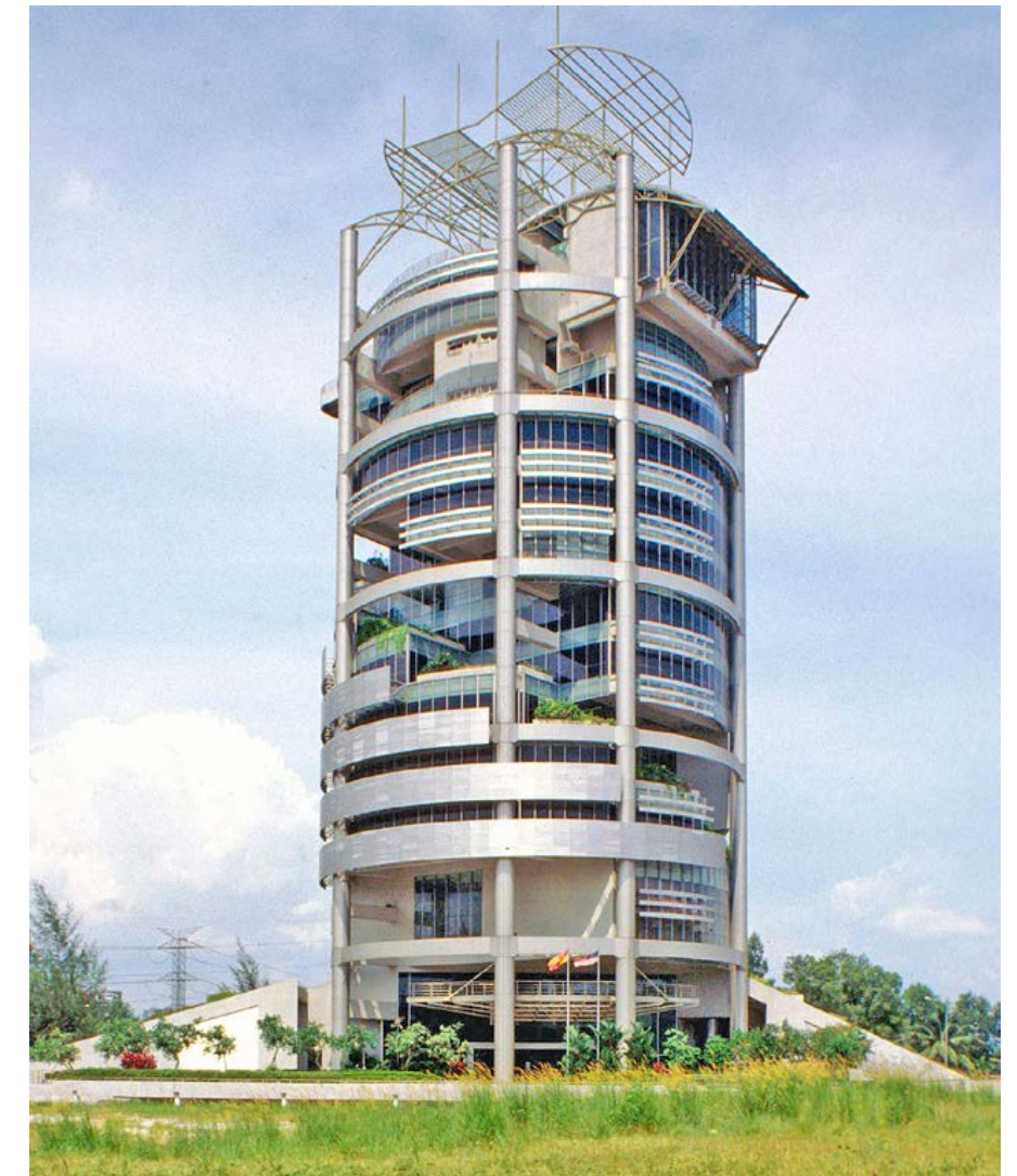
Abb. 173: Menara Mesiniaga Hochhaus in Subang Jaya, K. Yeang, 1992
