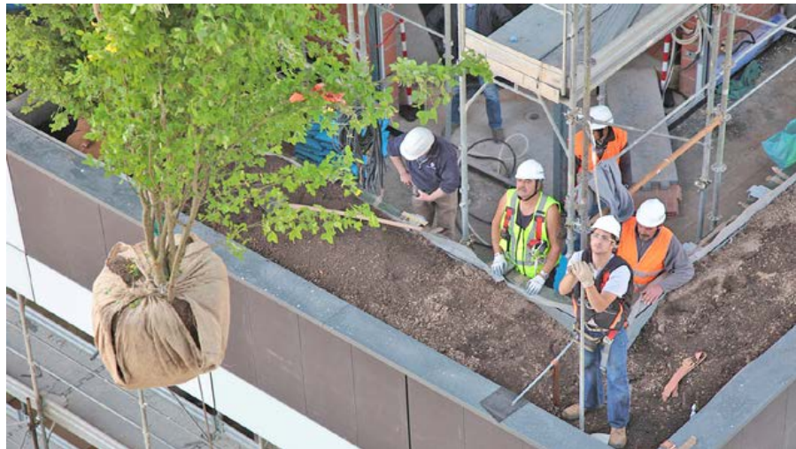
Abb. 179: Emporheben eines Baumes mithilfe eines Krans
