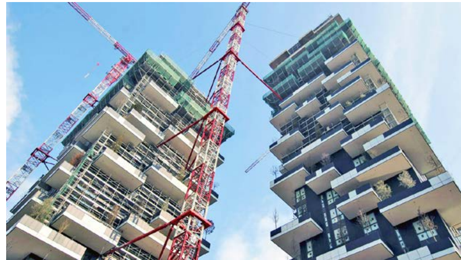
Abb. 182: Errichtung der beiden Türme
