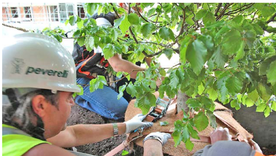
Abb. 181: Befestigung des Baumes mit eigens entwickeltem Verankerungssystem
