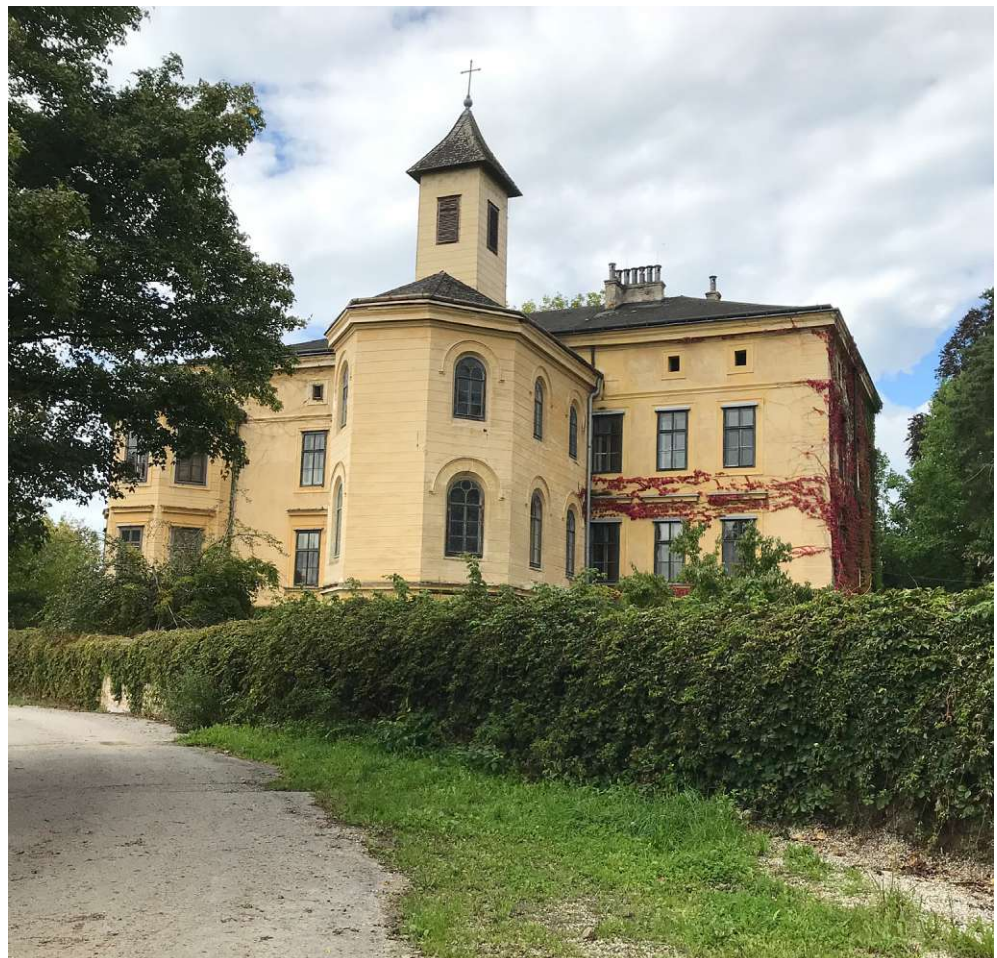
Abb. 99: Ansicht Schloss Auhof Südwest
