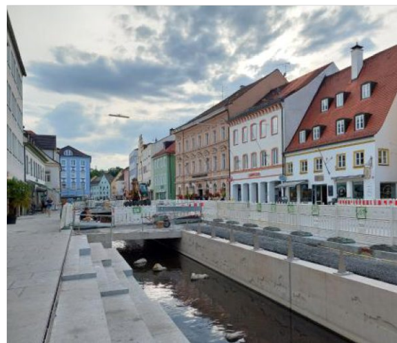
Abb. 57: Abschnitt Obere Hauptstraße 2022 mit in Bau befindlicher Moosachöffnung (Eigene Aufnahme, 17.08.2022)
