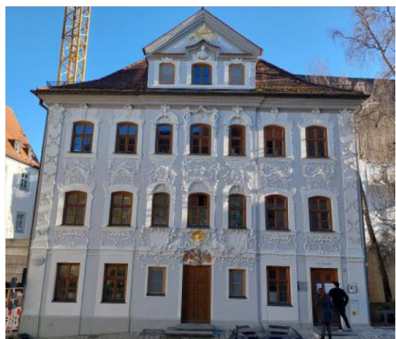
Abb. 26: Baudenkmal Standesamt Freising (Eigene Aufnahme, 10.03.2022)
