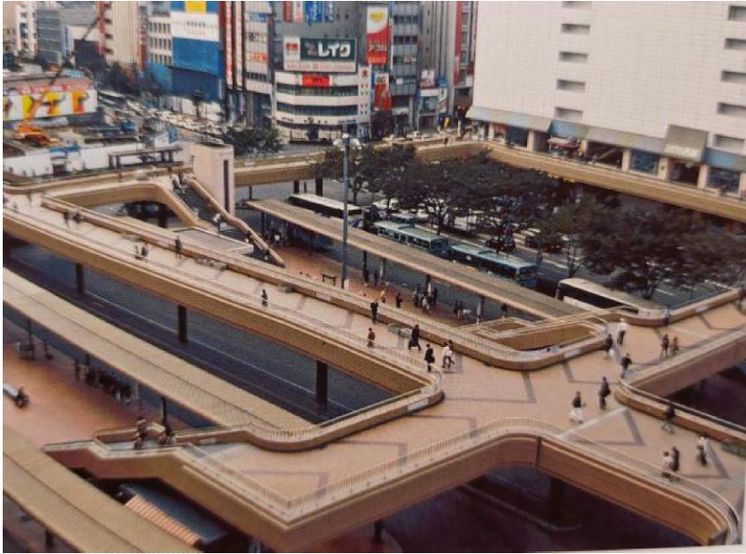
Abb. 79: Fußgängerüberführungen mit großer Barrierewirkung in Sendai, Japan (Quelle: Gehl 2015b: 155)
