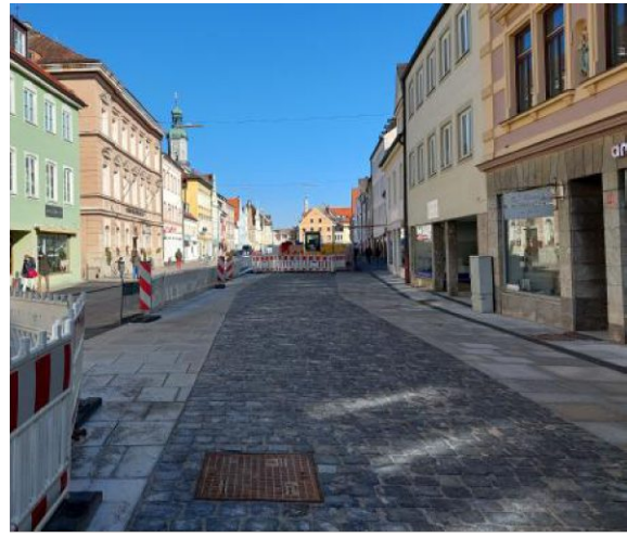
Abb. 63: Abschnitt Obere Hauptstraße 2022 während der Umgestaltung (Eigene Aufnahme, 17.08.2022)
