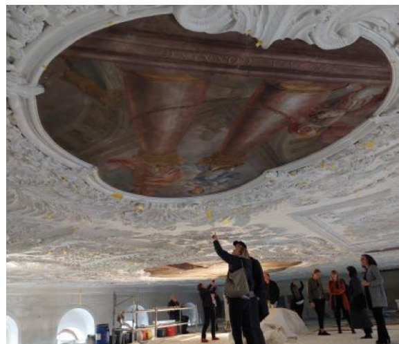
Abb. 50: Sanierung der Barockdecke des Asamsaals (Eigene Aufnahme, 31.05.2022)
