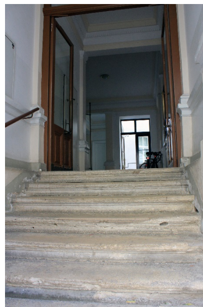
Abbildung 61: Hauseingangsbereich mit Stufen; Quelle: eigene Darstellung
