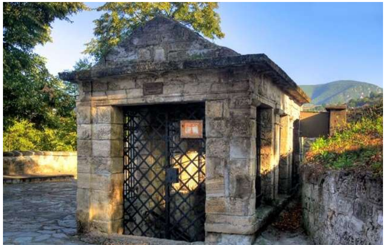
Abb. 81 _ Der Eingang zu den Katakomben
