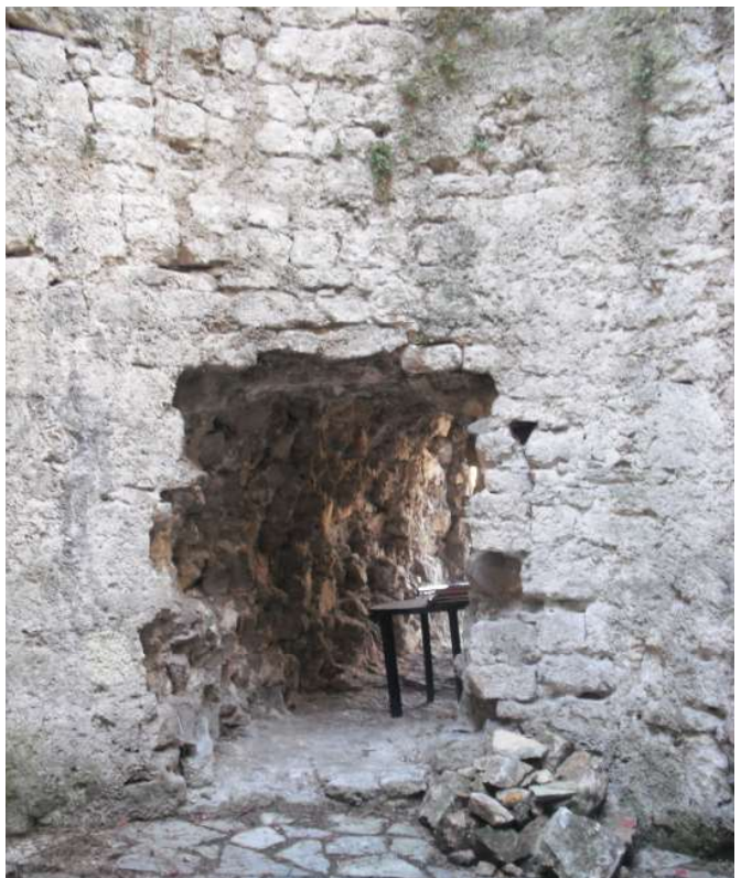
Abb. 77 _ Der Eingang zum Bärenurm - der Blick von Innen
