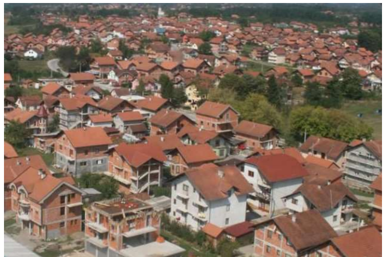
Abb. 14 _ Die illegal gebaute Wohnsiedlung, Banja Luka, Bosnien und Herzegowina
