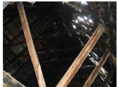
Abb. 100 _ Die Dachbeschädigungen
