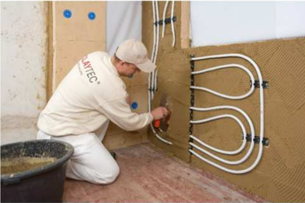
Abb. 23: Einputzen der Wandflächenheizung Quelle: FVID Fachverband Innendämmung e.V. 2018
