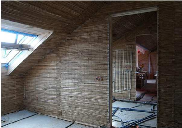
Abb. 26: Befestigung der Schilfplatten an der Holzschalung Quelle: Breuss 2014
