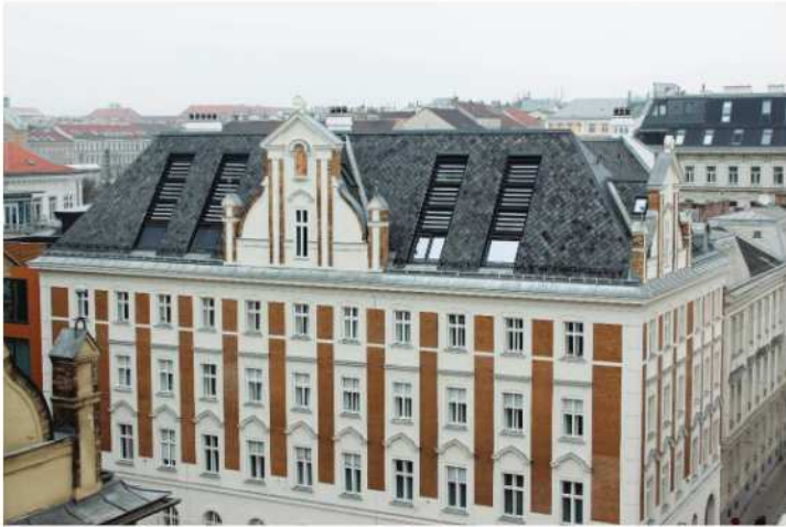
Abb. 19: Straßenseitige Fassade Kaiserstraße 7 Quelle: Bundesministerium für Verkehr, Innovation und Technologie 2018:16
