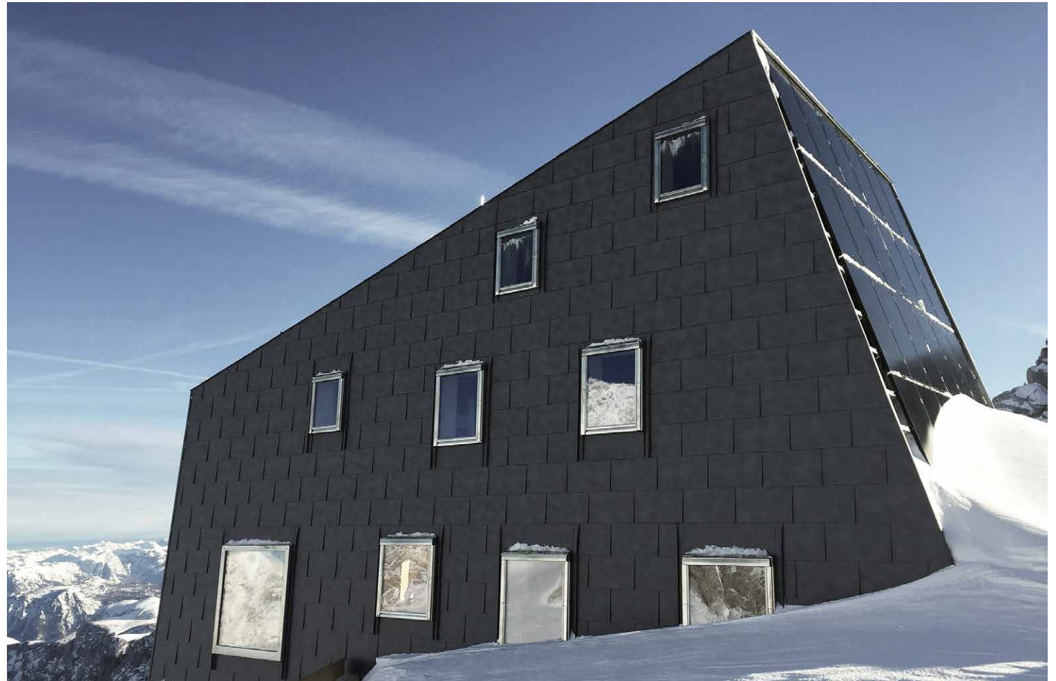
Abb.82: Südfassade mit Photovoltaikelementen
