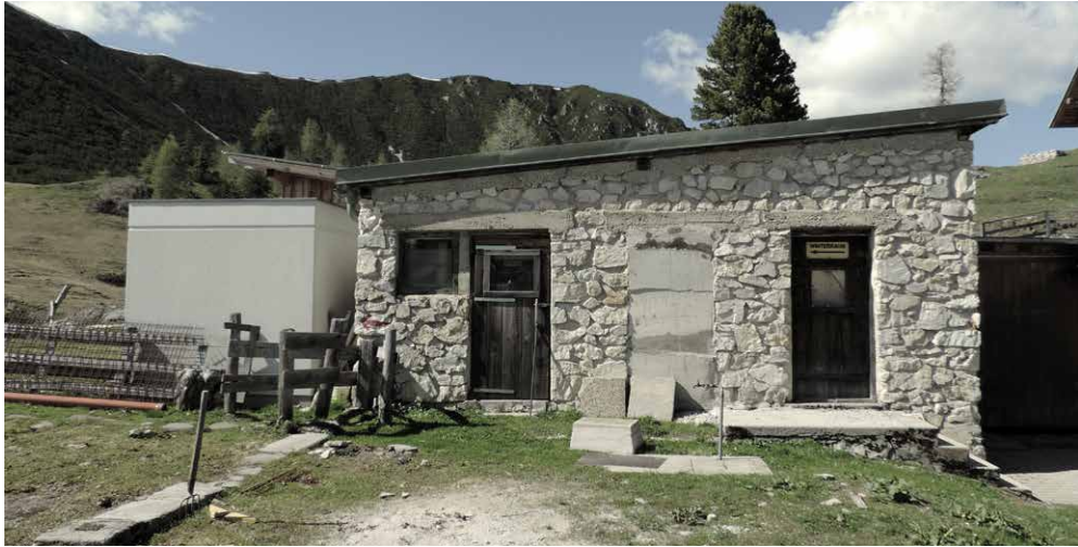
Oben Abb.145: Trafostation der Sagis und Winterraum
