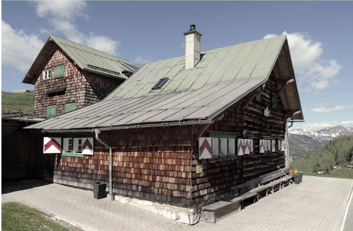
Links Abb.144: Südfassade und Terasse
