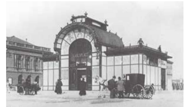
Abb. 6: Stadtbahn Station Karlsplatz, 1898
