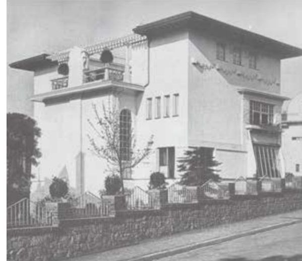
Abb. 30: Haus Habich, Ansicht Nordost, 1901
