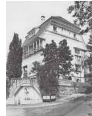
Abb. 18: Haus Olbrich, Ansicht Südwest, 1901
