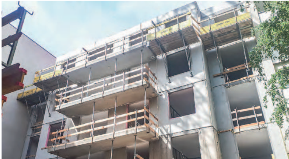
Abb.5.7: Baustelle Zieg- lergasse 53, Jahr 2019
