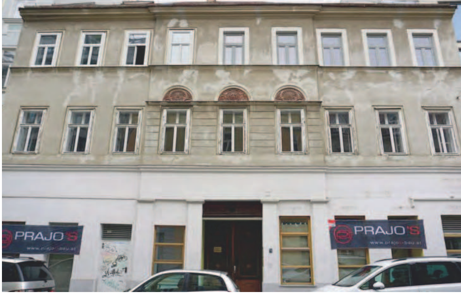
Abb.5.12: Zieglergasse 52, Vorgründerzeit- gebäude vor dem Abbruch
