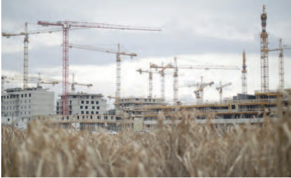
Abb. 2.6: Baustelle See- stadt Aspern
