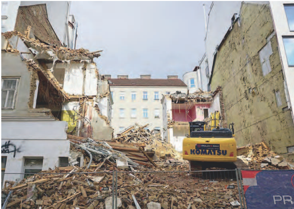
Abb.5.13: Zieglergasse 52, Abbruch des Vorgründerzeit- gebäudes
