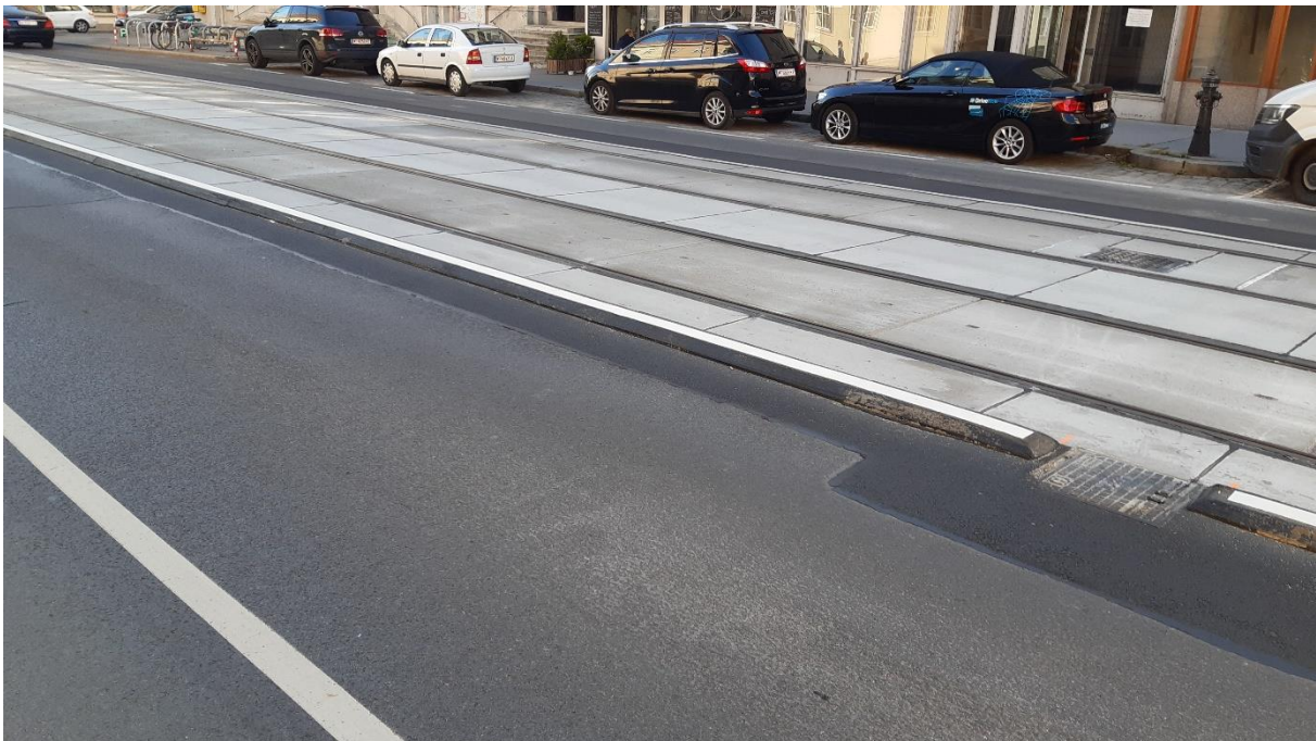
Abbildung 27 Selbstständiger Gleiskörper mit Längsschwellen, eigene Aufnahme
