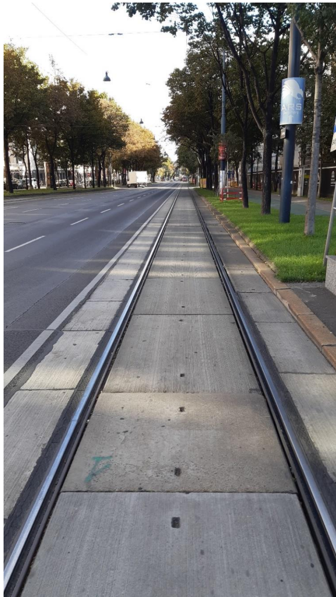
Abbildung 28 Straßenbündiger Gleiskörper, eigene Aufnahme
