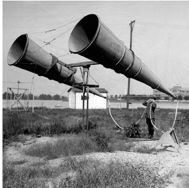
Abb. 1: Tonverstärker, Bolling Field, USA (1921)
