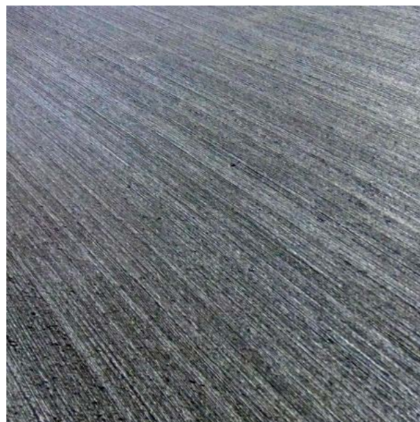
Beton mit Besenstrich Waben, Boden Außenbereich
