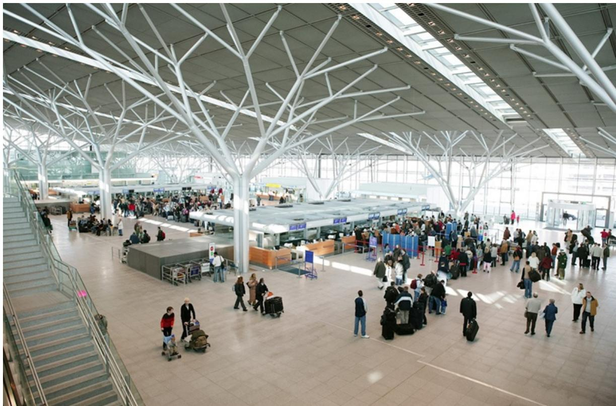
Abbildung 21: Baumstützen im Terminal 3 des Stuttgarter Flughafens
