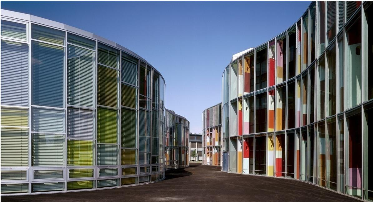
Abbildung 45: Photonikzentrum in Berlin von Sauerbruch Hutton; am rechten Gebäude sind die Öffnungen in den Säulen zum Schacht gut zu erkennen
