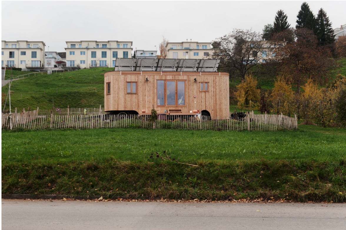
Abbildung 3: Zwischennutzung Tiny House in Au bei Zürich 16
