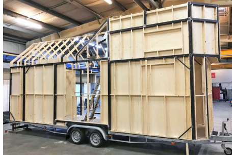
Abbildung 57: verplattete Metallkonstruktion eines mobiler Tiny Houses 96
