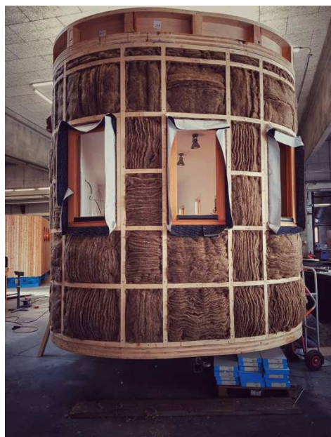
Abbildung 54: mit Dämmung ausgestopfte Ständerkonstruktion eines Tiny House 93
