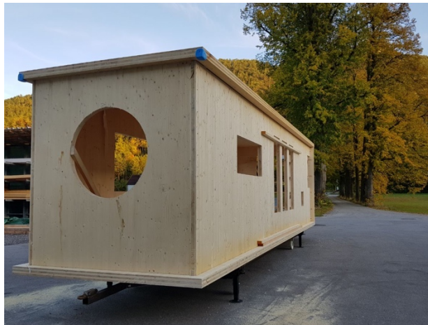
Abbildung 55: beispielhafter Vollholzaufbau eines Tiny House 94
