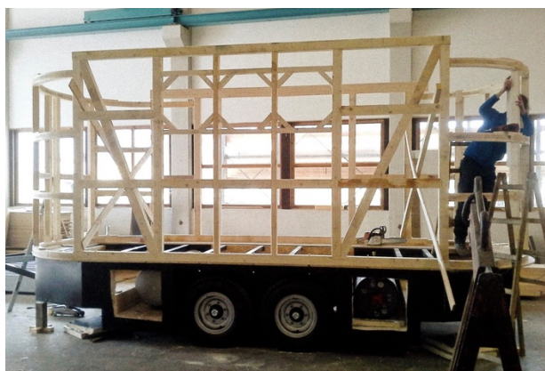
Abbildung 53: beispielhafter Ständeraufbau eines Tiny House 92
