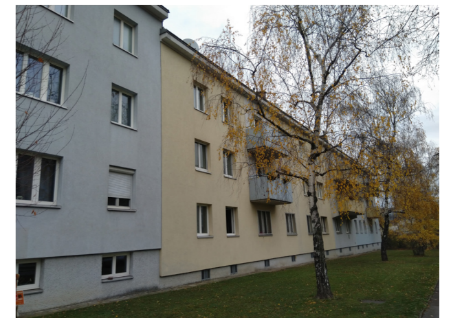
Abb. 57: Private Aufnahme Gebäudesprung Maroltingergasse
