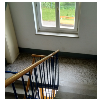
Abb. 97: Private Aufnahme Zwischenpodest d. Erschließung
