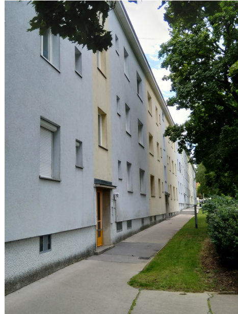
Abb. 42: Private Aufnahme Eingang Stiege 9
