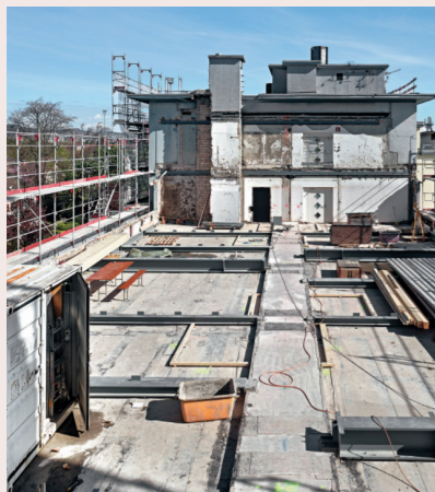
Abb. 16: Baustelle-Rautihuus Abfangrost Quelle: https://ddpnyc.com/
