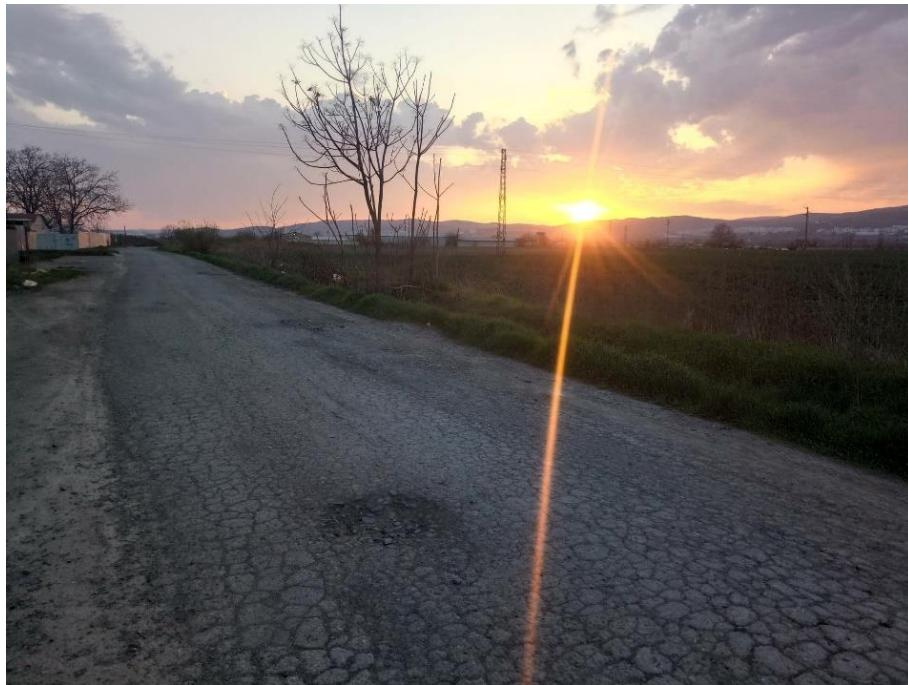
**Abbildung 2.1: Frost-Tau-Schäden an Straße mit ungenügender Entwässerung**
