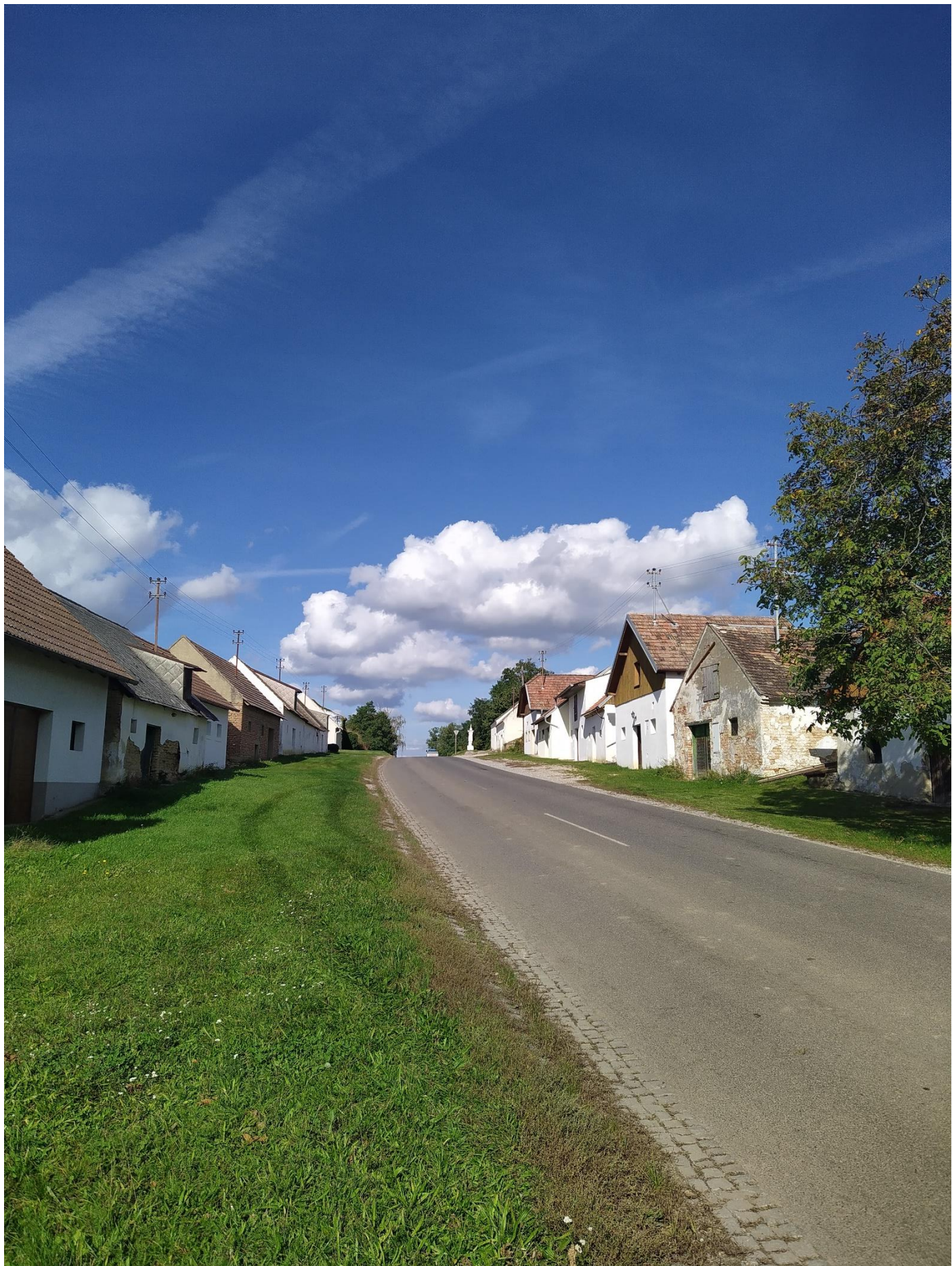
Abbildung 1: Keller entlang der L3052 bei Watzelsdorf, eigene Abbildung
