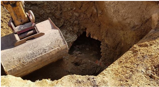
Abbildung 46: Das Loch im Gewölbe ist klein im Verhältnis zur transportierten Erdmasse, Quelle: NÖ Straßendienst
