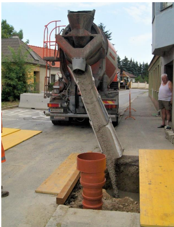
Abbildung 49: Verfüllen des Kellers in Stronsdorf, Quelle: NÖ Straßendienst
