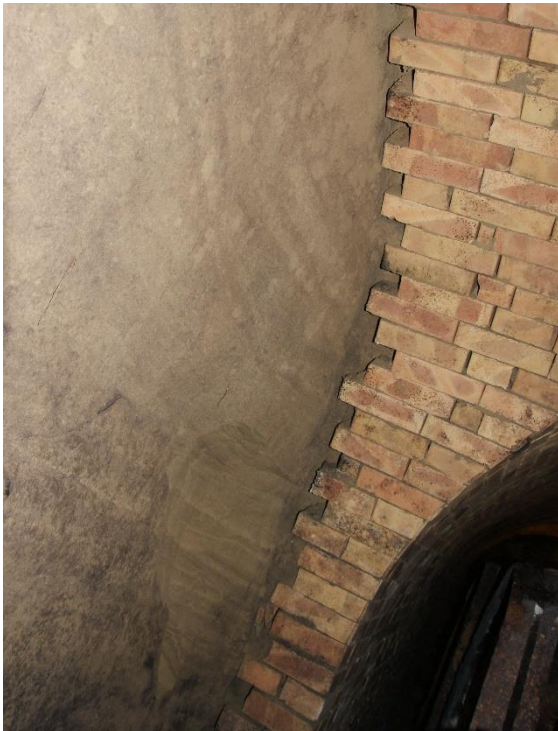
Abbildung 36: Abschluss eines Seitengangs einer gewölbten Kellerröhre in Martinsdorf, eigene Abbildung
