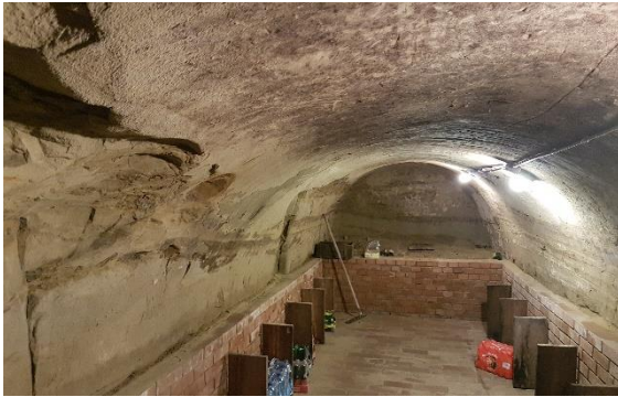
Abbildung 40: Standhaftes Gewölbe ohne Ausbau bei Kottingneusiedl, eigene Abbildung
