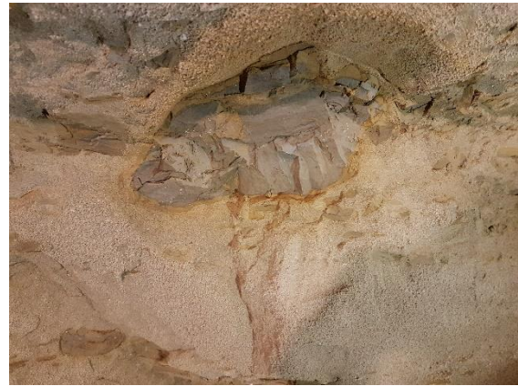
Abbildung 56: Tonklumpen im Löss mit teilweise oberflächlicher Salzkristallisation, eigene Abbildung
