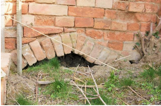
Abbildung 22: Verfüllte Kellerröhre in Martinsdorf, eigene Abbildung
