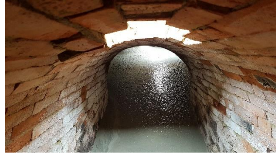
Abbildung 64: Das Verfüllmaterial erreicht durch seine Fließfähigkeit alle Hohlstellen, Quelle: NÖ Straßendienst
