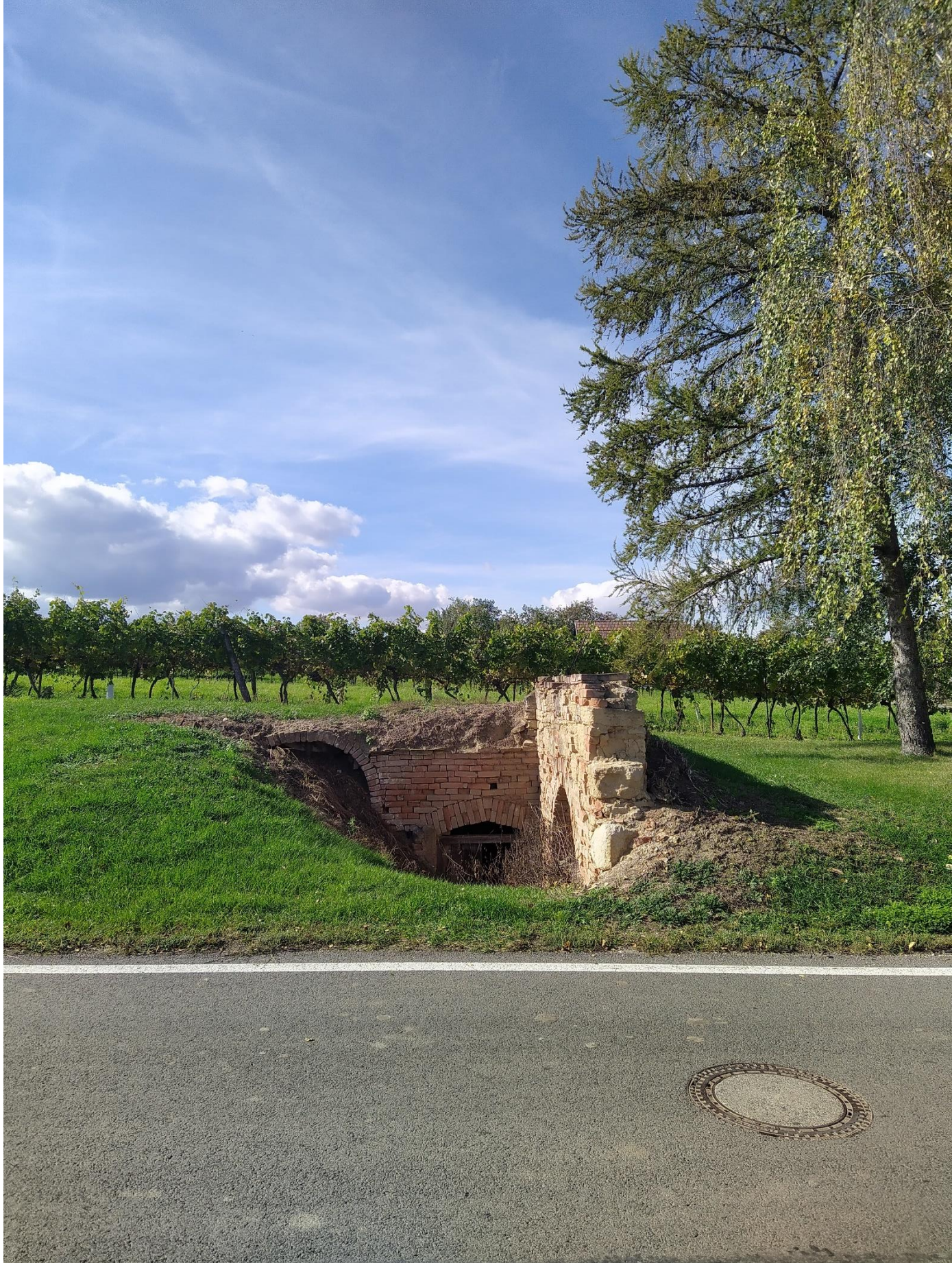
Abbildung 30: Drei verlassene Kellerröhren an der L3052 bei Ketzelsdorf, eigene Abbildung
