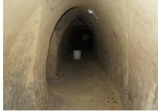
Abbildung 7: In den Löss gegrabene Gänge bleiben auch ohne Ausbau standfest, eigene Abbildung
