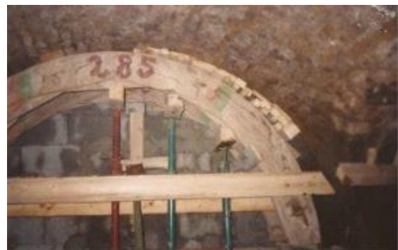
Abbildung 61: Teilsanierung eines Kellergewölbes mit Lehrgerüst in Poysdorf 1996, Quelle: Johannes Rieder
