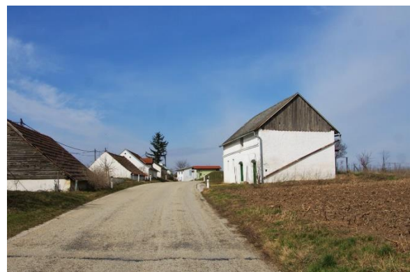
Abbildung 17: Die von Kellern unterquerte Straße L3031, eigene Abbildung
