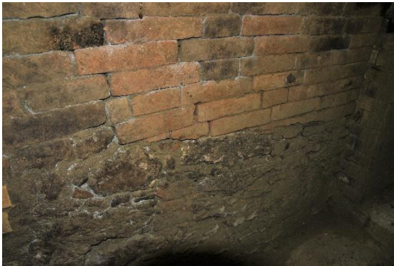
Abbildung 42: Im unteren Bereich wurde Naturstein verbaut, die oberen Ziegel wurden mit Lehm vermörtelt; eigene Abbildung
