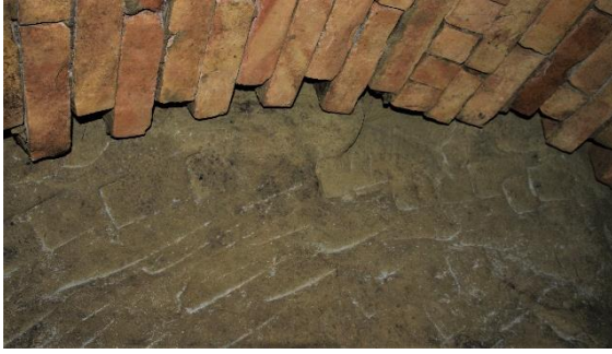
Abbildung 39: Bearbeitungsspuren im Löss am Ende einer Kellerröhre, eigene Abbildung
