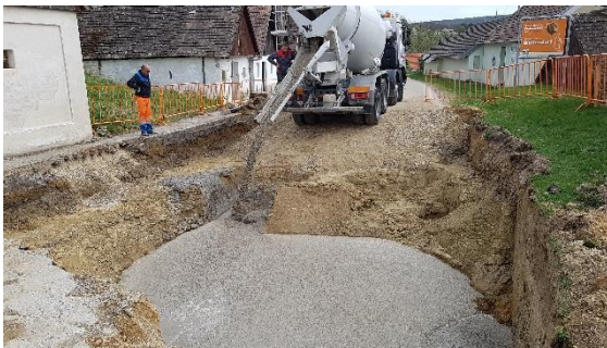
Abbildung 63: Beim Verfüllen einer Kellerröhre in Wultendorf kam eine große Menge an Material zum Einsatz, Quelle: NÖ Straßendienst
