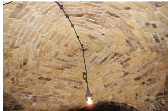
Abbildung 62: Böhmische Kappe im Schwalbenschwanzverband, eigene Abbildung
