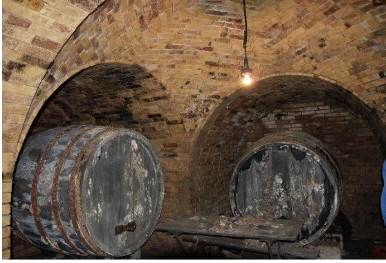
Abbildung 51: Kreuzungsbereich zweier Röhren mit Böhmischem Platzl mit Zustand 1, eigene Abbildung
