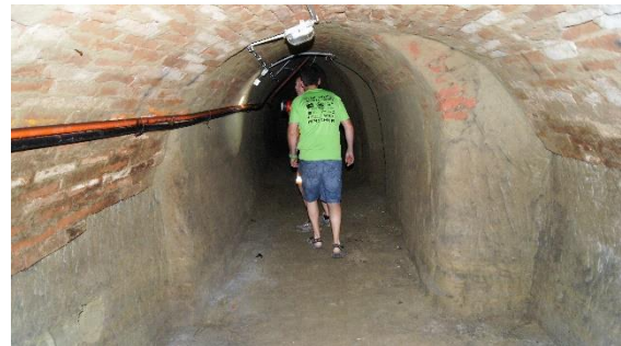
Abbildung 38: Teilweise gewölbter Keller, Quelle: NÖ Straßendienst
