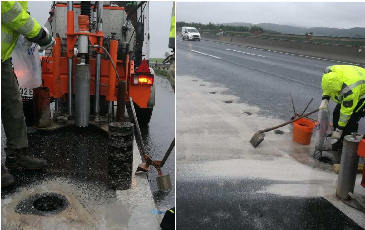
Abb. 3.4: herausgehobener Bohrkern mittels Zange (links) und Verdichtung der Löcher (rechts)
