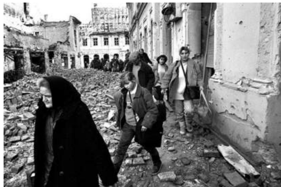
Abb. 07 - Zerstörte Straße Vukovars 1991
