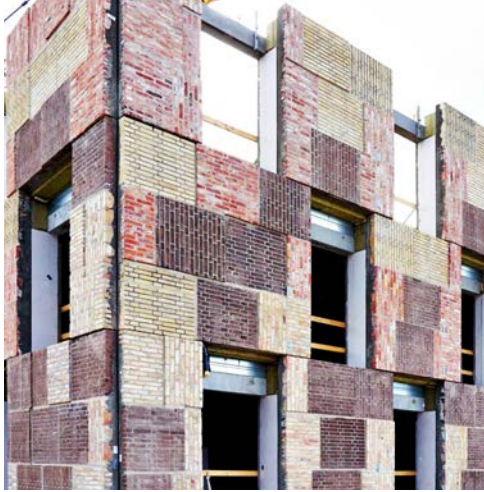
ABB. 81 WIEDERVERWENDUNG VON ZIEGELN IN COPENHAGEN
