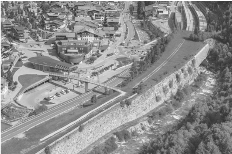
Abb. 12 St. Anton am Arlberg, Rendbahn Talstation Sommer
