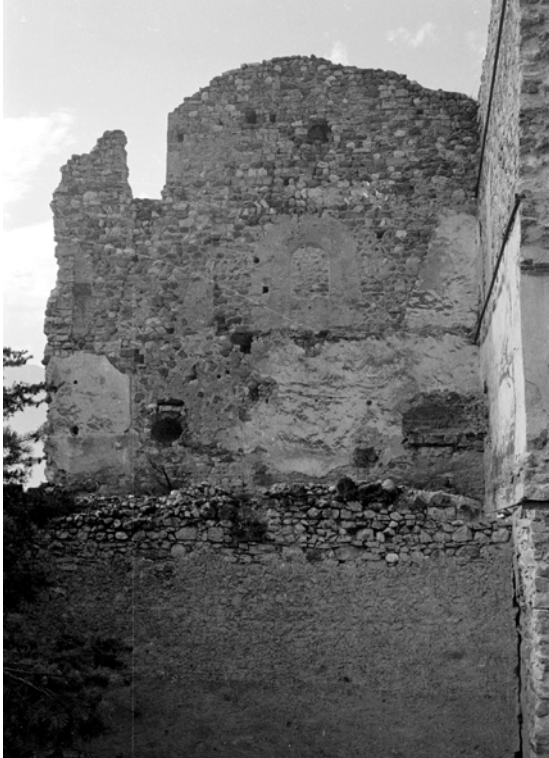
Abb.27: Mauer mit erkennbarer Gibelform
