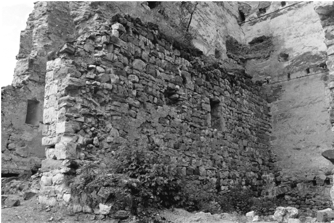
Abb.31: Nördliche Abschlussmauer des Saalbaus mit Eckverbindung
