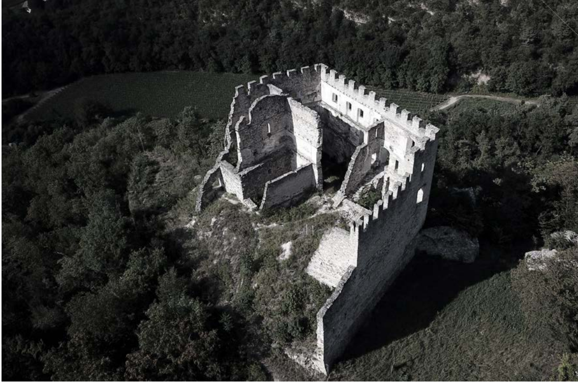
Abb.24: Westliche Abbruchstelle und Südfassade heute
