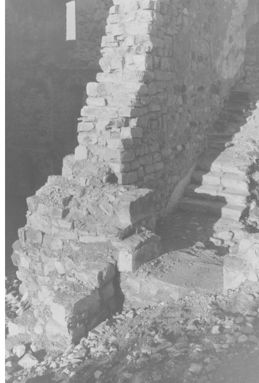
Abb.37: Treppenpodest mit Zugang zum Turm
