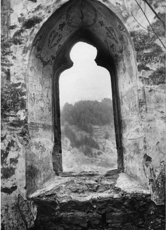
Abb.18: Kapellenfenster mit Maßwerk um
