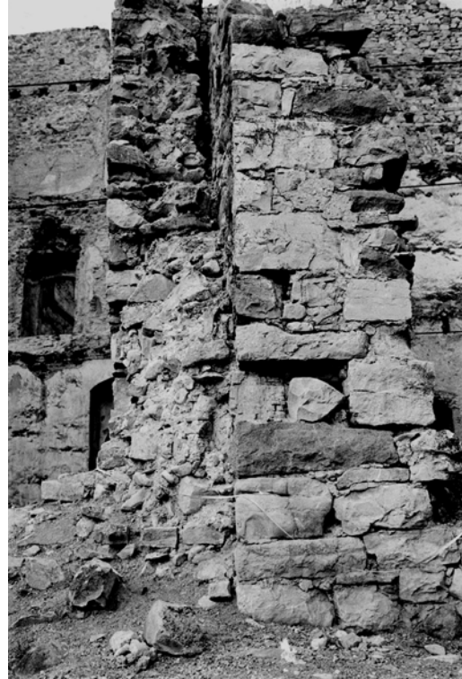
Abb.34: Fuge angestellte Erweiterung
