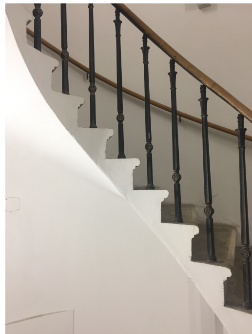
Abbildung 2.10: Geländerbefestigung auf der Trittfläche
