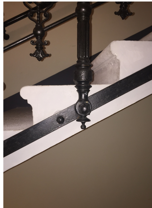
Abbildung 2.8: Geländerbefestigung an der Stirnseite mit Eisenband
