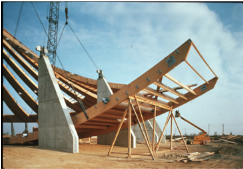
Abb 5. Montierung der Dachteile
