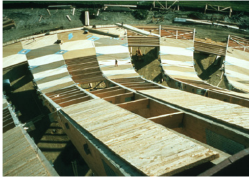
Abb 6. Montierung der Dachteile
