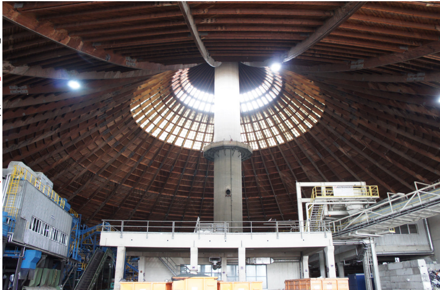
Abb 1. Innenarchitektur der Halle - Holzdach - Motoren
