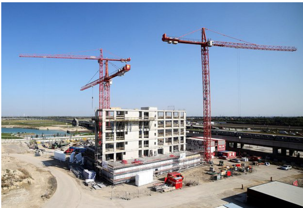
Abbildung 16: Baustellenfoto des HoHo
