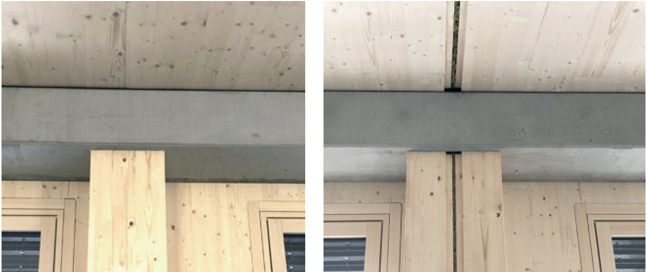
Abbildung 4: Schalltrennfugen
