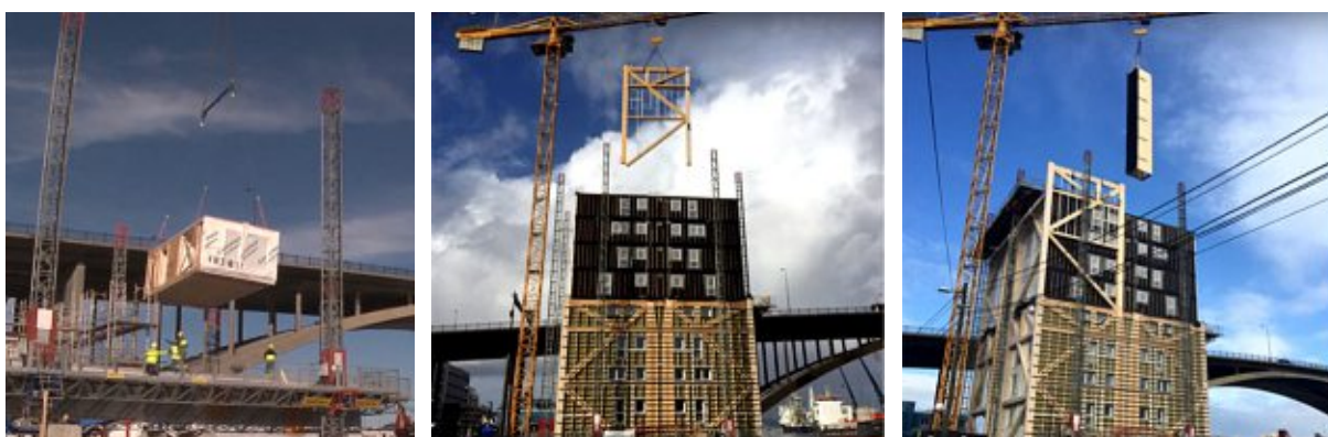
Abbildung 13: Einheben der vorgefertigten Elemente
