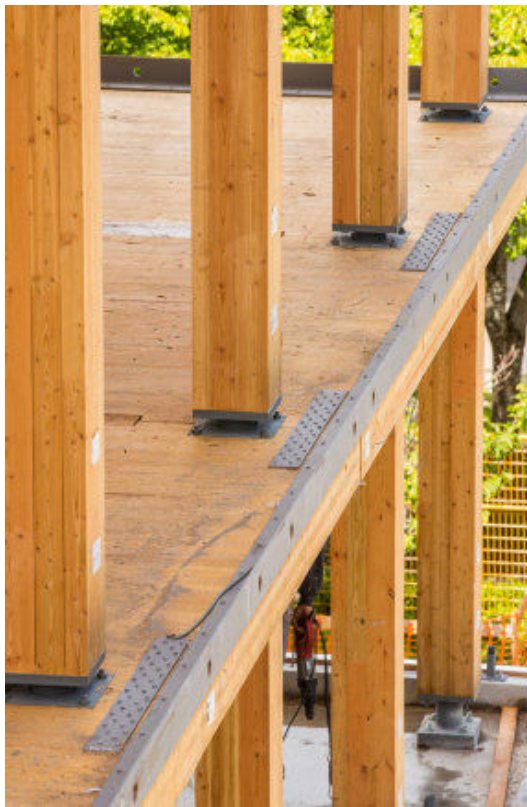
Abbildung 2: Stützenanschlüsse
