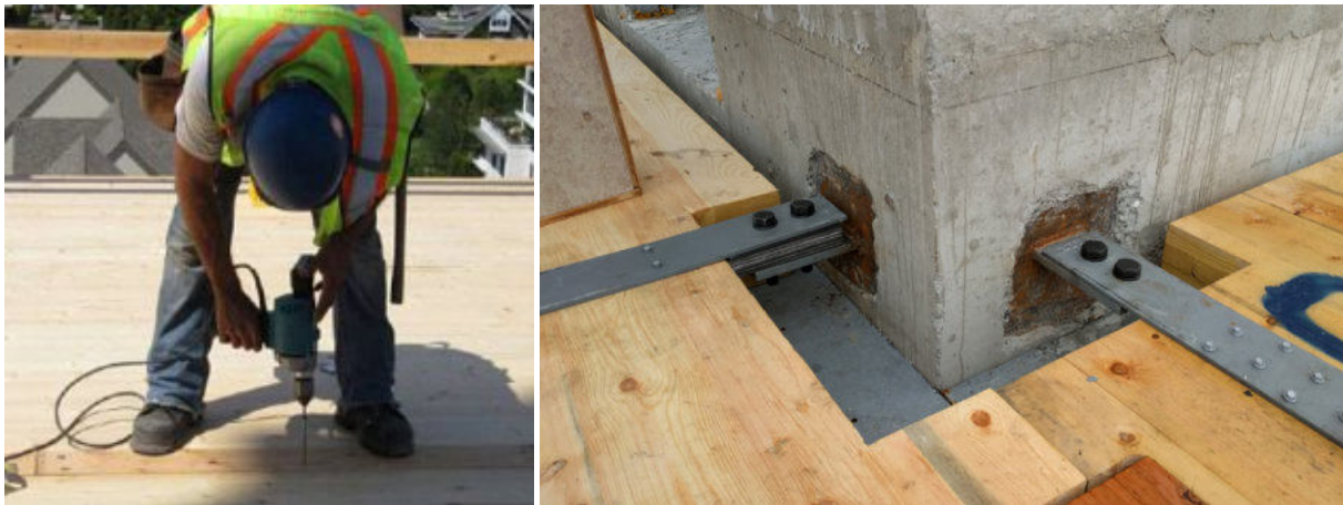
Abbildung 14: Verbindung der Platten und Rückverankerung
