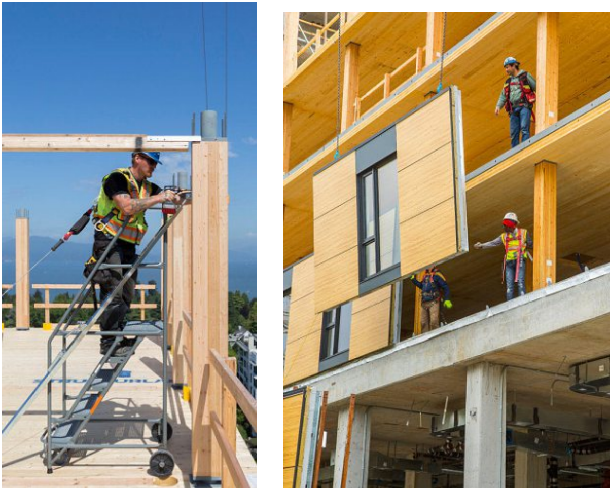
Abbildung 15: Montage der vorgefertigten Elemente
