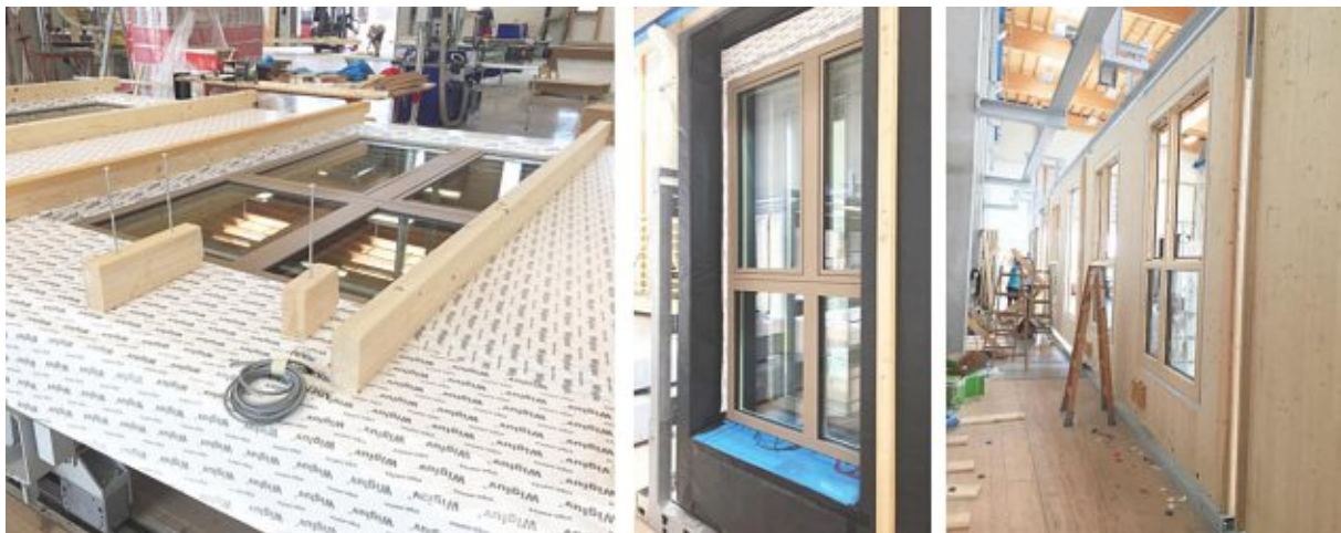
Abbildung 12: Fertigung der Fassadenelemente
