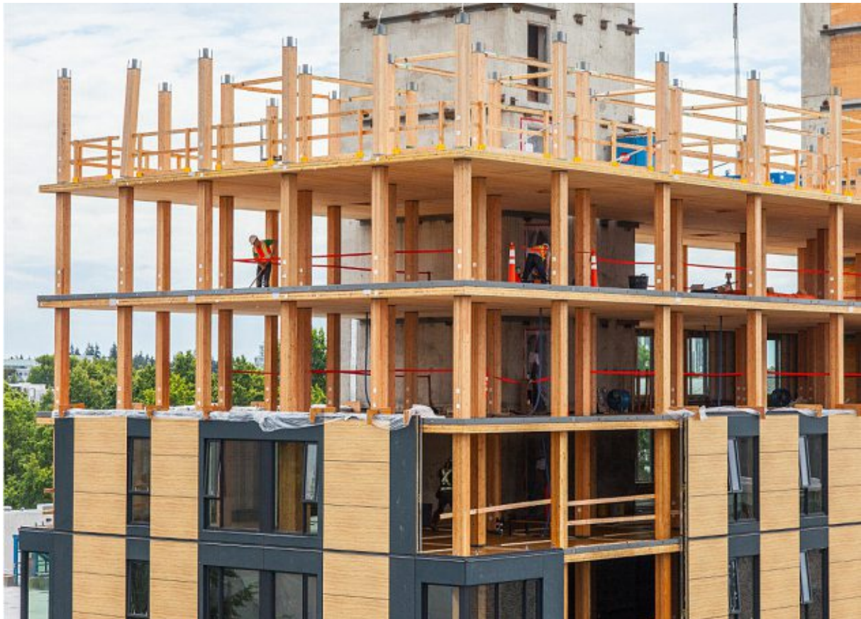
Abbildung 1: Das Tragwerk im Bau
