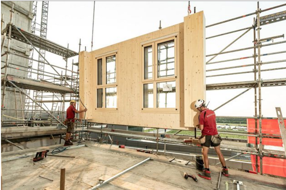
Abbildung 13-15: Montage der Bauteile
