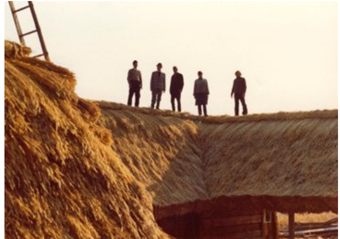
Abb. 97 | Feuertaufe nach Fertigstellung des Strohdaches
