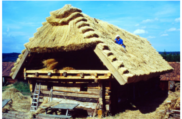
Abb. 148 | Fotoserie zum Strohecken des Wohnhauses aus Kroatisch-Tschantschendorf bei der Wiedererrichtung im Jahr 1996
