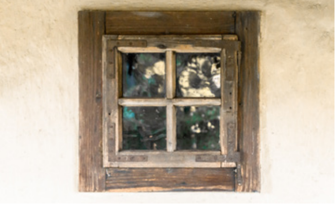
Abb. 123 | Fenster in der Rauchküche (rechts neben Eingang)
