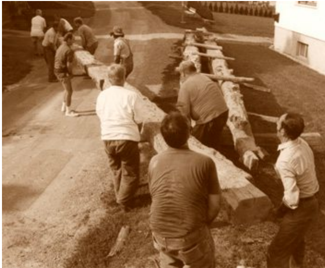
Abb. 124 | Abbau 1995: Abtragen der über 11 m langen Balken durch zehn Männer
