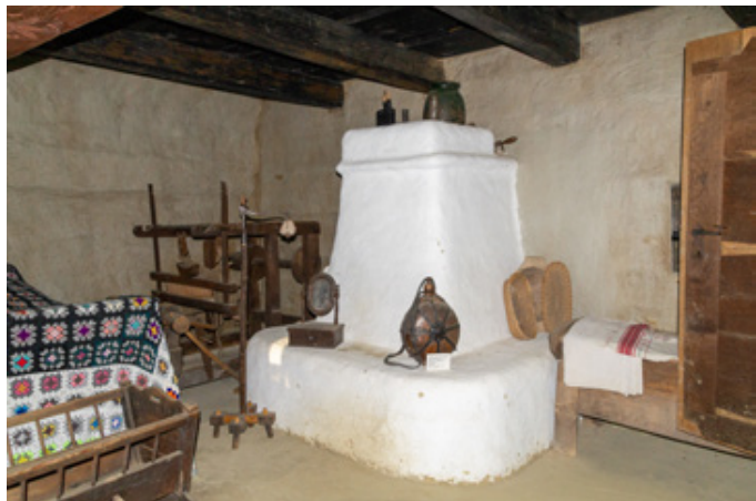
Abb. 137 | Der Ofen in der Stube (Beheizung über Rauchküche)
