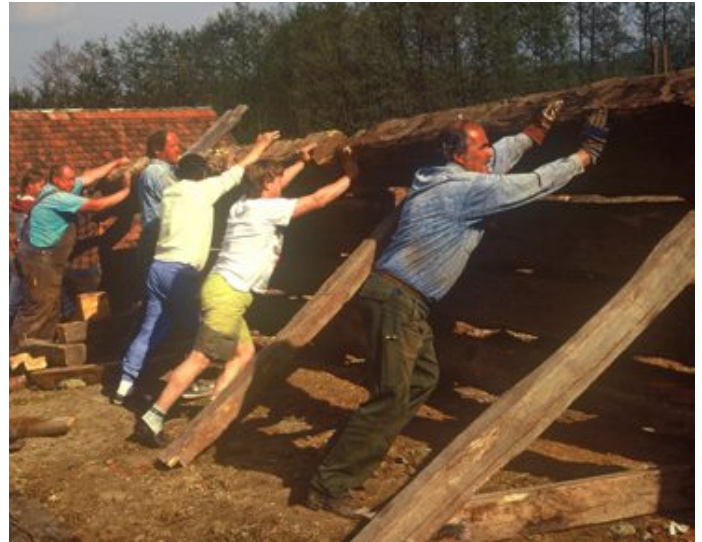
Abb. 125 | Wiederaufbau Herbst 1996: Die schweren Wandbalken werden per Hand aufeinander geschichtet
