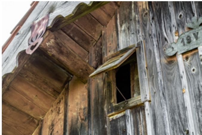
Abb. 81 | Lüftungsöffnung in der Holzbretterfasse des Giebels
