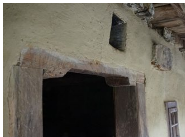
Abb. 129 | Rauchabzugsöffnung über der Eingangstür
