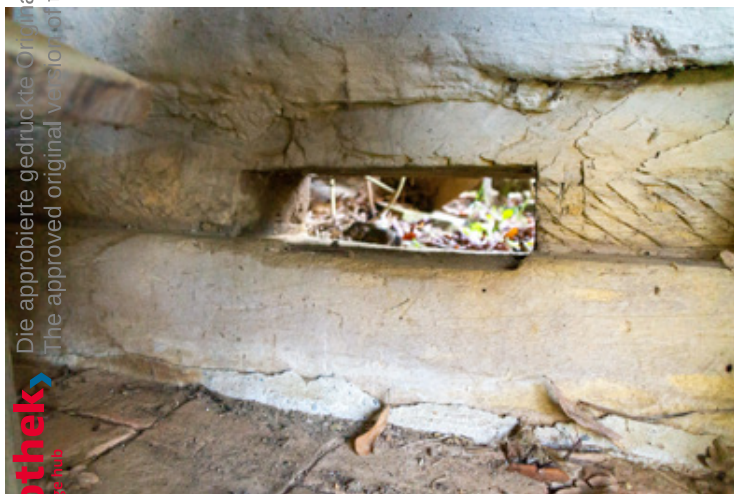
Abbildung 203 | Schlitz für die Einbringung des letzten Pfostens
