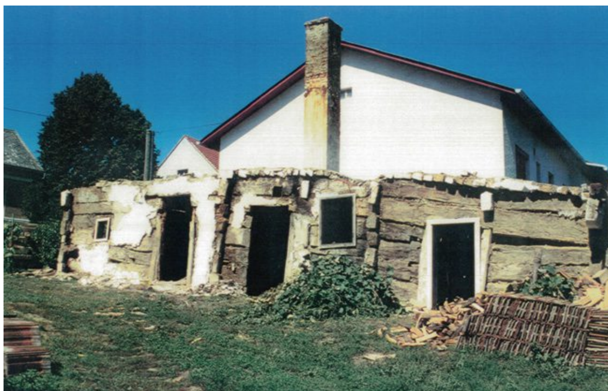
Abb. 124 | Das Wohnhaus an seinem ursprünglichen Standort in Kroatisch-Tschantschendorf während des Abbaus. In diesem Zustand ist gut zu erkennen, dass die Balken im hinteren Bereich (Kammer) abgesunken sind. Insbesondere der neue Türrahmen beim Eingang in die Kammer, welcher in die windschiefe Öffnung gesetzt wurde, zeigt das Gefälle. Das Fenster rechts der Eingangstür in die Rauchküche ist eine nachträgliche Vergrößerung es Urzustandes.
