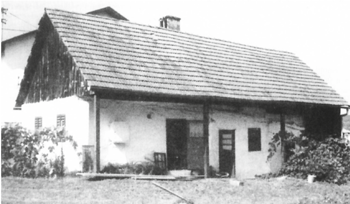
Abb. 141 | Ursprünglicher Standort: Fassade der Hofseite mit den Öffnungen des Wohnhauses (von links nach rechts): zwei Fenster an der Straßenfront, Stromkasten, Eingang in die Stube, Eingang in die Küche, Küchenfenster, Kammer
