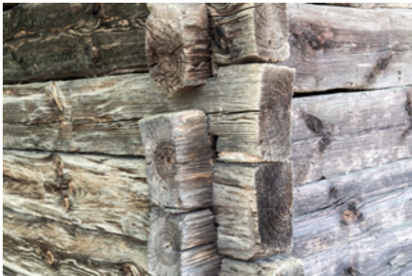
Abb. 26 | Typische Überkämmung beim Holzblockbau
