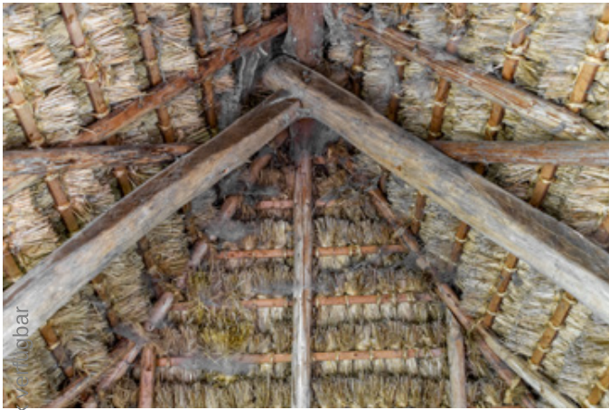
Abb. 116 | Zwei Lagen Strohschab bildet die Wand des Stadels
