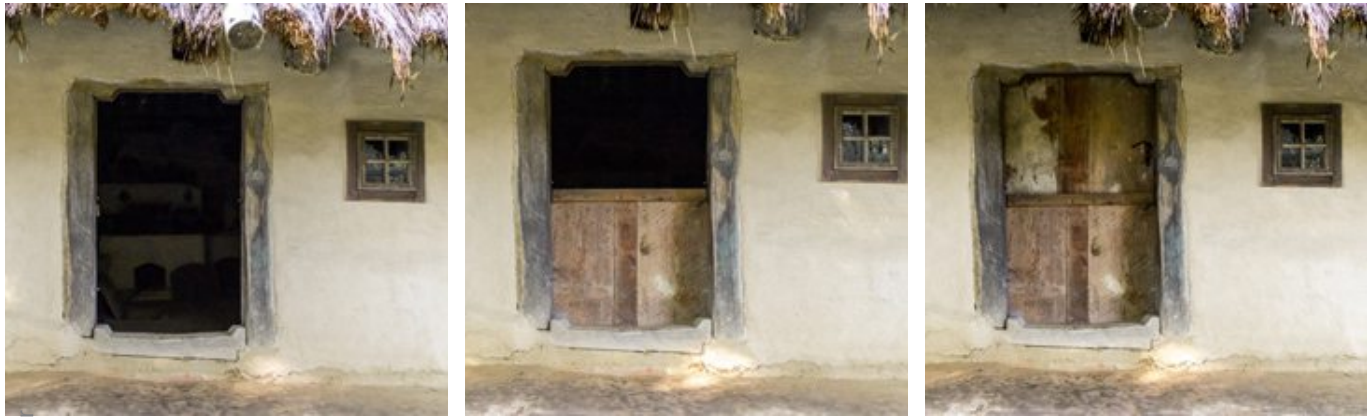
Abb. 142 | Teilbare Eingangstür in die Rauchküche (komplett geöffnet – nur oben offen – komplett geschlossen)
