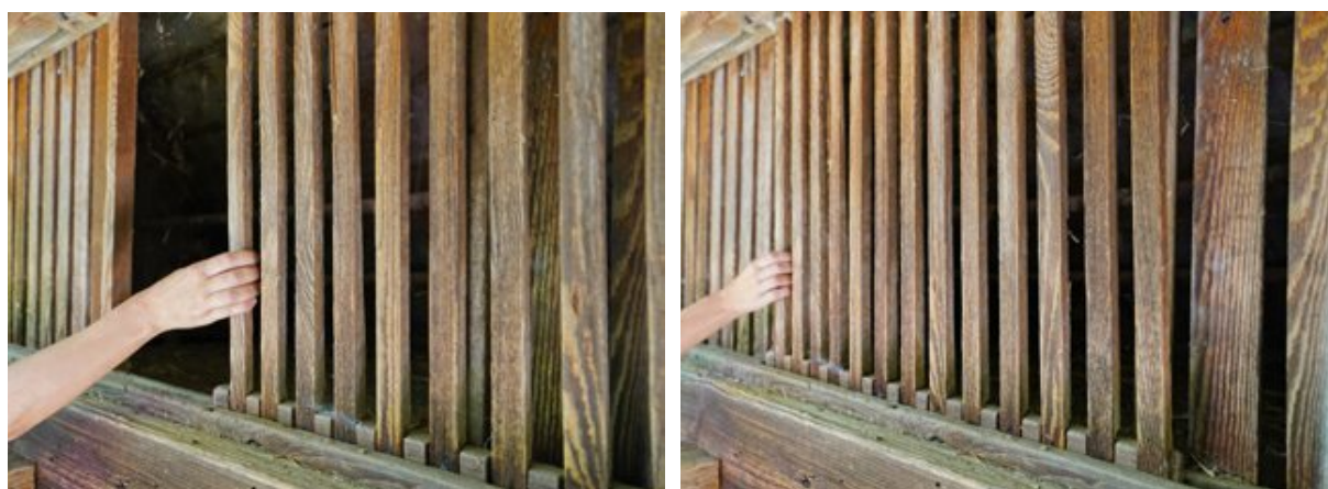
Abb. 277 | Verschiebbare Gittertür zum Hühnerstall über den Schweinkoben
