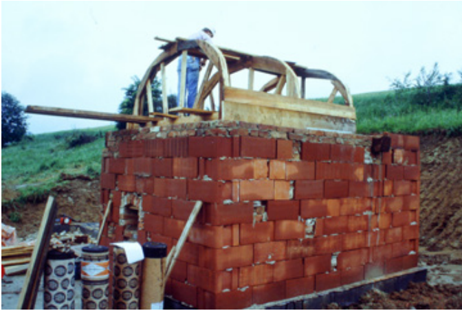
Abb. 64 | Wiedererrichtung der Rauchküche: Die Wände werden aus Hochlochziegeln hergestellt, darüber wird das Gewölbe über dem Küchenherd gemauert. Dafür braucht es ein temporäres Lehrgerüst.
