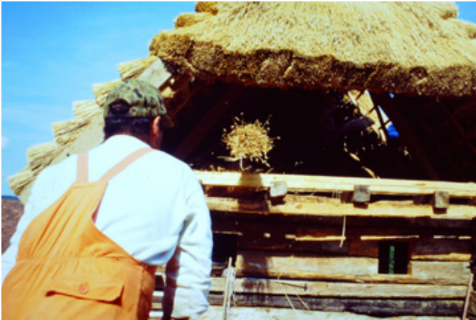
Abb. 148 | Fotoserie zum Strohecken des Wohnhauses aus Kroatisch-Tschantschendorf bei der Wiedererrichtung im Jahr 1996
