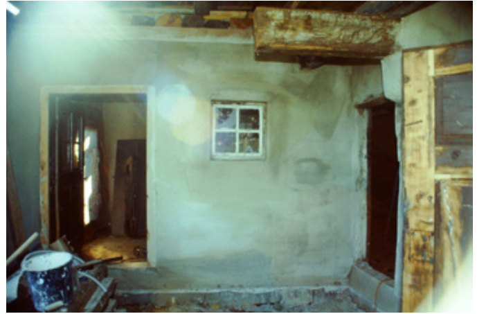
Abb. 64 | Wiedererrichtung der Rauchküche: Die Wände werden aus Hochlochziegeln hergestellt, darüber wird das Gewölbe über dem Küchenherd gemauert. Dafür braucht es ein temporäres Lehrgerüst.
