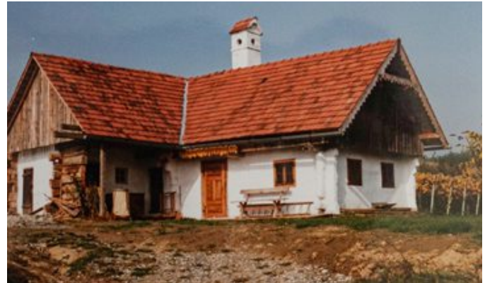
Abb. 76 | Aufbringung Lehmverputz und Anstrich mit Weißkalk
