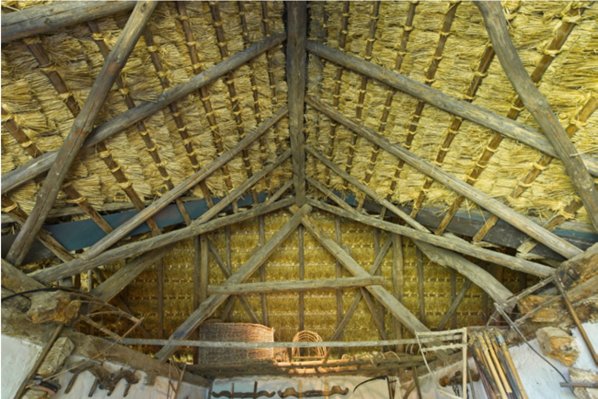
Abb. 206 | Scherendach (=Rofendach) des Kreuzstadels aus Großmüribisch
