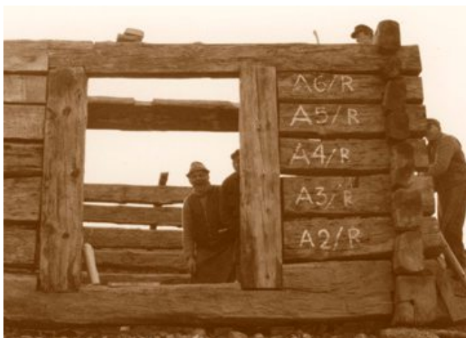
Abb. 159 | Wiedererrichtung 1979: Kennzeichnung der einzelnen Balken mit Kalkfarbe
