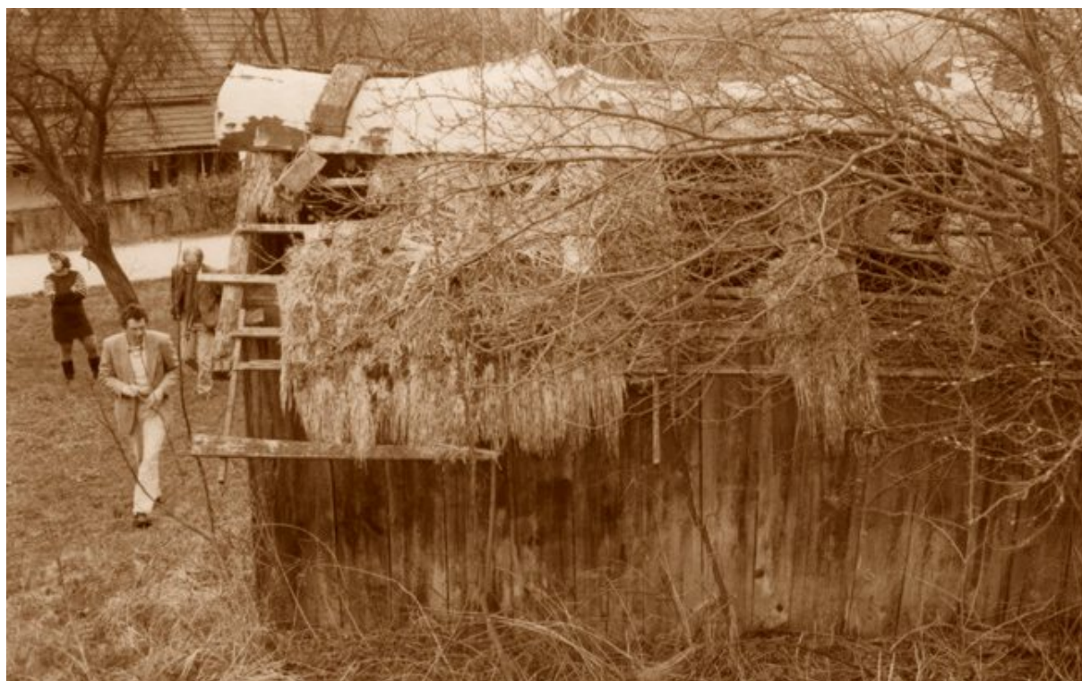
Abb.287 | Zustand des Bienenhauses bei der Erstbesichtigung 1994
