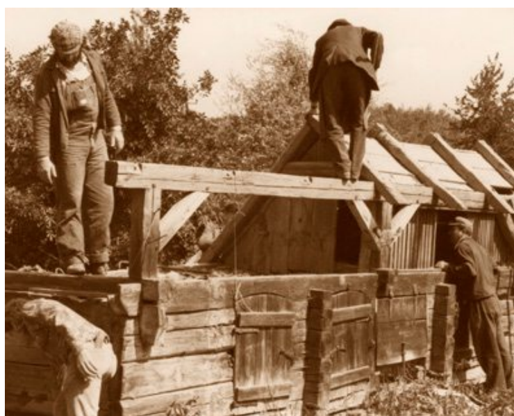
Abb. 266 | Viele Kleinteile machen die Wiedererrichtung aufwendig
