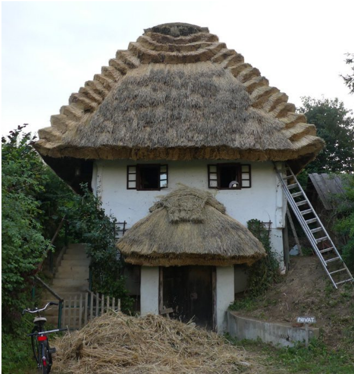
Abb. 35 | Kittelschab beim Presshaus aus Sumetendorf nach der Neueindeckung 2017
