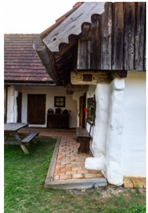
Abb. 84 | Gredn mit Ziegelpflasterung
