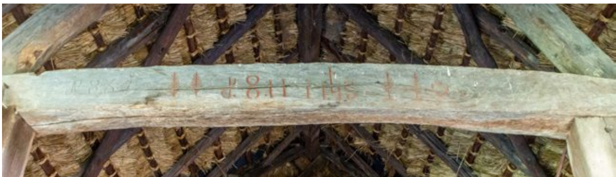
Abb. 191 | Torsturzbalken im Kreuzstadel von Großmürbisch
