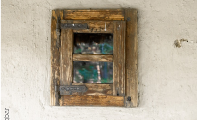
Abb. 122 | Fenster in der Stube von außen (entlang der Gredn )
