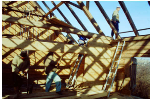
Abb. 42 & 43 | Längsstadel aus Urbersdorf: Wiedererrichtung im Freilichtmuseum - Aufschlagen des Dachstuhl
