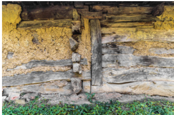
Abb. 27 | Nachträglicher Anbau eines Raumes
