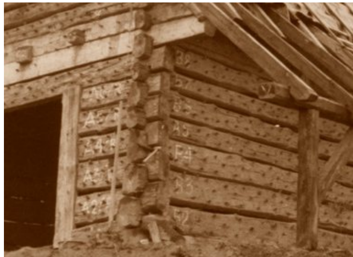
Abb. 176 | Rohbau des Kittings, versehen mit Löchern für Holznägel, welche als Putzträger für die besonders dicke Lehmschicht dienen
