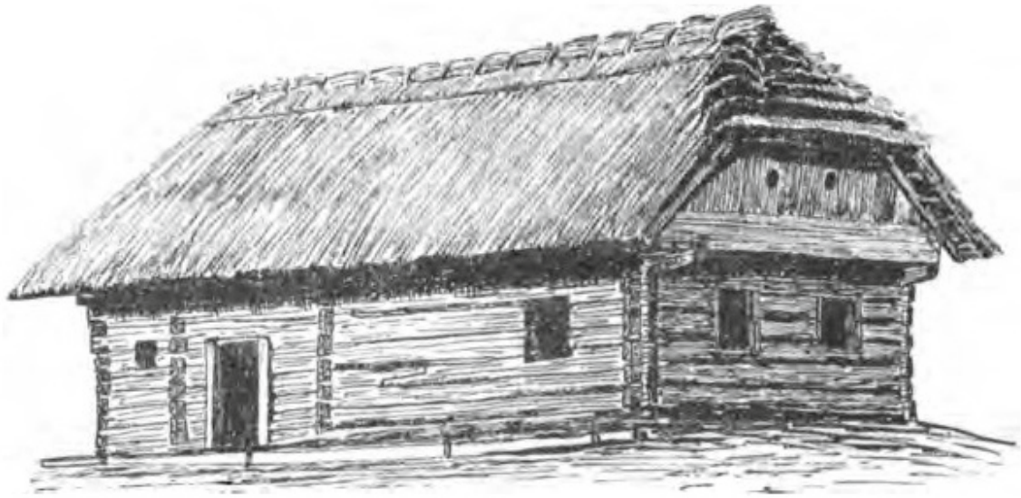
Abb. 28 | Beispiel eines Wohnhauses in typischer Holzblockbauweise in Litzelsdorf bei Stegersbach, das sich gerade im Bau befand (Ende des 19. Jahrhunderts), dokumentarisch festgehalten und publiziert von Johann Reinhard Bünker.
