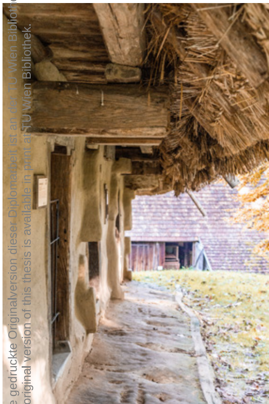
Abb. 149 | Gredn (Dachvorsprung und Stampflehm)
