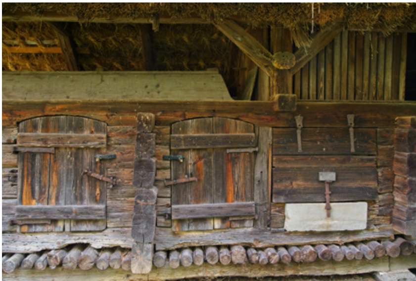
Abb. 278 | Detailansicht (jüngere Hälfte 1932) Türen und Stangenboden
