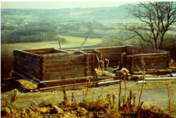
Abb. 42 & 43 | Längsstadel aus Urbersdorf: Wiedererrichtung im Freilichtmuseum - Aufschlagen des Dachstuhl
