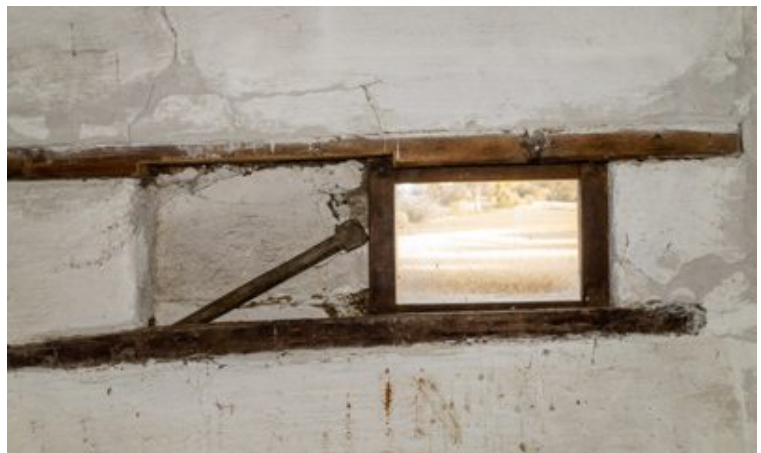
Abb. 104 | Fenster in der Stube (straßenseitig) in ursprünglicher Größe und Funktionsweise (Schiebefenster)
