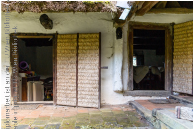
Abb. 109 | Strohtür: Eingang in Kammer und ehemaligen Stall
