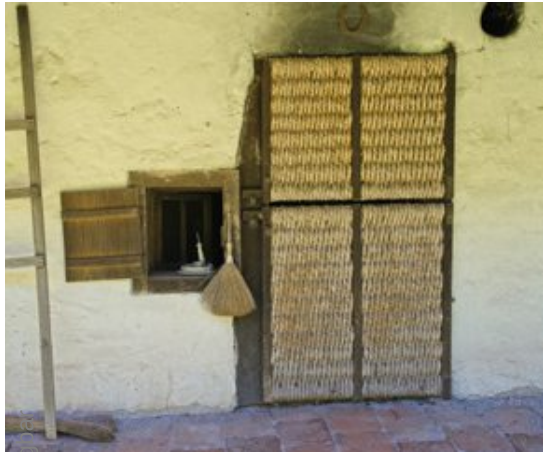
Abb. 106 | Strohtür Eingang in die Raucküche
