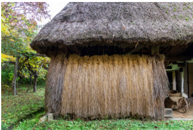
Abb. 114 | Zwei Lagen Strohschab bildet die Wand des Stadels
