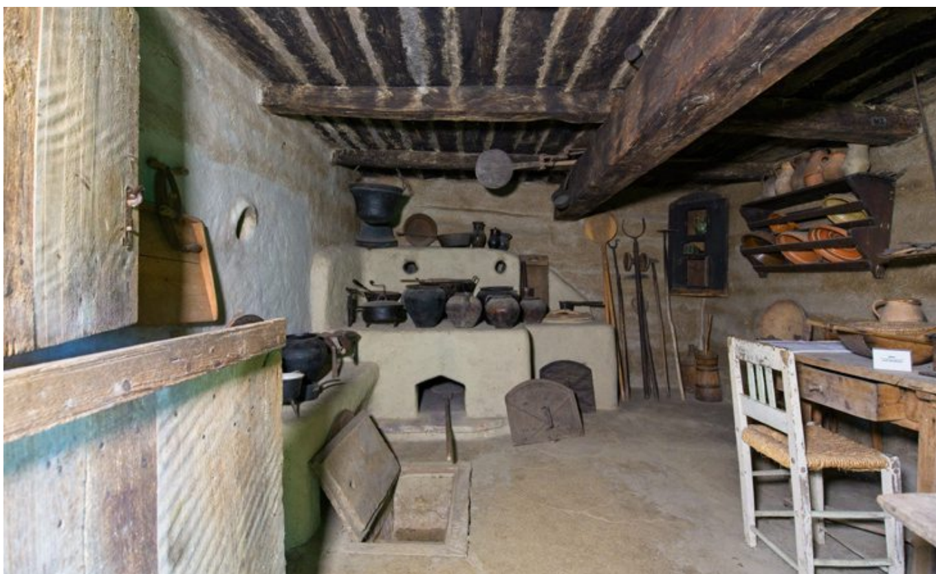
Abb. 131 | Nachbildung der Rauchküche des Wohnhauses aus Kroatisch-Tschantschendorf: Der Ofen befindet sich an der Zwischenwand zur Stube. An der Wand vor dem Ofen befindet sich eine weitere Heizöffnung, von der aus der Kachelofen in der Stube mitgeheizt werden konnte. Die verschließbare Vertiefung im Boden direkt vor dem Ofen diente dazu, das Brot besser in die untere Öffnung des Ofens schießen zu können. Die weiteren Öffnungen im Ofen waren zur Rauchentweichung notwendig.
