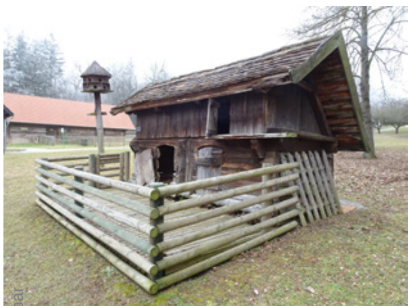
Abb. 275 | Schweineestall aus Deutsch-Gerisdorf
