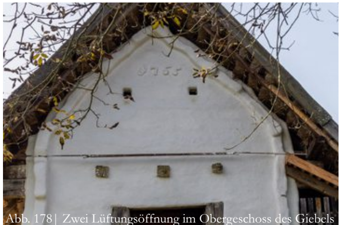
Abb. 178 | Zwei Lüftungsöffnung im Obergeschoss des Giebels
