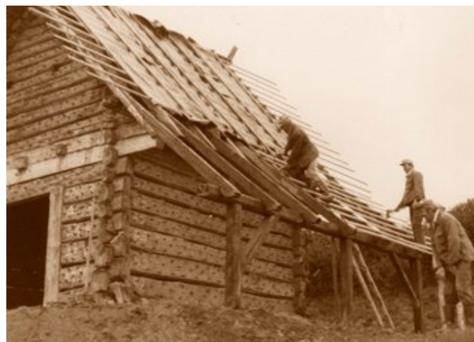
Abb. 159 | Wiedererrichtung 1979: Kennzeichnung der einzelnen Balken mit Kalkfarbe
