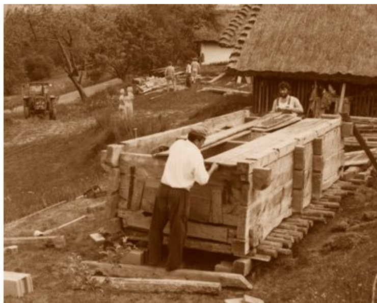
Abb. 265 | Die ersten drei Koben der rechten Hälfte sind fast fertig
