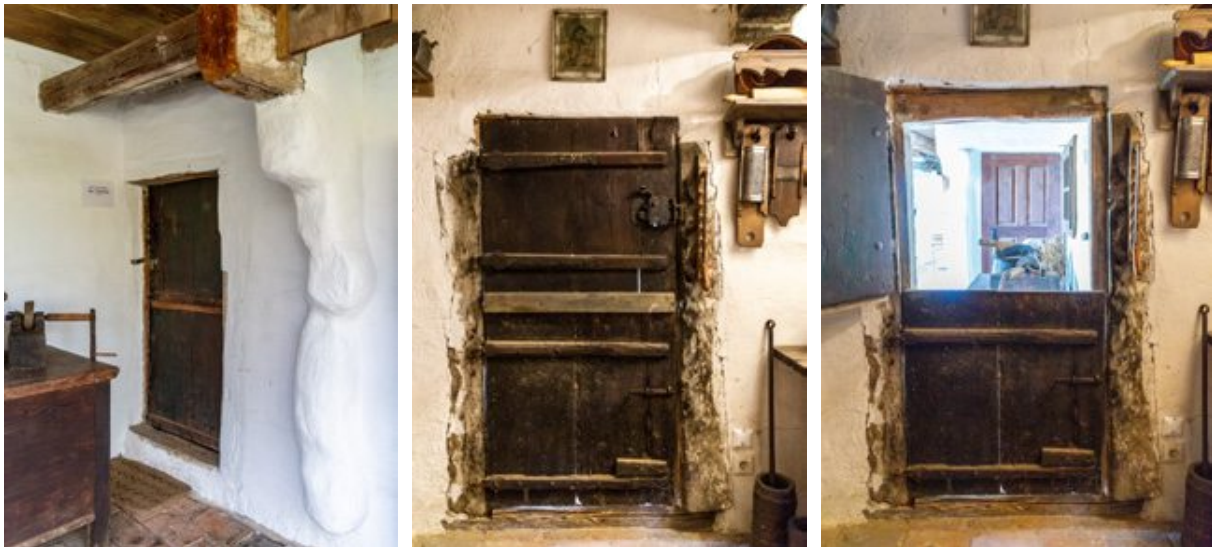
Abb. 70 & 71 & 72 | Eingangstür in die Rauchstube (von außen - von innen - halb geöffnet)
