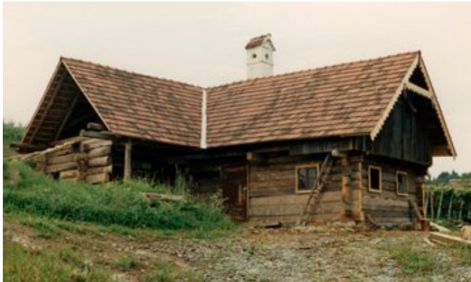
Abb. 75 | Rohbau des Holzblockbaus bei der Wiedererrichtung
