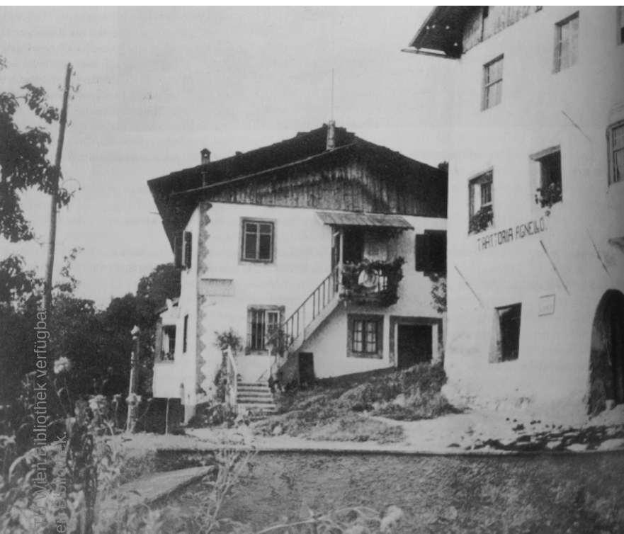
15 Die beiden Gasthäuser Lamm und Rössl 1930
