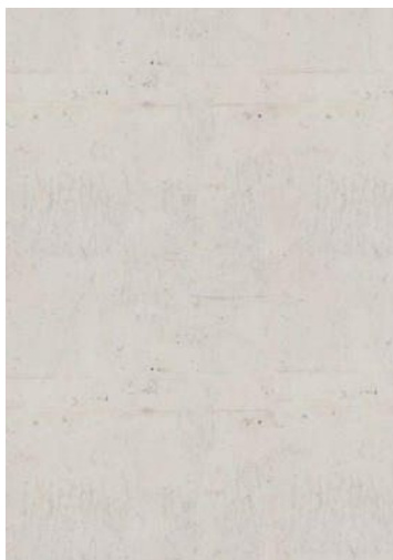
Fassadenverkleidung Sockel Lehmputz - hell / naturbelassen
