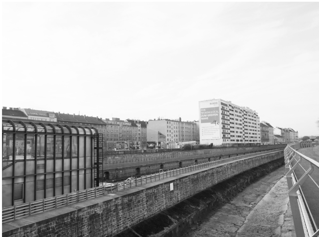
2 | Blick von der Fußgängerbrücke
