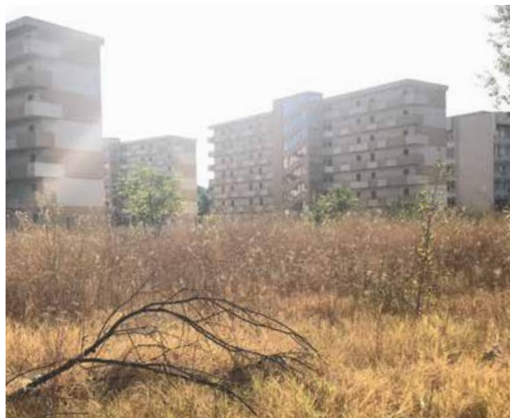
Abb. 38 Vier neue Studentenwohnheime befinden sich nördlich des Universitätsgebäudes
