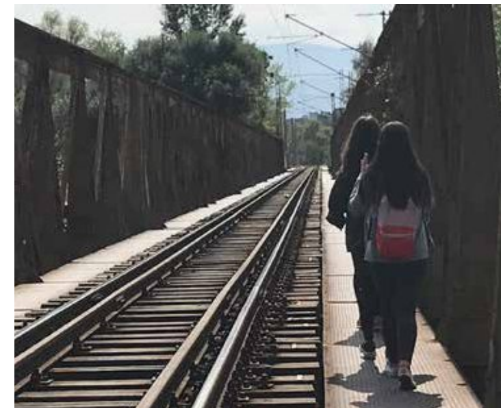
Abb. 56 Schüler*innen überqueren regelmäßig die Eisenbahnbrücke
