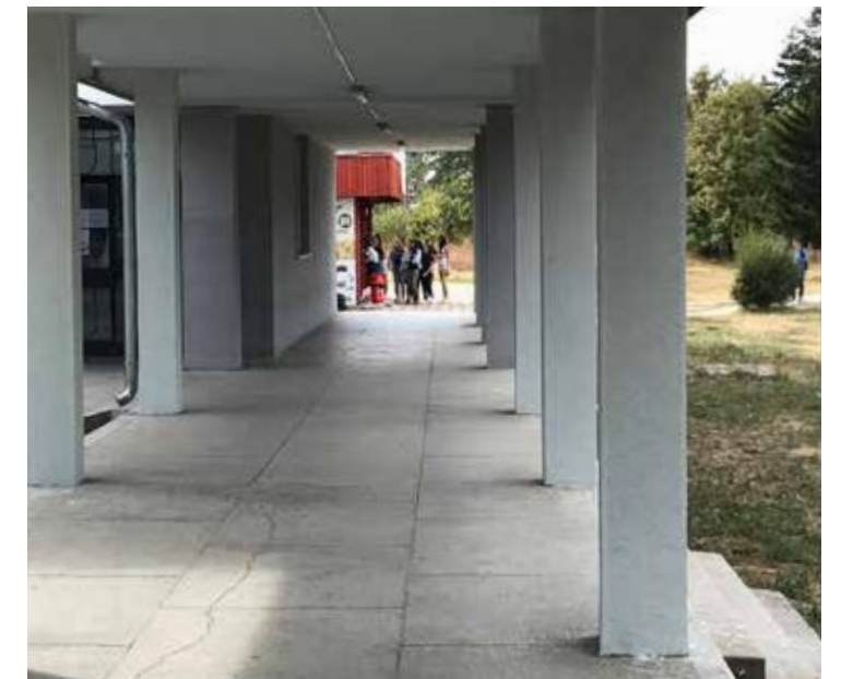
Abb. 65 In der Erdgeschosssebene der Wohnheime befinden sich die Unterrichtsräume der Schüler des ersten Jahrgang
