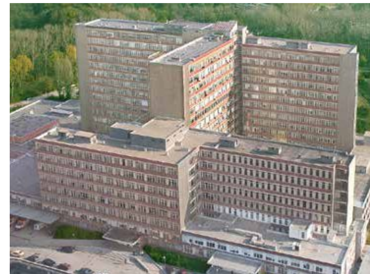
Abb. 32 Trotz der imposanten Erscheinung des Krankenhauses ist größtenteils der Fläche unfunktional
