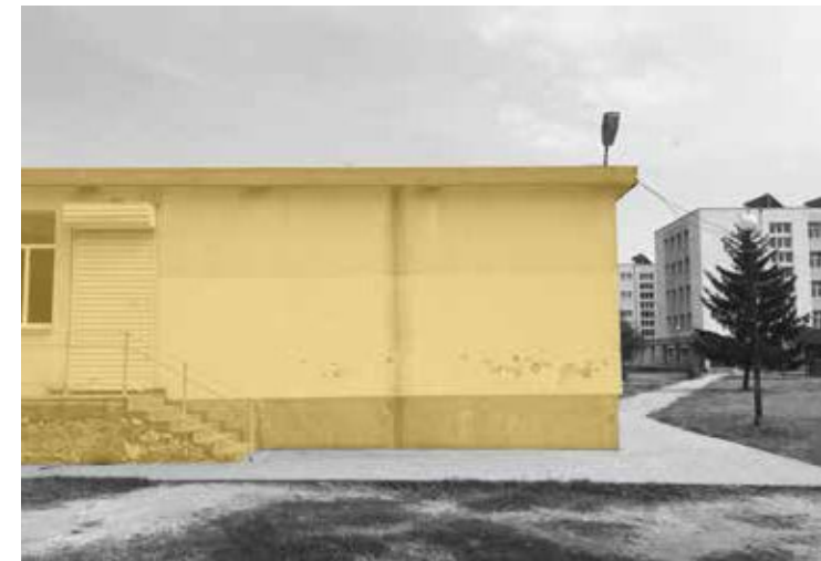
Abb. 77 Teil des niedrigen Daches des Sprachgymnasium "Iwan Wazow"
