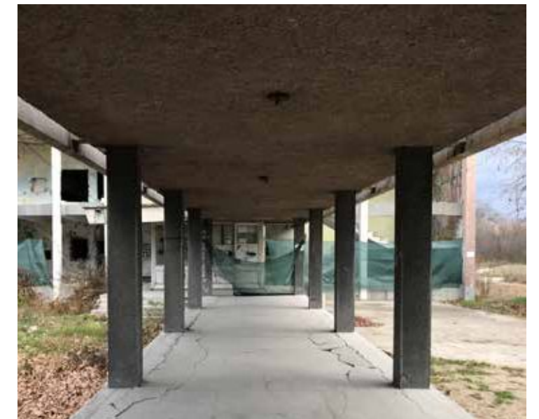
Abb. 66 Am Ende dieses Gang befindet sich die Ruine der ehemalige Kanine
