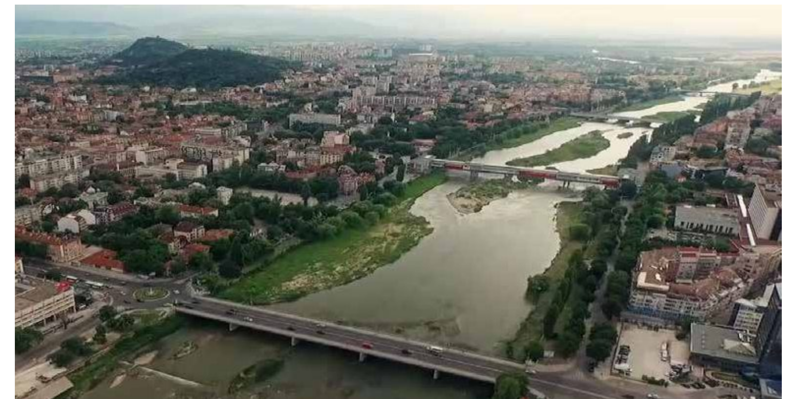
Abb. 25 Von Nah nach Fern: die Messe-Brücke, die Fußgängerbrücke, die "Gerdzika"-Brücke, die "Wasil Aprilow"-Brücke und die Eisenbahnbrücke
