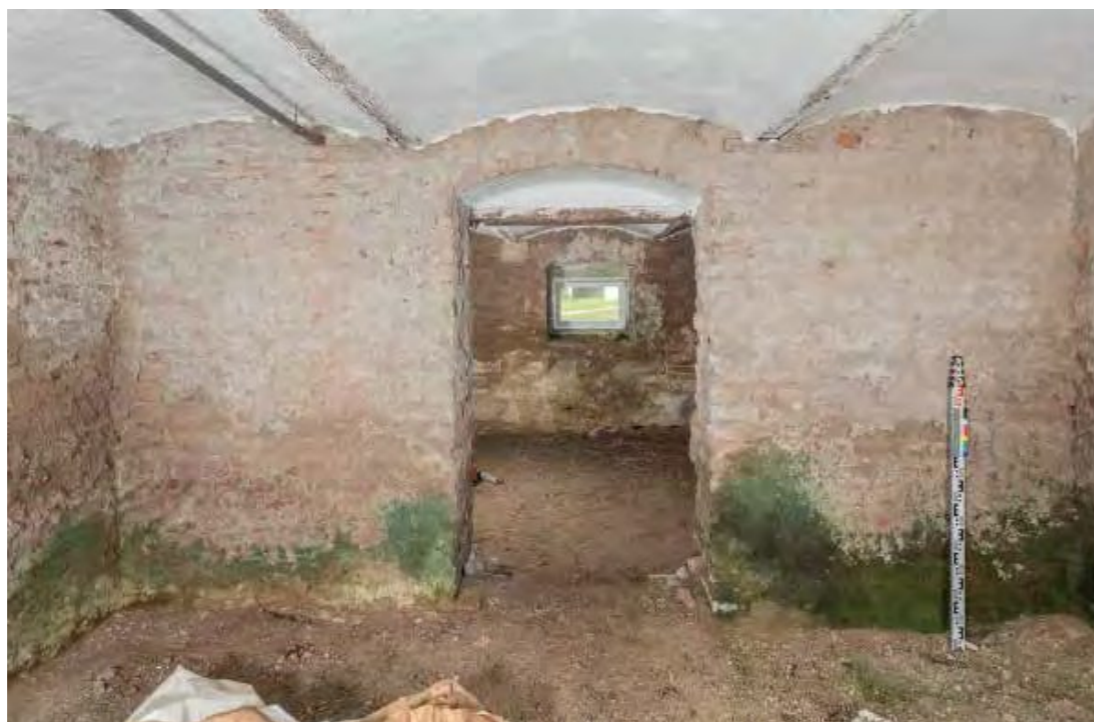
Abb.78: Ein Kellerraum im Abschnitt des Südtraktes, wo sich die Forstverwaltung befindet.
