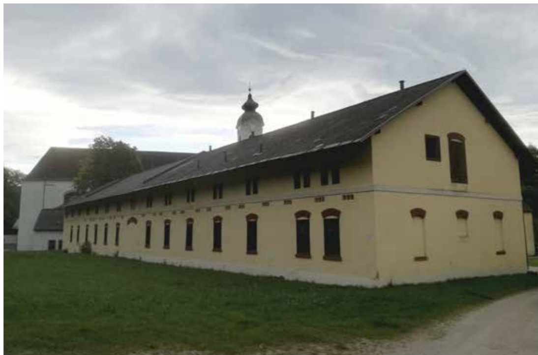
Abb.82: Ostfassade des Rinderstalls, 2020.
