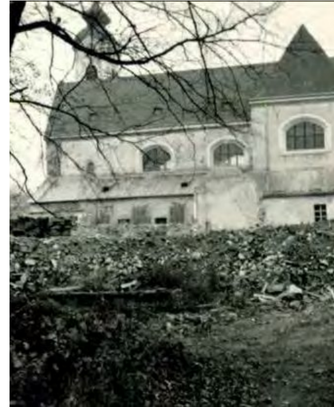
Abb.27: Der Schloßtrakt beim Abbruch, 1965.
