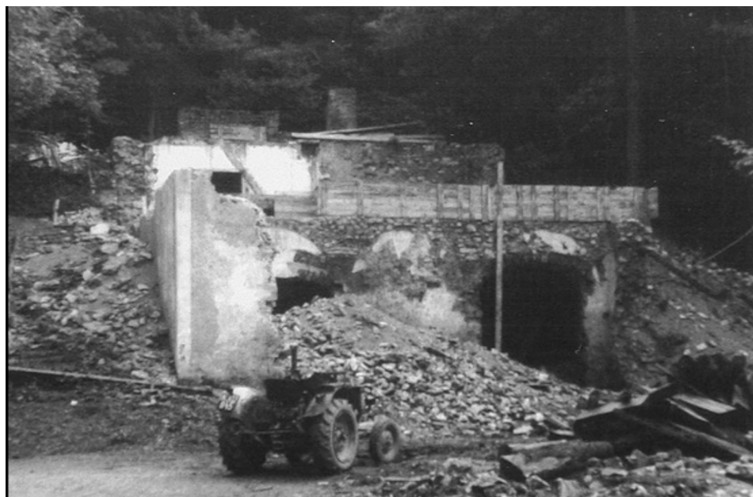
Abb.34: Der Stiftskeller während des Abbruchs um 1965.
