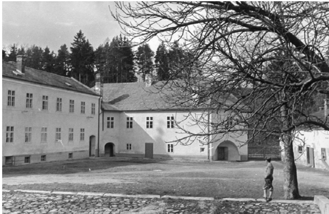
Abb.70: Der noch aus Klosterzeiten stammende Trakt, 1960.
