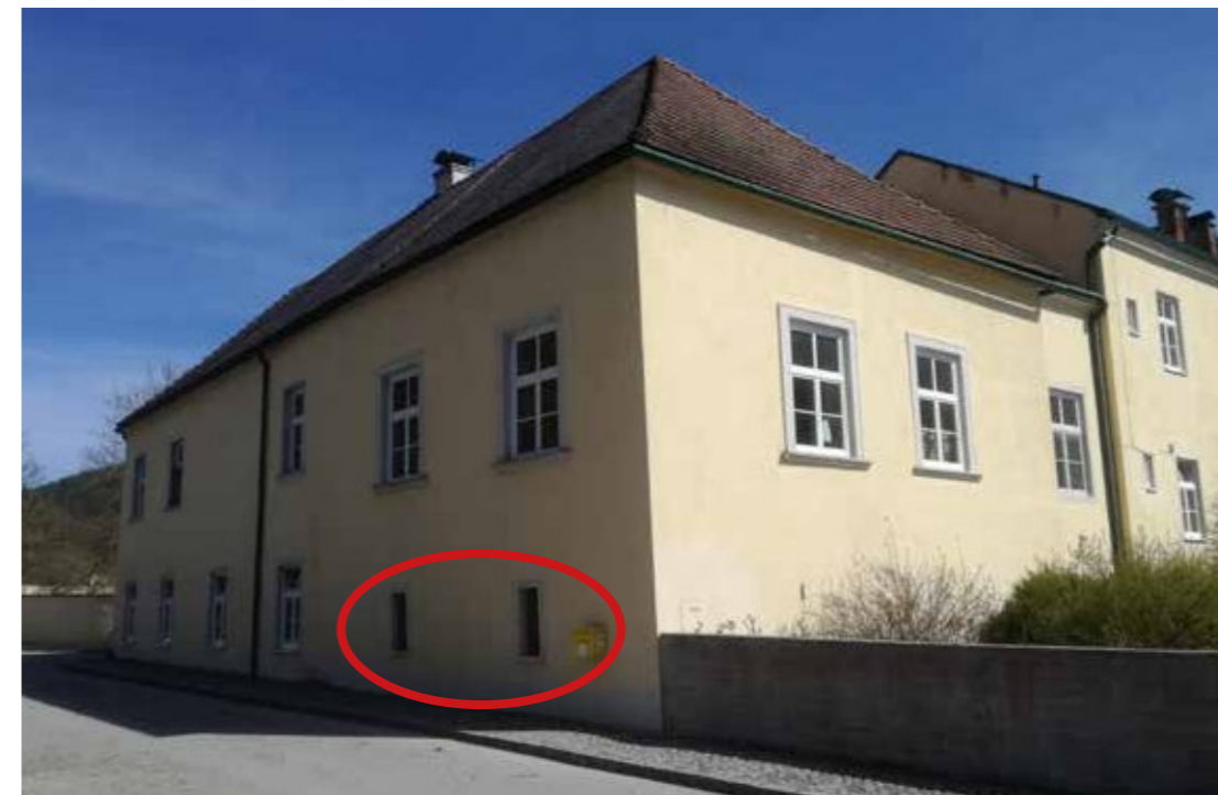
Abb.73: Zwei kleine hochrechteckige Fensteröffnungen zur Belichtung des Kellergeschosses an der Westfassade.
