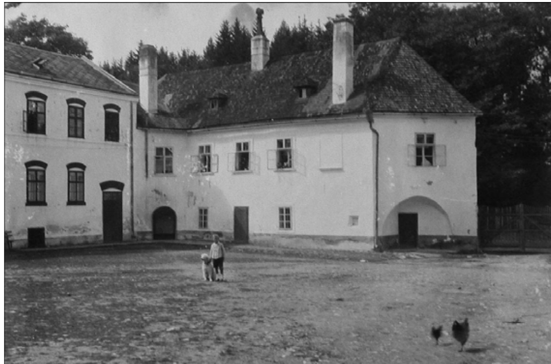
Abb.68: Der noch aus Klosterzeiten stammende Trakt, 1930.
