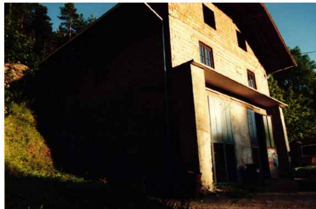
Abb.35: Die Außenansicht des Stiftkellers 1990.
