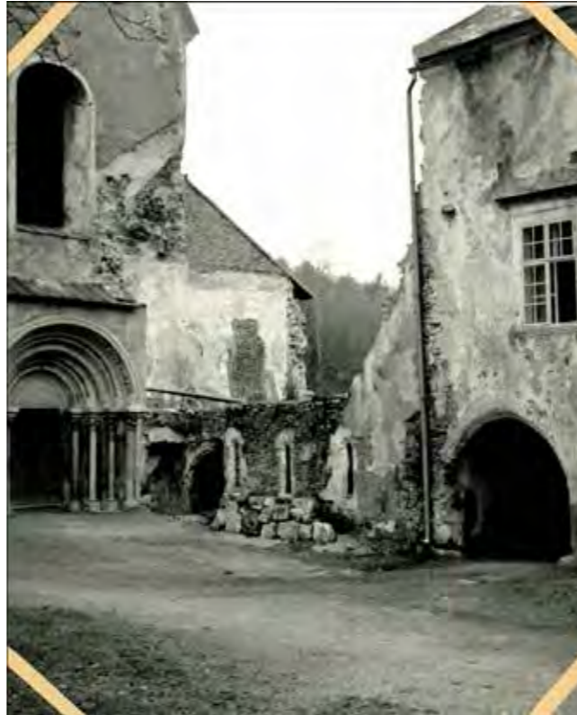
Abb.26: Kirchhof während des Abbruchs, 1967.
