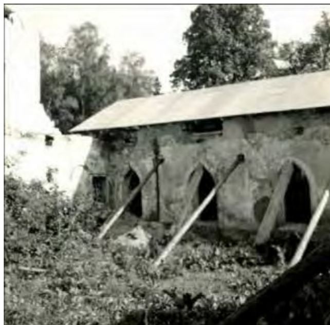
Abb.28: Kreuzgang während des Abbruchs, 1967.
