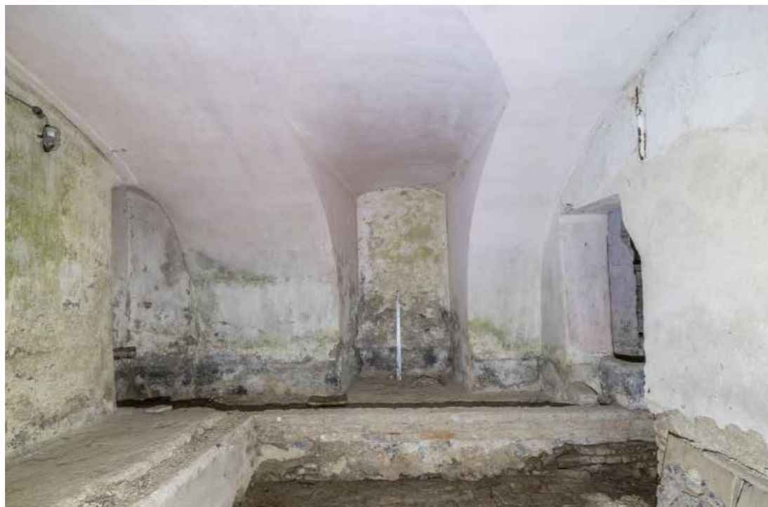
Abb.72: Ein Kellerraum mit einem aus dem Mittelalter erhaltenen Tonnengewölbe mit langgestreckten Stichkappen, in der Neuzeit als Käserei genutzt wurde.
