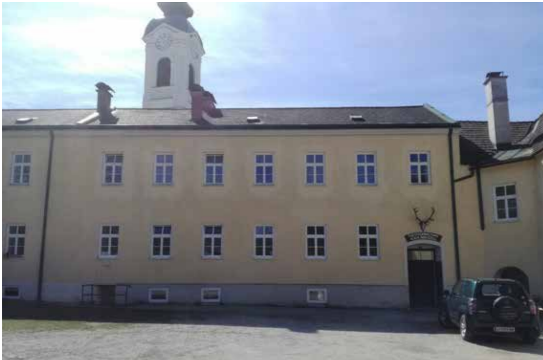
Abb.74: Der noch aus Klosterzeiten stammende Trakt, 1930.
