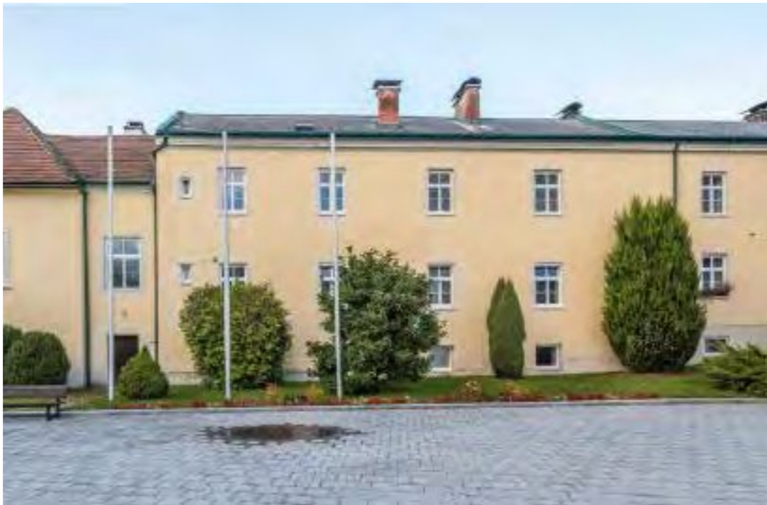
Abb.75: Die Südfassade der Forstverwaltung.
