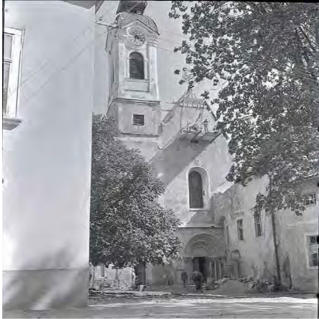
Abb.57: Die Basilika während ihrer Renovierung, 1957.
