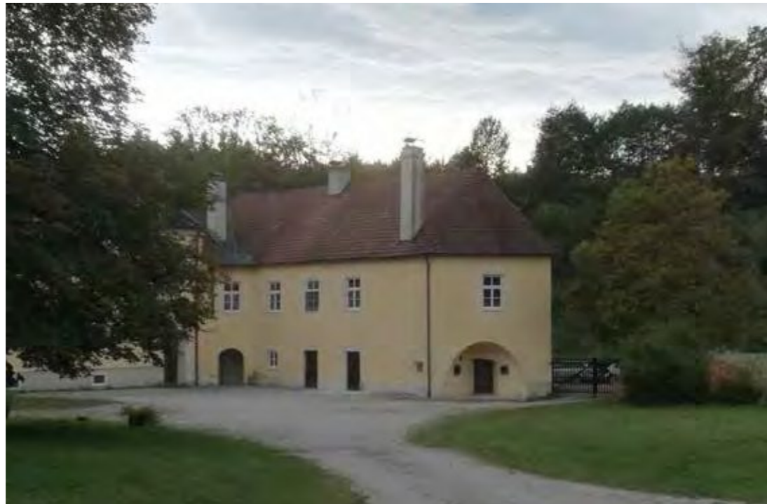
Abb.69: Der noch aus Klosterzeiten stammende Trakt, 2020.
